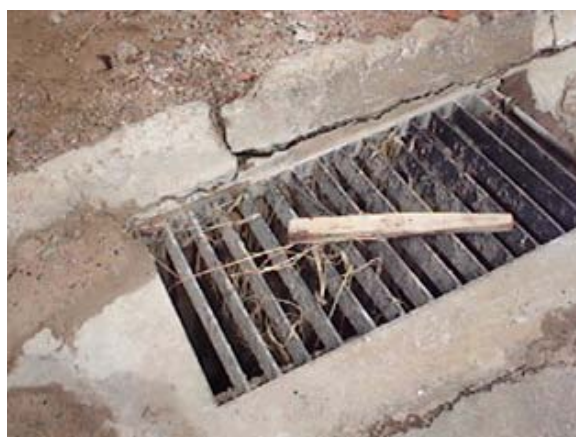
FOTO B.7.47 e B.7.48. Material de construção carregado na boca-de-lobo (foto da autora)
