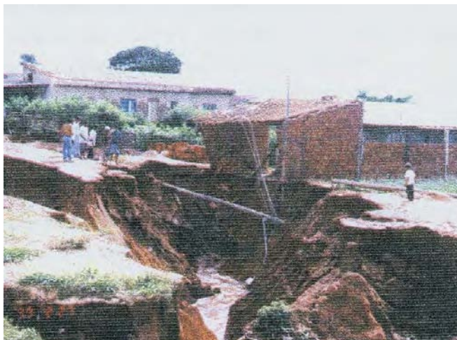
FOTO B.6.26. Residência na Rua 1 em condição de risco (GASPAR,2000)
