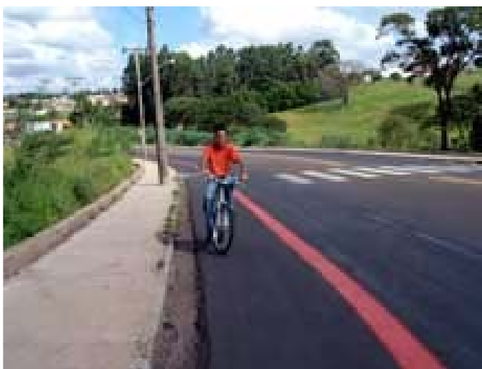
FOTO B.5.8. Faixa vermelha sinalizando ao ciclista o local seguro para a subida (SÃO CARLOS, 2006b).
