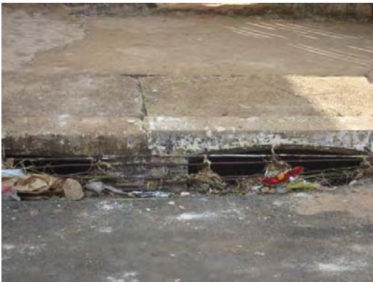
FOTOS B.6.41 e B.6.42. Bocas-de-lobo deterioradas e com entradas obstruídas por resíduos sólidos (fotos da autora)
