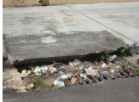
FOTOS B.1.28 e B.1.29. Lançamento de resíduos e materiais indevidos nas bocas-de-lobo (fotos da autora)
