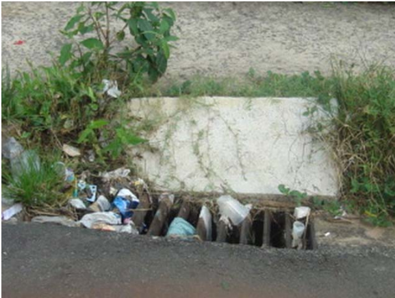
FOTO B.5.45 e B.5.46. Bocas-de-lobo com presença de resíduos sólidos (lixo) e obstruídas (fotos da autora)
