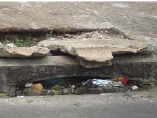
FOTOS B.6.43 e B.6.44. Bocas-de-lobo deterioradas e com entradas obstruídas por resíduos sólidos (fotos da autora)
