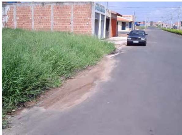
FOTOS B.3.21 e B.3.22. Material inerte (areia) obstruindo a passagem da água pluvial pelas guias e sarjetas (fotos da autora)
