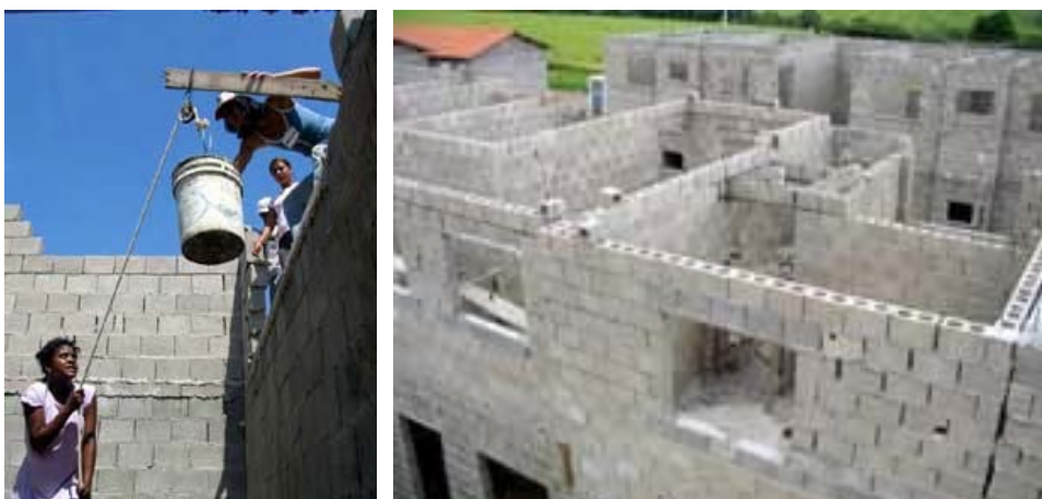
FOTO B.4.31 e B.4.32. Mutirão do projeto Carta de Crédito FGTS – Imóvel na Planta (SÃO CARLOS, 2006c; SÃO CARLOS, 2006e).
