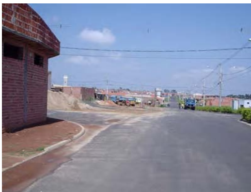
FOTOS B.3.23 e B.3.24. Material inerte (areia) obstruindo a passagem da água pluvial pelas guias e sarjetas (fotos da autora)
