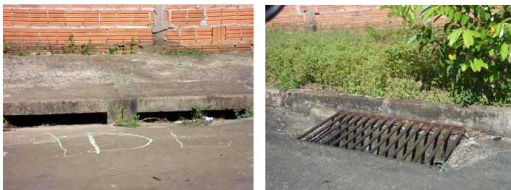
FOTO B.2.42 e B.5.43. Boca-de-lobo vertical e lateral (foto da autora)
