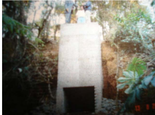
FOTO B.7.37 e B.7.38. Caixa de dissipação de energia implantada (SÃO PAULO, 2002a).
