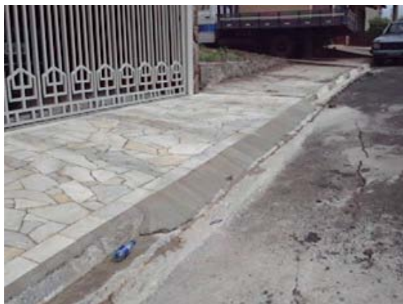
FOTO B.7.43 e B.7.44. Obstrução das guias e sarjetas por rampas para entrada de veículos (foto da autora)
