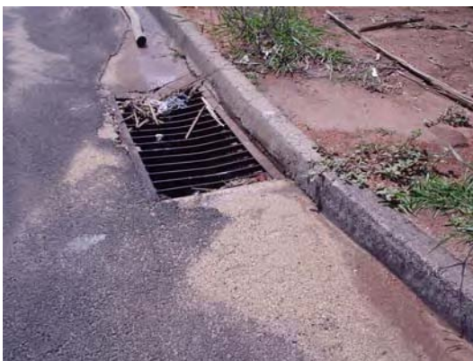
FOTOS B.3.27 e B.3.28. Material inerte (areia) na boca-de-lobo (fotos da autora)
