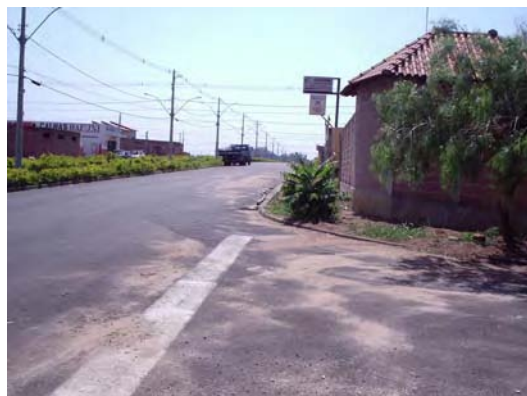
FOTOS B.3.23 e B.3.24. Material inerte (areia) obstruindo a passagem da água pluvial pelas guias e sarjetas (fotos da autora)
