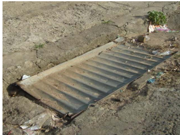
FOTO B.5.45 e B.5.46. Bocas-de-lobo com presença de resíduos sólidos (lixo) e obstruídas (fotos da autora)
