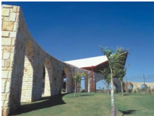
FOTO B.8.8. Entrada do empreendimento com pedra (ENCALSO, 2007)
