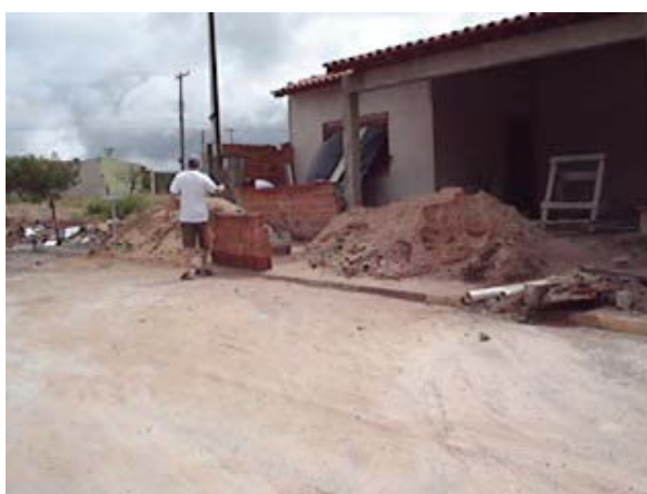
FOTO B.7.45 e B.7.46. Obstrução das guias e sarjetas por material de construção e entulho (foto da autora)
