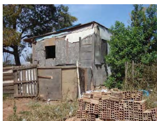
FOTOS B.6.29 e B.6.30. Casas construídas com entulhos (fotos da autora).
