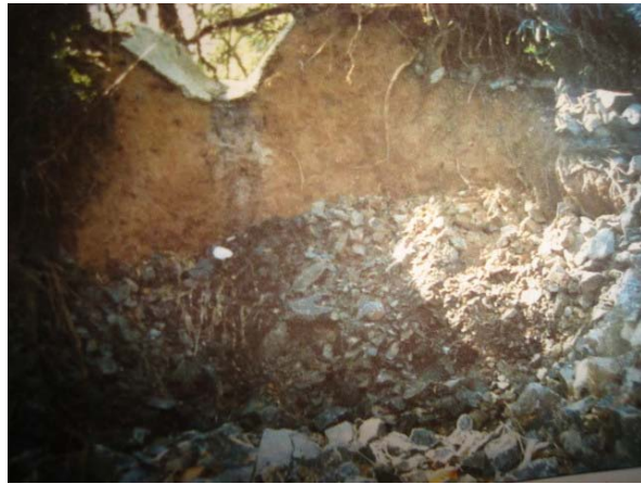
FOTO B.7.36. vista da proteção com rachão à saída da canaleta (SÃO PAULO, 2002a).
