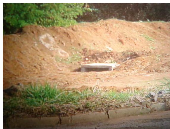
FOTO B.7.41. Vista da estrutura de captação junto ao terraceamento (SÃO PAULO, 2002a).
