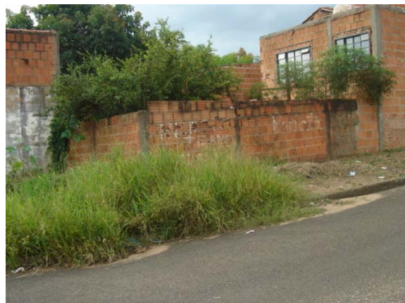
FOTO B.5.47 e B.5.48. Guias e sarjetas obstruídas (fotos da autora)
