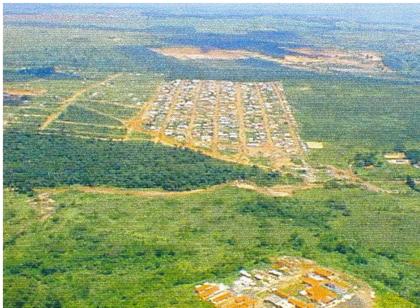
FOTO B.6.1. Ruas 01 a 07 (extensas), implantadas na direção perpendicular às curvas de nível, o que contribuiu para o processo erosivo e assoreamento do córrego Água Quente. Foto tirada em 01/04/1999. (GASPAR, 2000).
