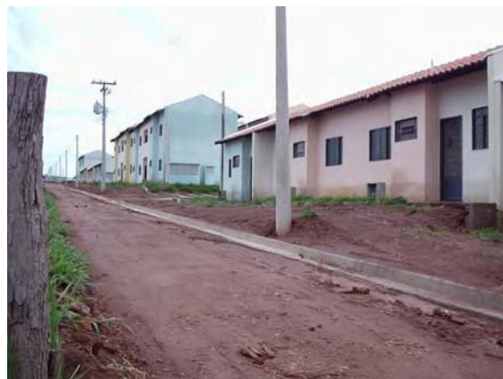
FOTO B.4.11. Rua longitudinal no setor das casas populares com guia e sarjeta (foto da autora)
