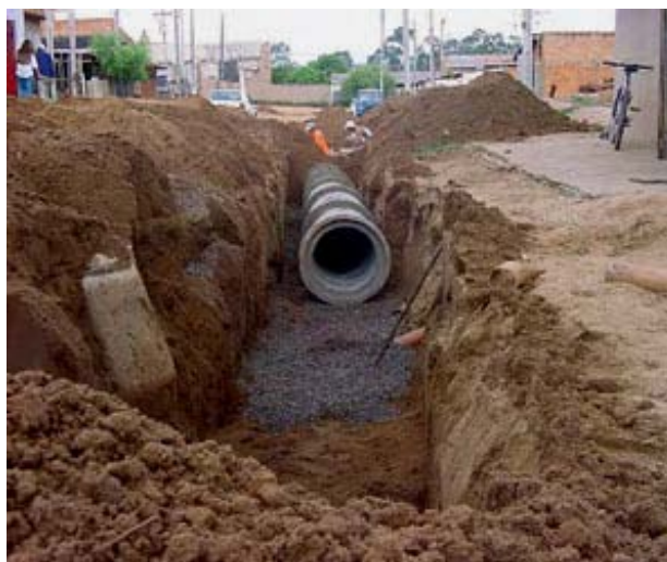
FOTO B.5.44. Reconstrução das galerias de águas pluviais (SÃO CARLOS, 2004)
