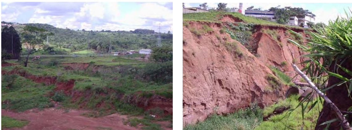
FOTOS 5.1 e 5.2. Voçoroca formada pela falta de drenagem urbana (foto da autora, 2005)
