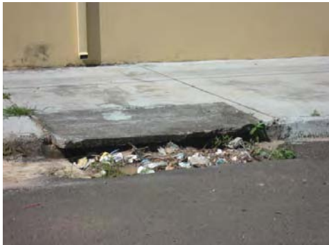
FOTOS B.1.28 e B.1.29. Lançamento de resíduos e materiais indevidos nas bocas-de-lobo (fotos da autora)
