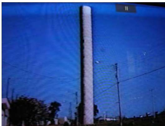
FOTO B.2.37. Reservatório elevado situado no Conjunto Habitacional Maria Estela Fagá (KONDOR, 1996).
