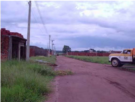
FOTO B.4.44. Rua longitudinal sem guia e sarjeta (foto da autora)
