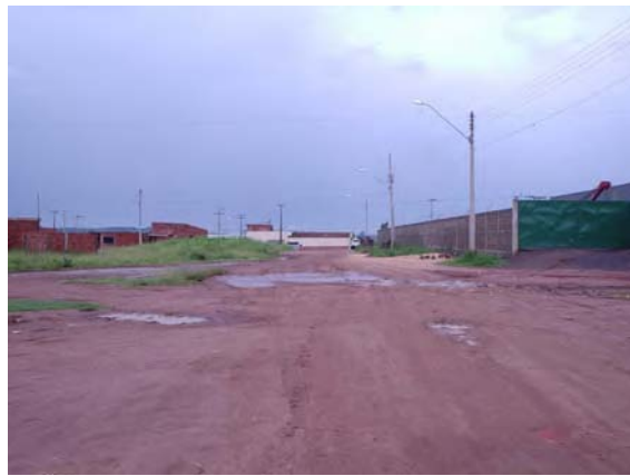
FOTO B.4.43. Rua transversal sem guia e sarjeta (foto da autora)
