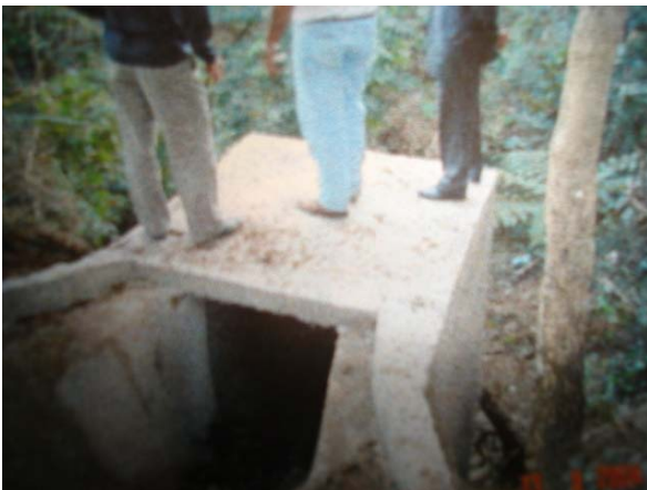
FOTO B.7.37 e B.7.38. Caixa de dissipação de energia implantada (SÃO PAULO, 2002a).
