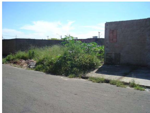
FOTO B.2.50. Guias e sarjetas obstruídas por vegetação (foto da autora)
