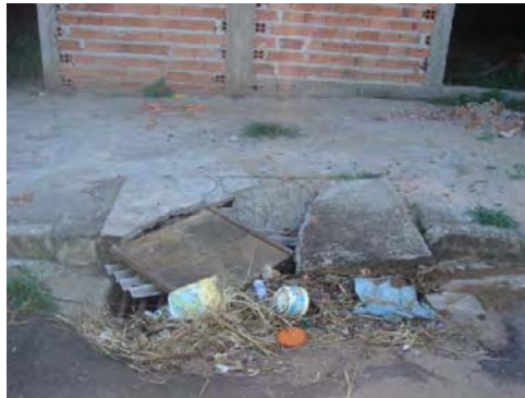
FOTO B.1.30 e B.1.31. Bocas-de-lobo deterioradas e com presença de resíduos sólidos (fotos da autora)
