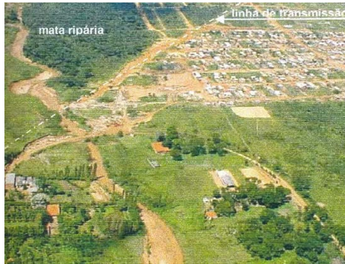
FOTO B.6.27. Foto aérea mostrando a localização da linha de transmissão, da mata ripária e do assoreamento do córrego Água Quente. Foto de 01/04/1999. (GASPAR, 2000)
