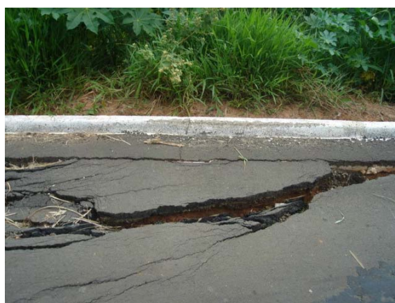
FOTO B.5.9 e B.5.10. Processo erosivo na ciclovia da avenida Integração (fotos da autora).
