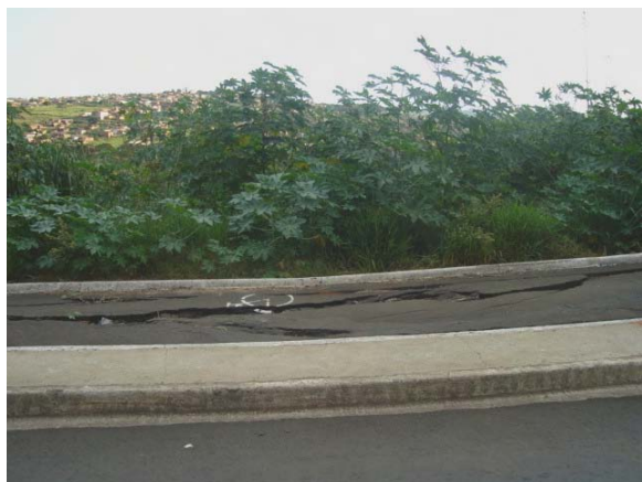
FOTO B.5.9 e B.5.10. Processo erosivo na ciclovia da avenida Integração (fotos da autora).
