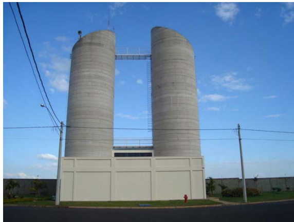
FOTO B.9.12. Reservatório de água potável (foto da autora).
