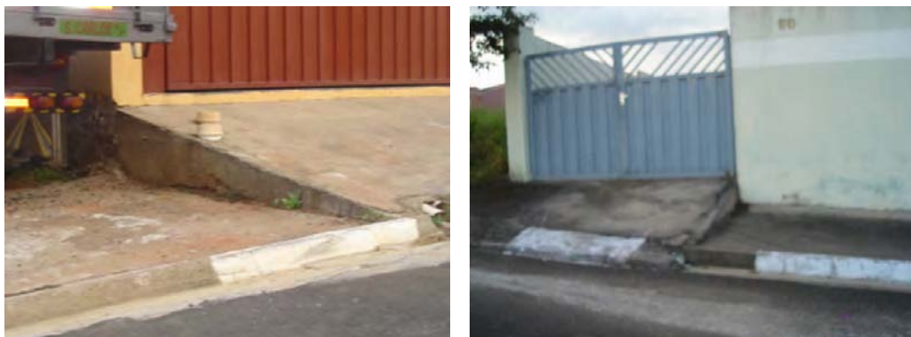
FOTOS B.7.4. e B.7.5. Calçadas com rampas dificultando a passagem de pedestres (fotos da autora)
