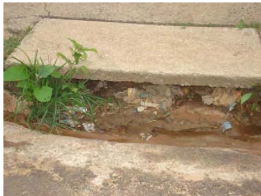
FOTOS B.6.43 e B.6.44. Bocas-de-lobo deterioradas e com entradas obstruídas por resíduos sólidos (fotos da autora)
