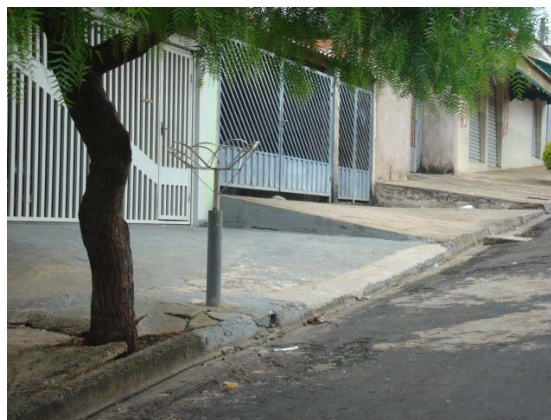
FOTO B.6.7. Calçada obstruindo a passagem de pedestres (fotos da autora).
