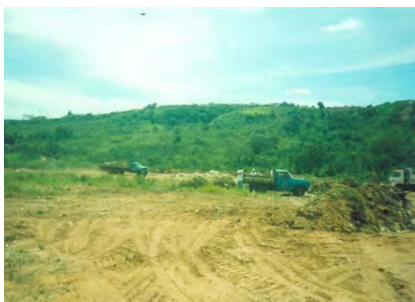
FOTO B.6.16. Área sendo limpada pela PMSC - resíduos encaminhados para o aterro sanitário municipal (foto da autora, 2000)
