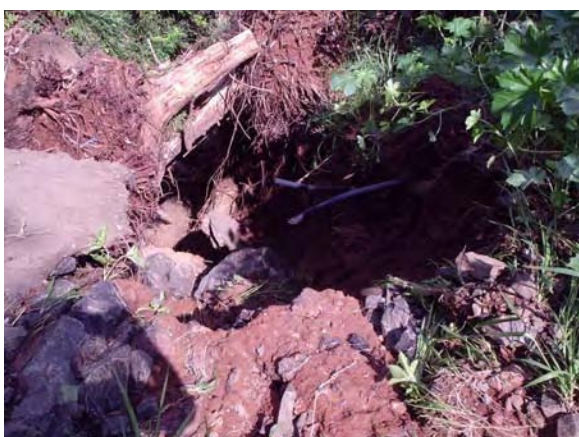
FOTOS B.3.16 e B.3.17. Detalhe do processo erosivo causado pela falta de dissipador de energia efetivo (fotos da autora)
