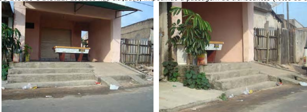
FOTOS B.5.21 e B.5.22. Escadas nas calçadas, impedindo a passagem de transeuntes (fotos da autora)
