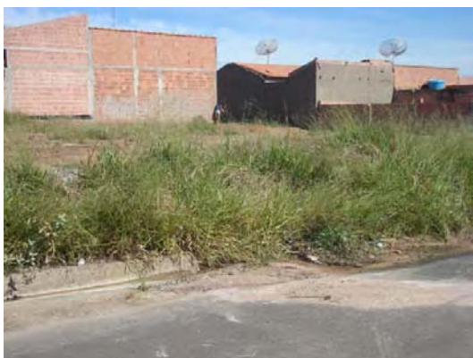
B.3.29 e B.3.30. Guias e sarjetas obstruídas por vegetação ou rampas para entrada de veículos (fotos da autora)
