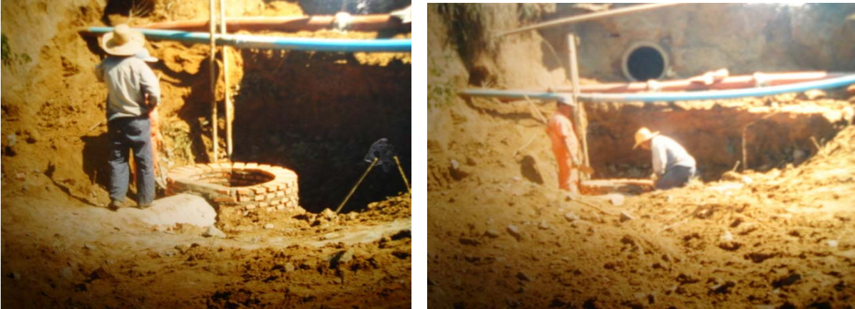
FOTOS B.7.29 e B.7.30. Execução das obras emergenciais no loteamento Parque Fehr (SÃO PAULO, 2002a).
