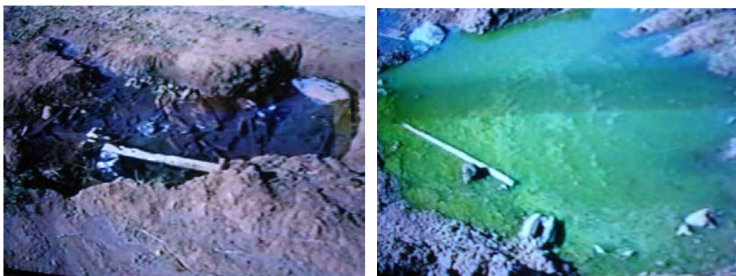
FOTOS B.2.38 e B.2.39. Vazamento de esgoto no loteamento Jardim Itamaraty (KONDOR, 1996).
