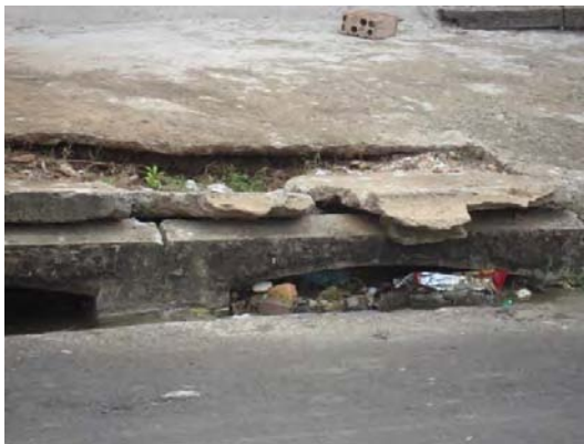
FOTOS B.6.39 e B.6.40. Bocas-de-lobo deterioradas e com entradas obstruídas por resíduos sólidos (fotos da autora)
