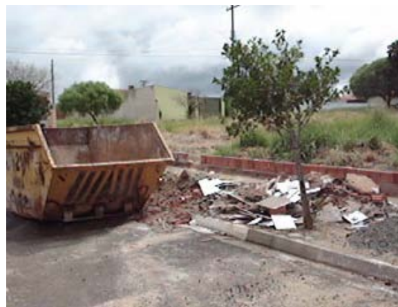
FOTO B.7.45 e B.7.46. Obstrução das guias e sarjetas por material de construção e entulho (foto da autora)
