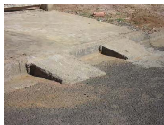
B.3.29 e B.3.30. Guias e sarjetas obstruídas por vegetação ou rampas para entrada de veículos (fotos da autora)
