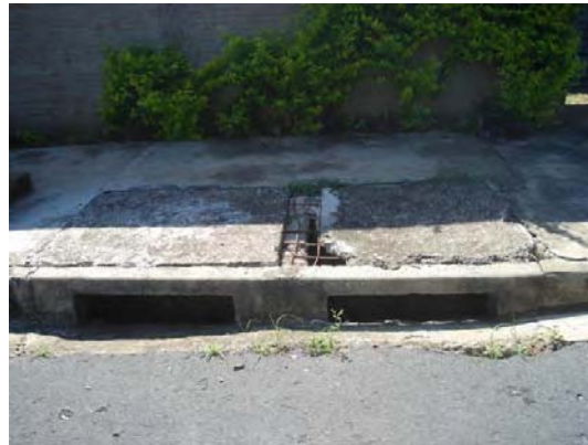
FOTOS B.2.45 e B.2.46. Boca-de-lobo deteriorada (foto da autora)
