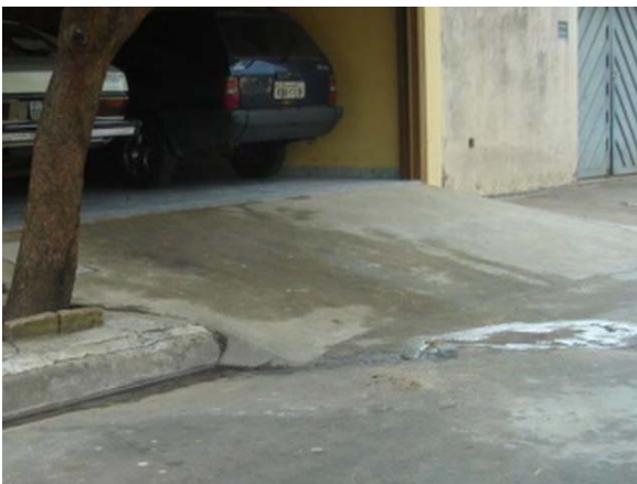
FOTO B.5.47 e B.5.48. Guias e sarjetas obstruídas (fotos da autora)
