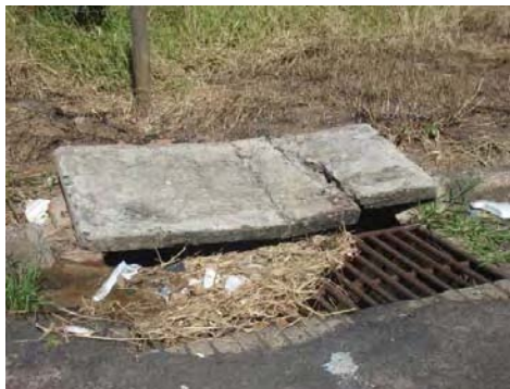
FOTO B.1.30 e B.1.31. Bocas-de-lobo deterioradas e com presença de resíduos sólidos (fotos da autora)
