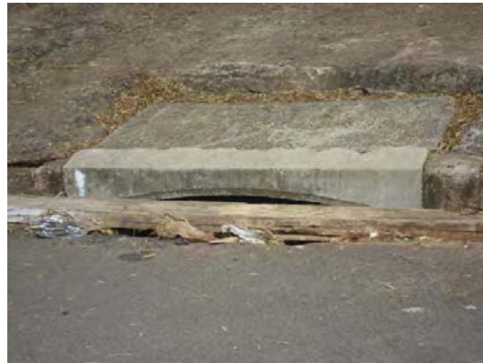
FOTOS B.6.41 e B.6.42. Bocas-de-lobo deterioradas e com entradas obstruídas por resíduos sólidos (fotos da autora)
