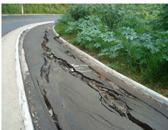
FOTO B.5.11 e B.5.12. Processo erosivo na ciclovia da avenida Integração (fotos da autora).
