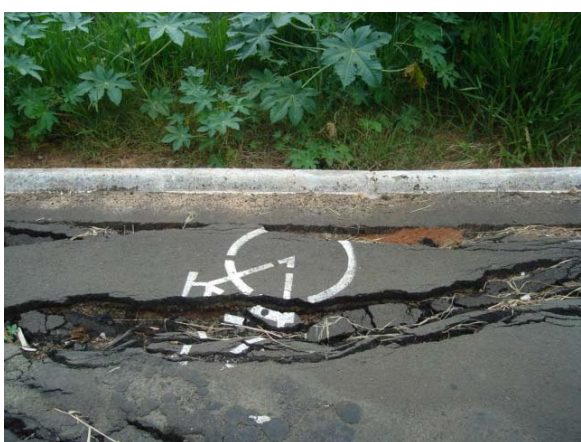
FOTO B.5.11 e B.5.12. Processo erosivo na ciclovia da avenida Integração (fotos da autora).
