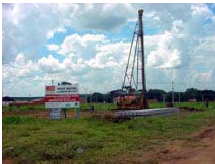
FOTO B.4.40. Construção do reservatório elevado (SÃO CARLOS, 2005b).
