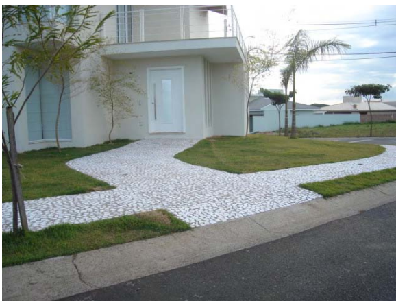
FOTOS B.9.3 e B.9.4. Uso de sarjetões e rebaixamento de guias para facilitar a acessibilidade dos portadores de cadeira de rodas (fotos da autora).
