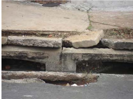
FOTOS B.6.39 e B.6.40. Bocas-de-lobo deterioradas e com entradas obstruídas por resíduos sólidos (fotos da autora)
