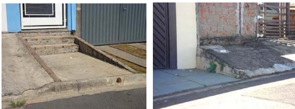
FOTOS B.2.10 e B.2.11. Calçadas obstruindo a passagem de pedestres (fotos da autora).
