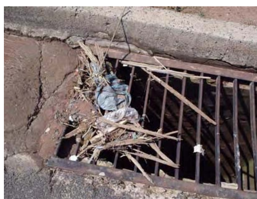
FOTOS B.3.25 e B.3.26. Material inerte (areia) na boca-de-lobo (fotos da autora)
