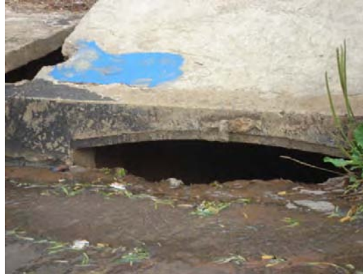
FOTOS B.6.37 e B.6.38. Bocas-de-lobo deterioradas (fotos da autora)
