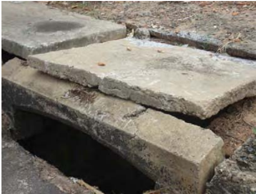
FOTOS B.6.37 e B.6.38. Bocas-de-lobo deterioradas (fotos da autora)
