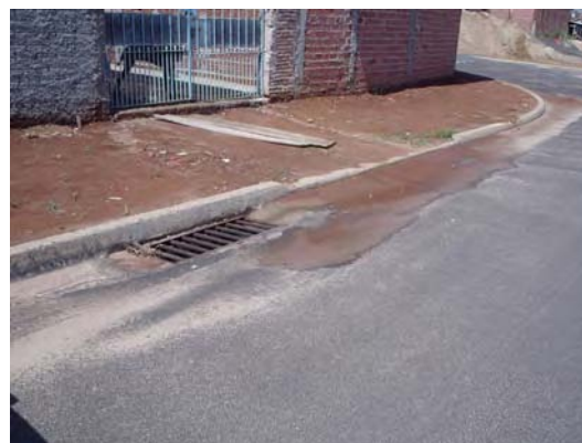
FOTOS B.3.27 e B.3.28. Material inerte (areia) na boca-de-lobo (fotos da autora)
