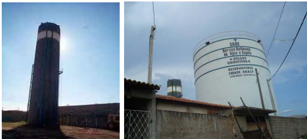
FOTO B.5.41 e B.5.42. Reservatório de água do bairro Cidade Aracy (SÃO CARLOS, 2006h)
