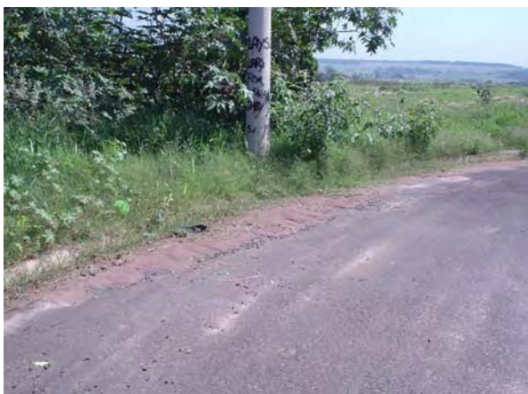
FOTOS B.3.21 e B.3.22. Material inerte (areia) obstruindo a passagem da água pluvial pelas guias e sarjetas (fotos da autora)
