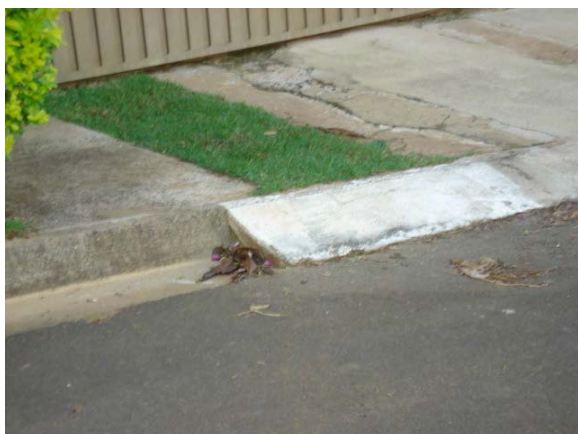
FOTO B.7.43 e B.7.44. Obstrução das guias e sarjetas por rampas para entrada de veículos (foto da autora)
