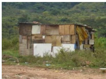
FOTOS B.6.31, B.6.32 e B.6.33. Casas construídas com entulhos (fotos da autora).
