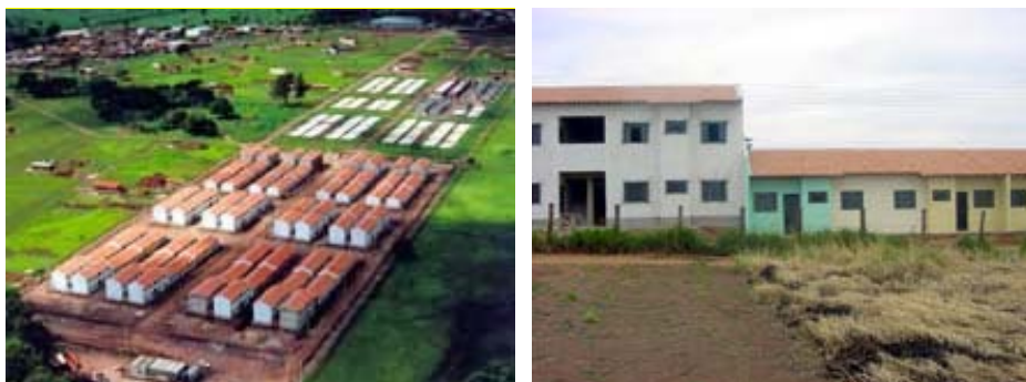
FOTO B.4.35 e B.4.36. Conjunto de casas e sobrados executados pelo Programa de Arrendamento Residencial (PAR) no empreendimento (SÃO CARLOS, 2006d; SÃO CARLOS, 2005c).
