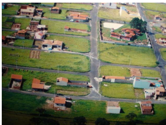
FOTO B.7.2. Vista aérea do arruamento (MP, 2002)
