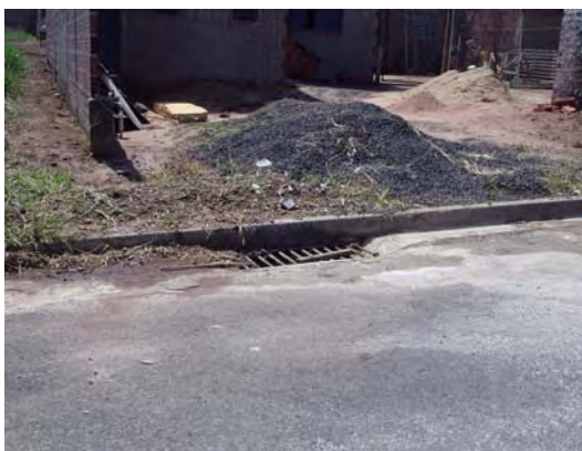
FOTOS B.3.25 e B.3.26. Material inerte (areia) na boca-de-lobo (fotos da autora)
