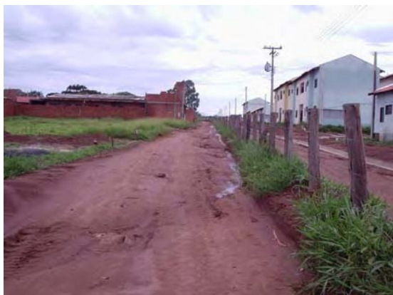
FOTOS B.4.8 e B.4.9. Condução das águas pluviais longitudinais às vias. Início de processo erosivo. (foto da autora)
