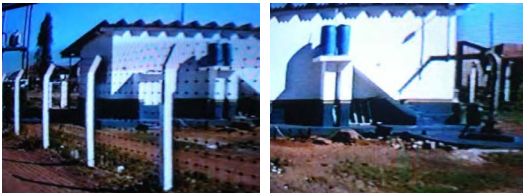
FOTOS B.2.35 e B.2.36. Casa de bomba e poço profundo situada no Conjunto Habitacional Maria Estela Fagá (KONDOR, 1996).
