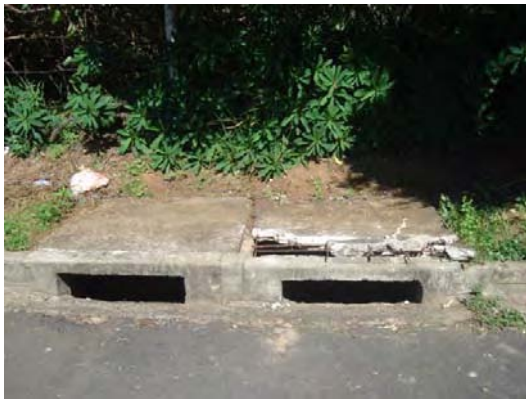
FOTOS B.2.45 e B.2.46. Boca-de-lobo deteriorada (foto da autora)
