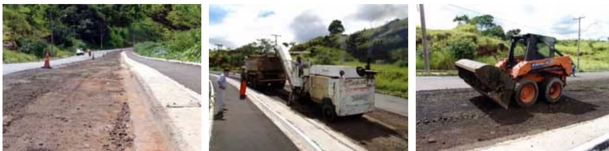
FOTOS B.5.5, B.5.6 e B.5.7. Recuperação asfáltica da Avenida Integração (SÃO CARLOS, 2006a)
