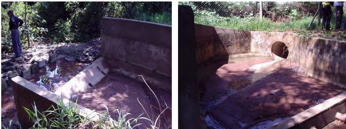
FOTOS B.3.12 e B.3.13. Vista da estrutura para dissipação de energia da Sub-Bacia I (fotos da autora).
