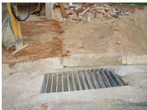
FOTO B.7.47 e B.7.48. Material de construção carregado na boca-de-lobo (foto da autora)
