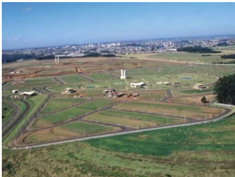
FOTO B.8.7. Implantação do condomínio Damha I (ENCALSO, 2007)
