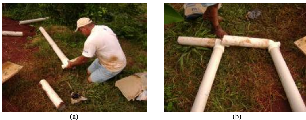
FIGURA 4. 31- a- e b-) execução de pescador para saída de efluente da fossa séptica ( fonte: Habis, 2009 ).
