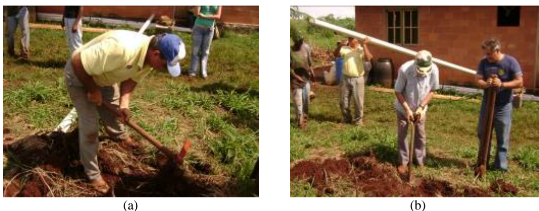
FIGURA 4. 3- a-) escavação das unidades utilizando picareta. b-) escavação das unidades utilizando escavadeira ( fonte: Habis, 2009 ).
