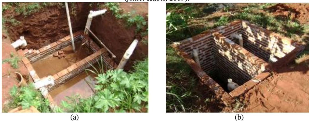
FIGURA 4. 39- a e b-) início de elevação da alvenaria da fossa séptica (fonte: Habis, 2009).
