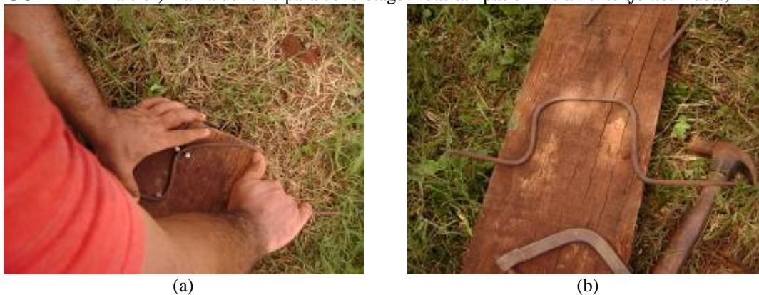
FIGURA 4. 22- a e b-) execução das alças das tampas da fossa séptica (fonte: Habis, 2009).
