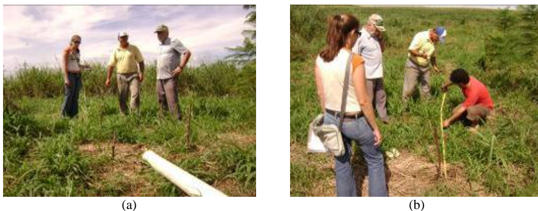
FIGURA 4. 1- a-) uso de tubo de PVC de 100mm com 6 metros de comprimento para determinação do início da unidade de tratamento. b-) marcação da primeira caixa de passagem ( fonte: Habis, 2009 ).
