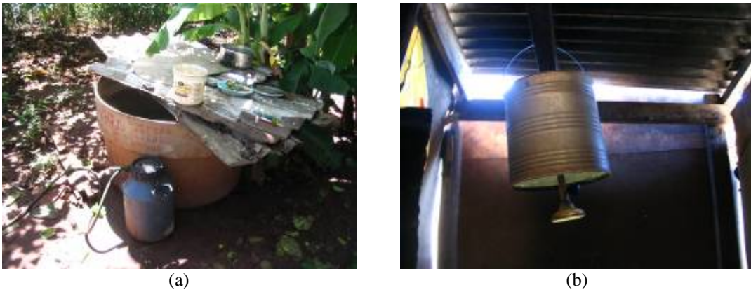
FIGURA 2. 7- a-) Reservatório de água para uso doméstico proveniente da captação por poços. b-) solução alternativa adotada por morador para o banho ( fonte: Habis, 2006 ).
