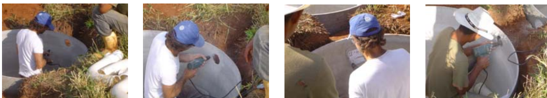
FIGURA B. 2 – Perfuração das caixas de fibrocimento com uso de furadeira e lixamento.
