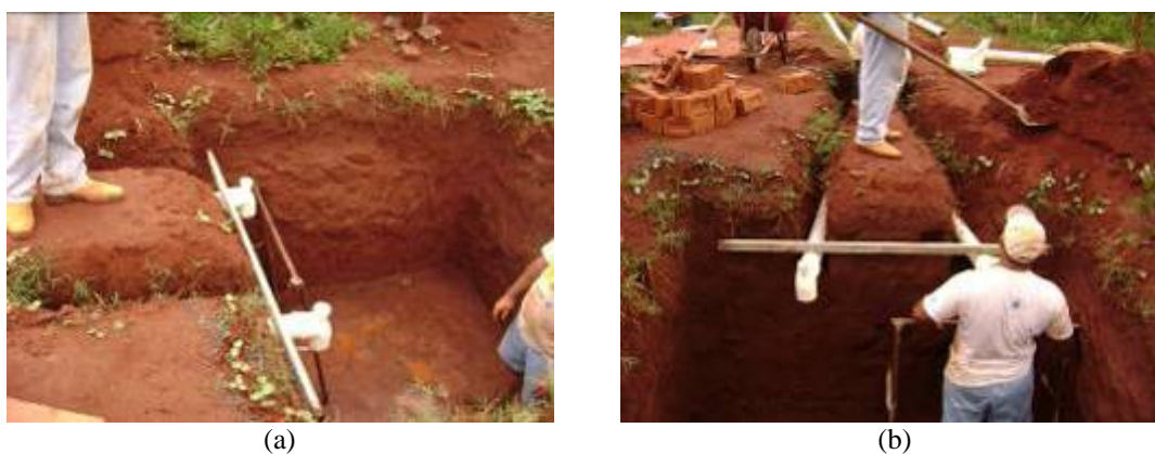
FIGURA 4. 32- a- e b-) processo de nivelamento das entradas de efluente nas duas unidades da fossa séptica ( fonte: Habis, 2009 ).
