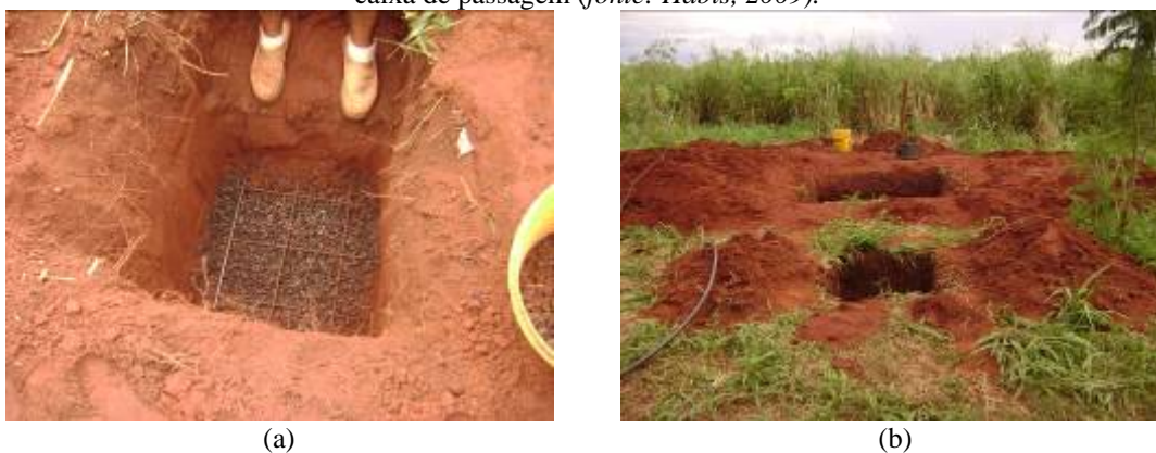
FIGURA 4. 12- a-) colocação da armadura de fundo na segunda caixa de passagem. b-) vista geral das unidades após o primeiro dia de oficina (fonte: Habis, 2009).
