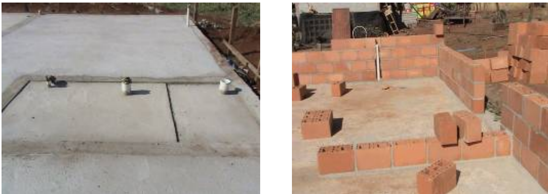
FIGURA 2. 13- Esperas de esgoto no banheiro e na cozinha (fonte: Habis, 2007).
