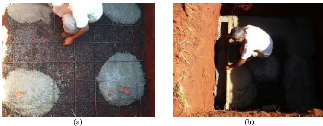
FIGURA 4. 15- a-) colocação de concreto nas referências de alturas. b-) sarrafeamento da fossa séptica ( fonte: Habis, 2009 ).
