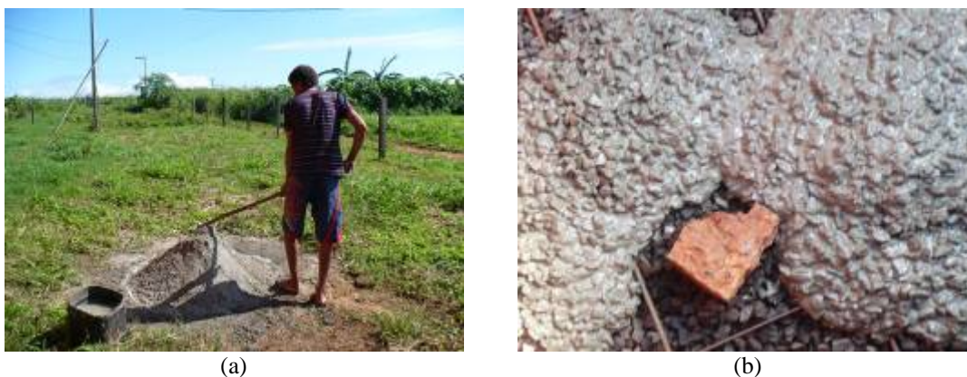
FIGURA 4. 14- a-) preparo do concreto. b-) início da concretagem com referência para nível do tijolo maciço ( fonte: Habis, 2009 ).
