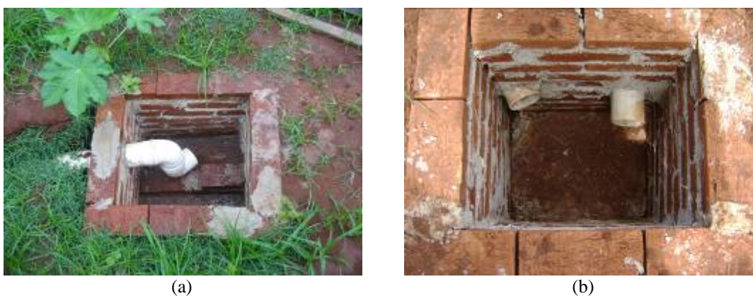
FIGURA 4. 38- a-) primeira caixa de passagem: detalhe interno. b-) segunda caixa de passagem: detalhe interno (fonte: Habis, 2009).
