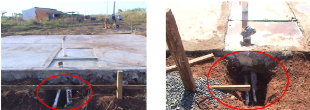
FIGURA 2. 12- Detalhe das esperas de esgoto, com separação das águas cinzas e águas negras (fonte: Habis, 2007).
