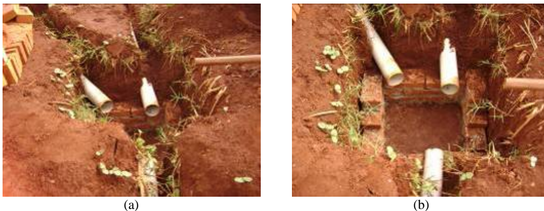
FIGURA 4. 36- a e b-) detalhe da tubulação de dupla entrada na segunda caixa de passagem e saída única para o círculo de bananeiras (fonte: Habis, 2009).
