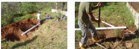
FIGURA B. 1 - Visualização do terreno local com locação do sistema / Busca da tubulação de saída esgoto da habitação
