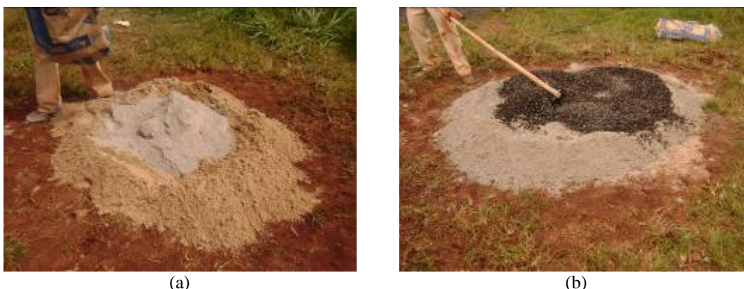
FIGURA 4. 23- a e b-) preparo do concreto das unidades (fonte: Habis, 2009).
