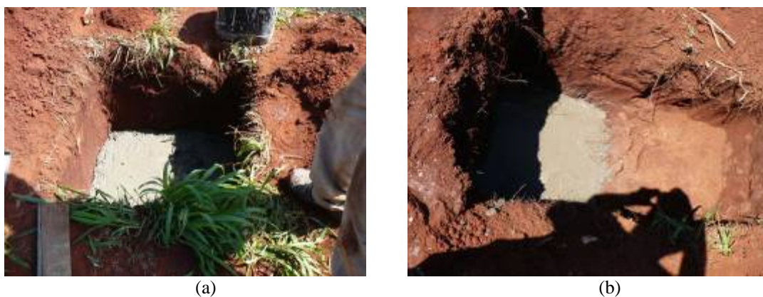
FIGURA 4. 16- a-) concretagem da primeira caixa de passagem. b-) concretagem da segunda caixa de passagem ( fonte: Habis, 2009 ).
