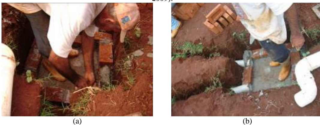
FIGURA 4. 28- a-) execução da primeira caixa de passagem. b-) detalhe das tubulações de saída da primeira caixa de passagem (fonte: Habis, 2009).
