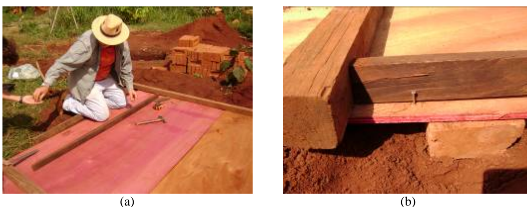
FIGURA 4. 19- a-) preparação das fôrmas para concretagem da tampa da fossa séptica. b-) detalhe de parafusamento da fôrma para evitar movimentações ( fonte: Habis, 2009 ).
