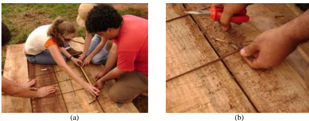
FIGURA 4. 7- a-) verificação do espaçamento entre armaduras das caixas de passagem. b-) amarração com arame recozido (fonte: Habis, 2009).
