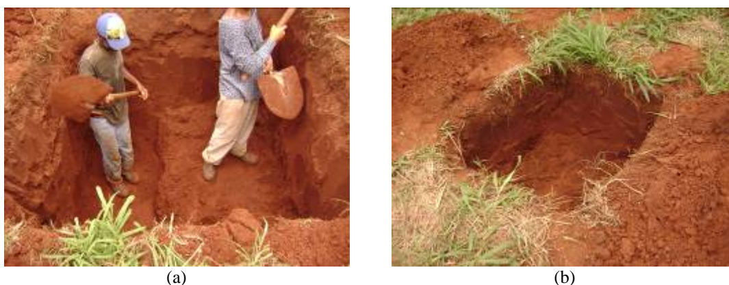
FIGURA 4. 5- a-) escavação das duas unidades da fossa séptica. b-) primeira caixa de passagem com escavação finalizada ( fonte: Habis, 2009 ).
