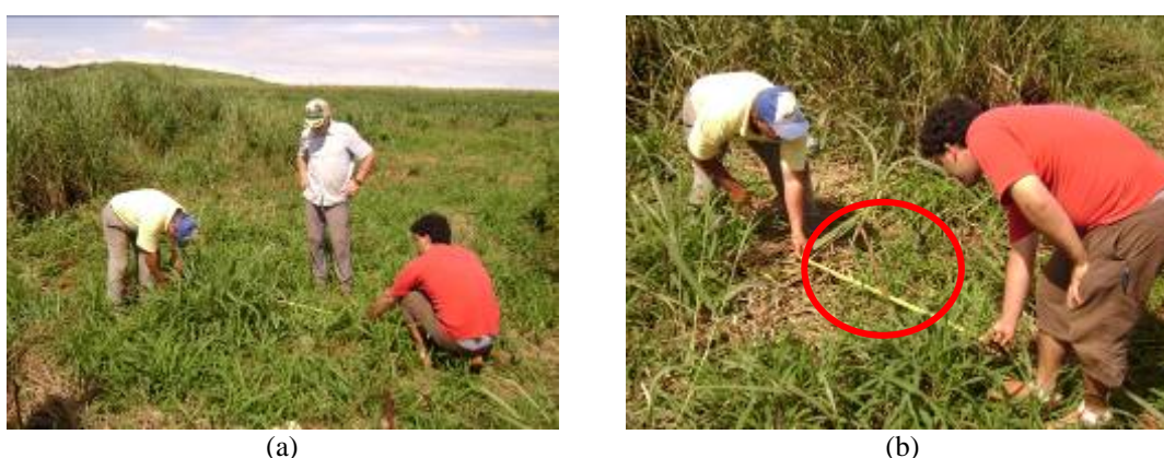
FIGURA 4. 2- a-) marcação da fossa séptica. b-) uso de graveto para delimitação da área de escavação ( fonte: Habis, 2009 ).
