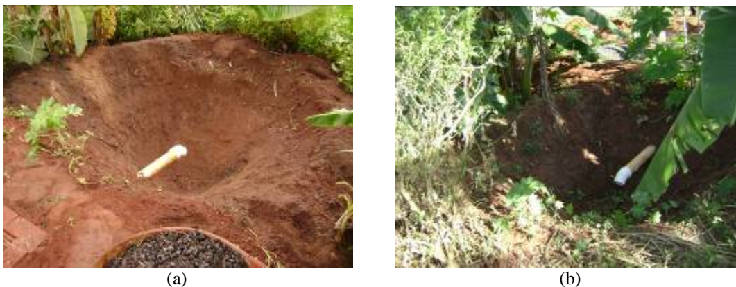
FIGURA 4. 40- a-) círculo de bananeiras escavado e finalizado para receber brita ao fundo. b-) detalhe da tubulação de entrada de efluente no círculo de bananeiras ( fonte: Habis, 2009 ).
