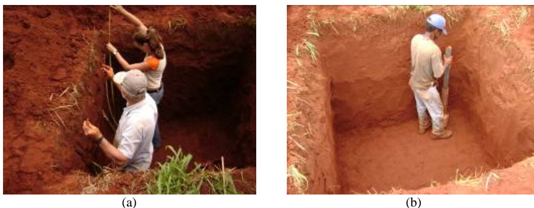
FIGURA 4. 6- a-) verificação de nível com mangueira e auxílio da pesquisadora. b-) compactação de fundo das unidades da fossa séptica ( fonte: Habis, 2009 ).
