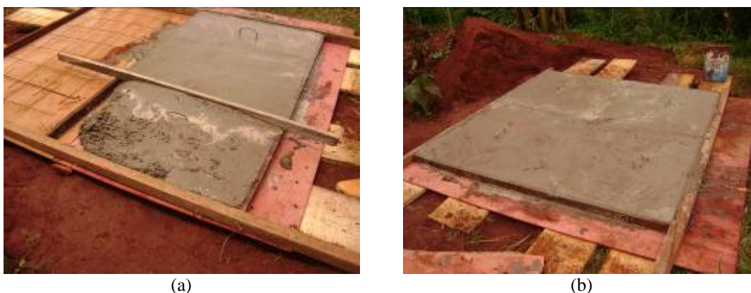
FIGURA 4. 26- a-) concretagem das tampas da fossa séptica e sarrafeamento, com aplicação das alças. b-) finalização da concretagem (fonte: Habis, 2009).
