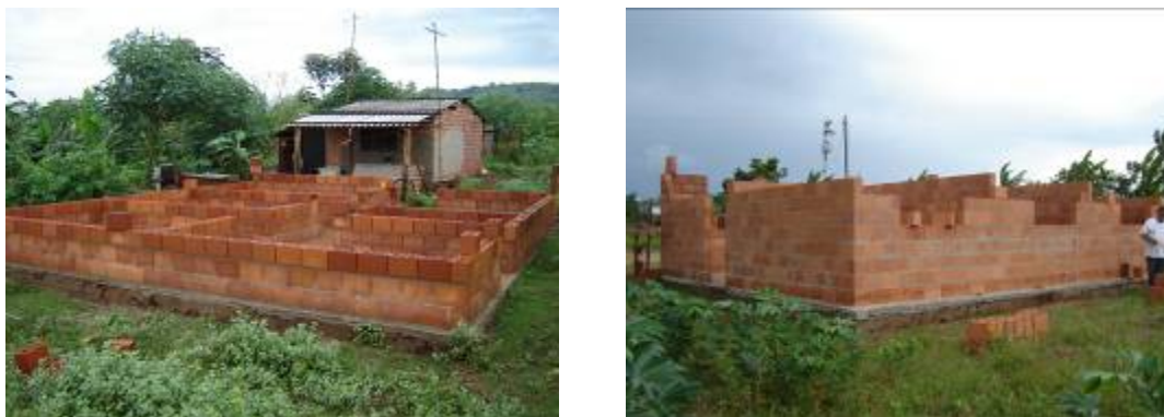
FIGURA 2. 4- Habitações em processo de construção da alvenaria em bloco cerâmico (fonte: Habis, 2006).
