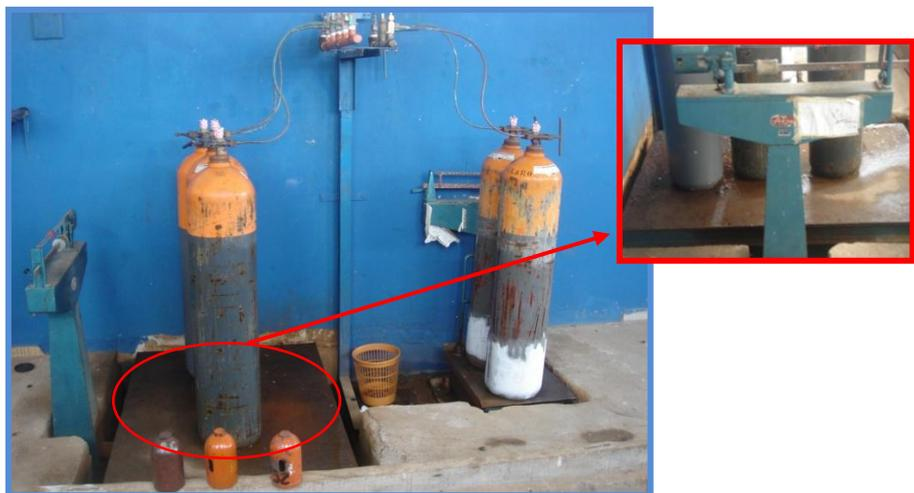
**Figura 40** – Recinto para armazenamento de cloro gasoso na ETA 2 do SiTA E, no detalhe cilindros sobre área úmida.
