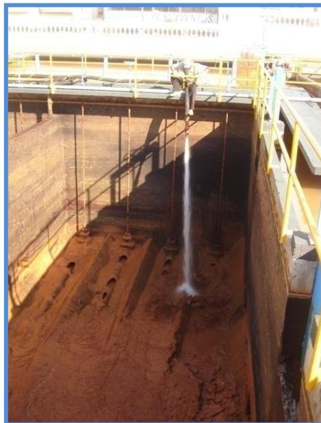
**Figura 75** – Limpeza dos decantadores no SiTA G.
