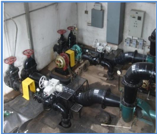
**Figura 23** – Conjunto de bombas na captação 1 do SiTA D.
