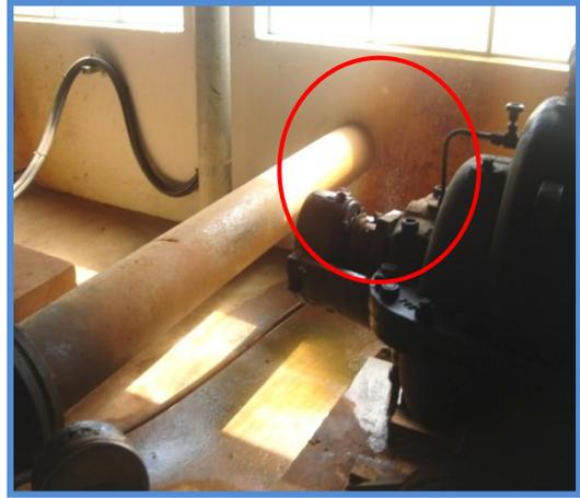
**Figura 25** – Conjunto de bombas do SiTA E. (No detalhe perdas físicas)
