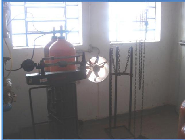
**Figura 39** – Recinto para armazenamento de cloro gasoso na ETA 1 do SiTA E.
