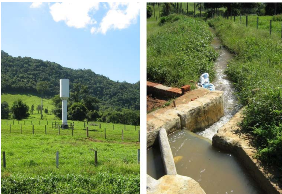
Figura 60 – Torre de abastecimento de água e canal artificial. Fonte: o autor, 2010.
