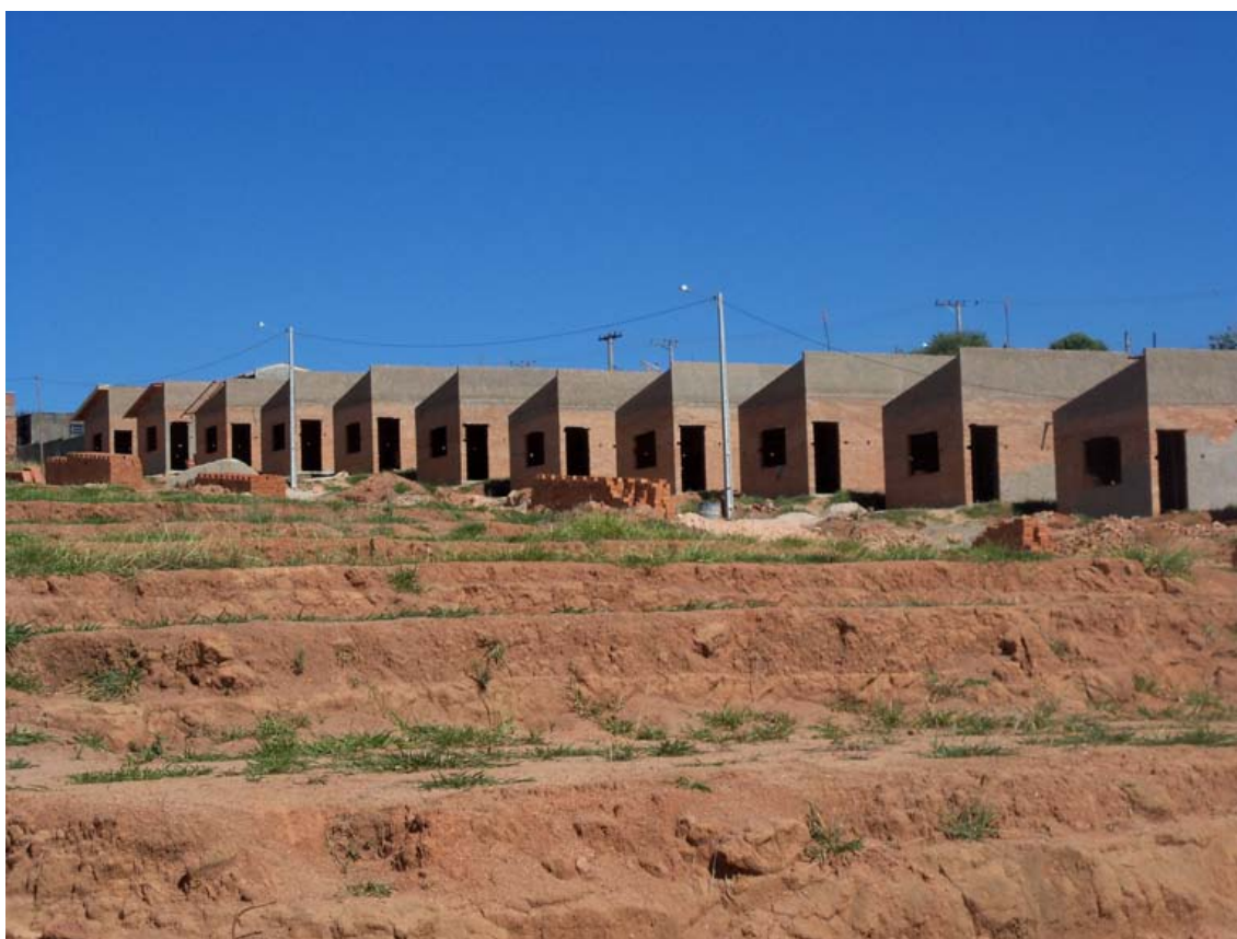
Figura 46 – Tipologia de residências em CHIS. Fonte: o autor, 2010.
