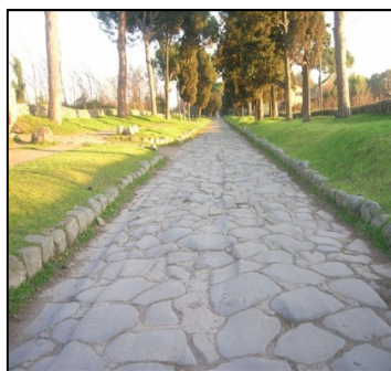
Figura 2.5: Alvenaria poliédrica – Via Áppia Roma. Fonte: BRUNI, 2010.
