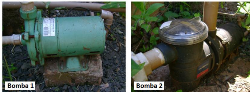
**Figura 13:** Fotografia das bombas utilizadas na estação captação e tratamento de águas pluviais. À esquerda, Bomba 1, utilizada para homogeneização da água pluvial contida no Reservatório de Acumulação. À direita, Bomba 2, utilizada para encaminhamento da água pluvial até o filtro de pressão. Sem escala.
