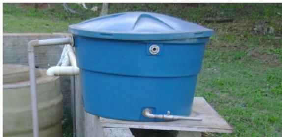
**Figura 16:** Fotografia da caixa de limpeza utilizada na estação de captação e tratamento de águas pluviais.
