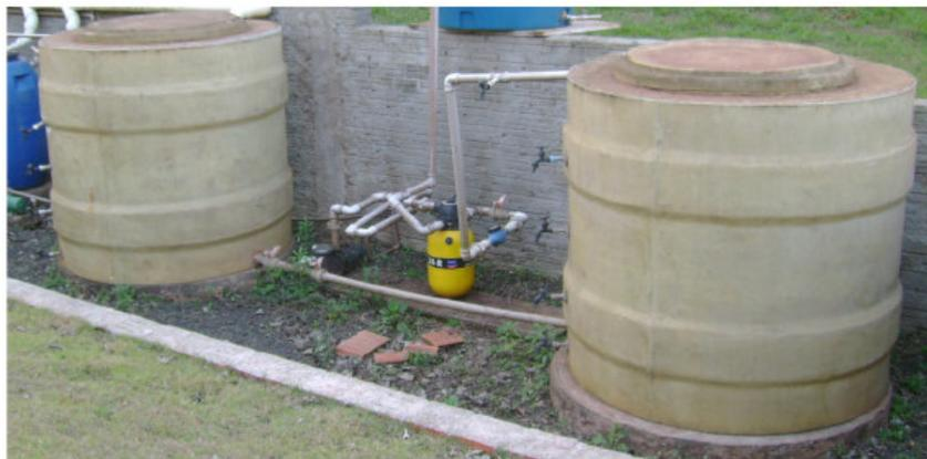
**Figura 12:** Fotografia dos reservatórios utilizados na estação experimental de captação e tratamento de águas pluviais. À esquerda, reservatório utilizado para acumulação temporária da água pluvial coletada (Reservatório de Acumulação). À direita, reservatório utilizado para o armazenamento da água pluvial já tratada (Reservatório de Armazenamento).
