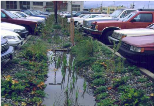
FIGURA 18 - Valas de Infiltração. Fonte: CLEAN RIVER WORKS, 2002.
