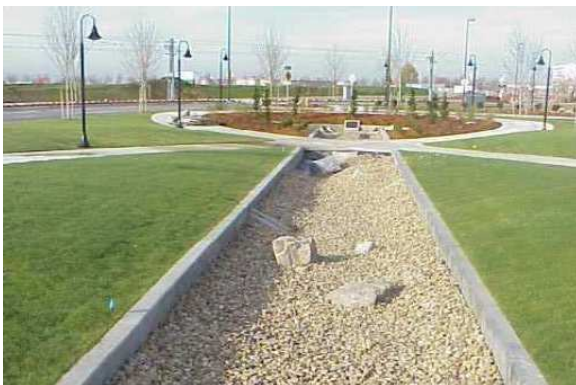
FIGURA 30 - Trincheira de Infiltração. Fonte: CLEAN RIVER WORKS, 2002.
