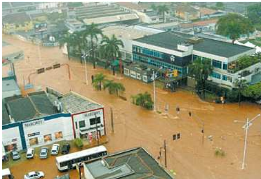
FIGURA 06 - Inundação na Av. Alberto Andaló, em S. J.Rio Preto/SP – Córrego Canela canalizado. Fonte: Diário da Região, 2008.
