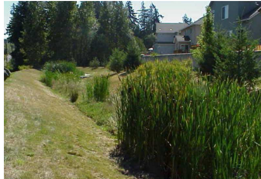
FIGURA 19 - Valas de Infiltração. Fonte: CLEAN RIVER WORKS, 2002.
