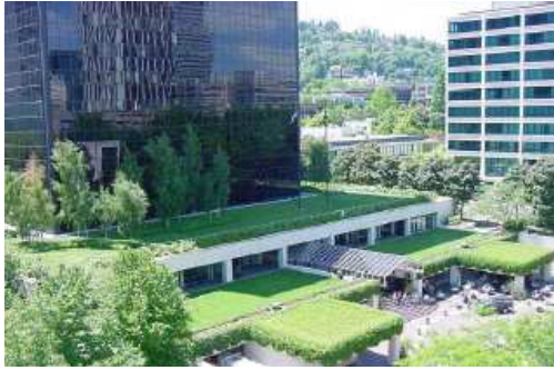
FIGURA 25 - Telhados verdes. Fonte: CLEAN RIVER WORKS, 2002.
