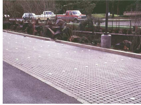
FIGURA 33 - Piso de estacionamento em blocos de concreto vazado. Fonte: CLEAN RIVER WORKS, 2002.
