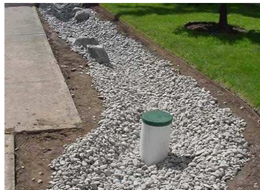
FIGURA 31 - Trincheira de Infiltração. Fonte: CLEAN RIVER WORKS, 2002.
