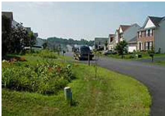
FIGURA 29 – Exemplo de Bioretenção.
