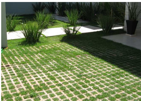
FIGURA 34 - Utilização de blocos de concreto vazado em residência. Fonte: TAVANTI, 2008.
