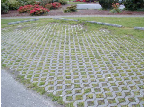
FIGURA 32 - Utilização de blocos de concreto vazado em piso de estacionamento. Fonte: CLEAN RIVER WORKS, 2002.
