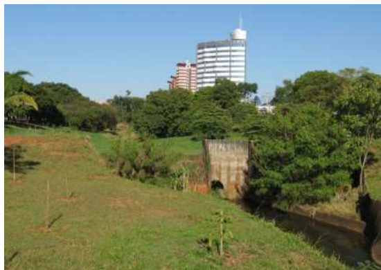
FIGURA 35 - Bacia de retenção no município de São José do Rio Preto. Fonte: TAVANTI, 2008.
