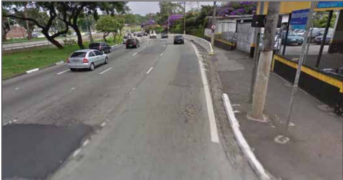
Figura 44: Trecho Avenida Washington Luís com pavimento apresentando grande quantidade de emendas e rachaduras. Créditos: Paulo Diego D' Ovídio Silva 11/03/2011.
