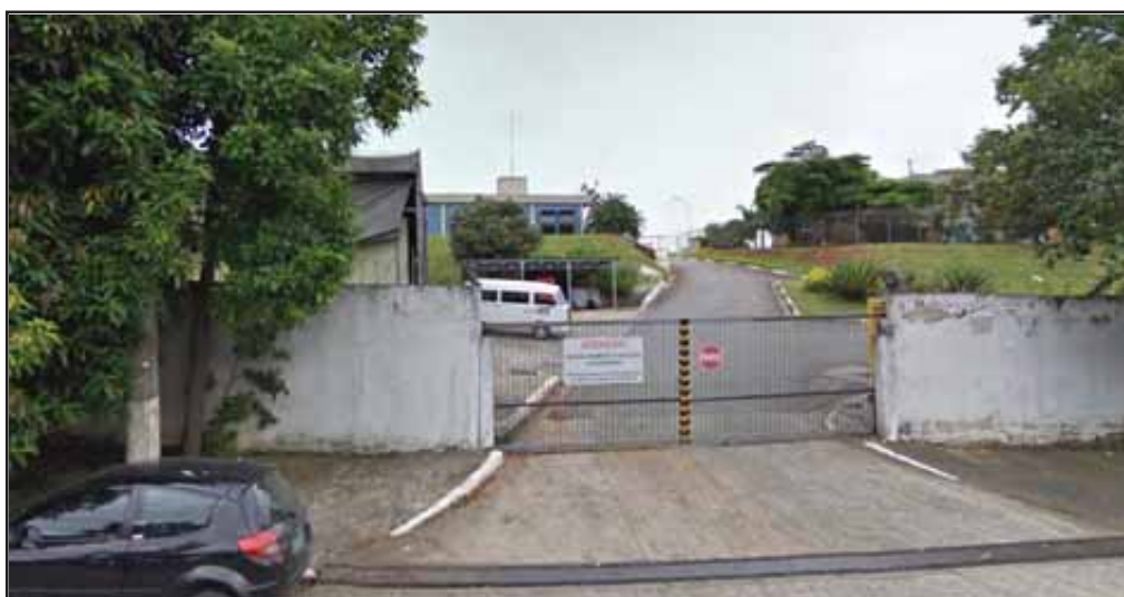
Figuras 53 e 54: Entradas para o Aeroporto de Congonhas localizadas na Avenida Jurandir. Acima, acesso para os hangares da TAM. Abaixo desta, acesso para o SCI. Créditos: Paulo Diego D' Ovídio Silva - 15/03/2011.
