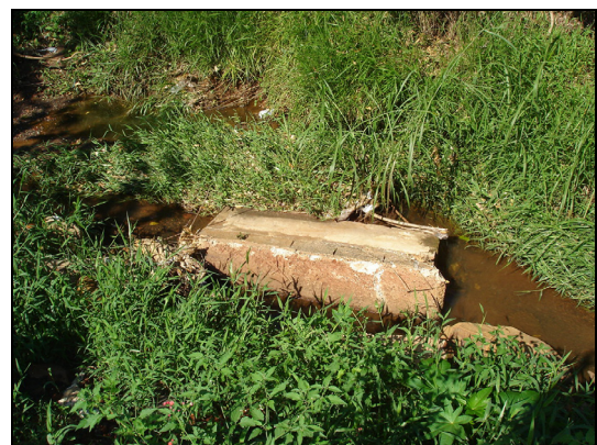
F) Disposição inadequada de resíduo de construção e demolição, obstruindo o leito do córrego e dificultando a drenagem da água; ausência de vegetação ciliar.
