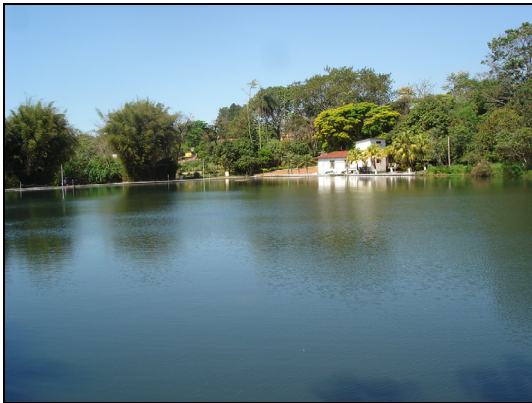
C) Primeiro represamento do córrego do Rosário - Represa Rosária - captação de água para abastecimento público.
