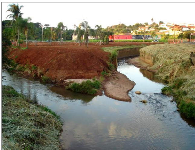
FIGURA 16: Confluência do rio do Monjolinho com o córrego do Gregório. Na figura pode-se verificar construção de canal sob o leito do córrego do Gregório, iniciativas de contenção de margens e pontos de assoreamento. Fonte: Leandro C. Campanelli (2009).
