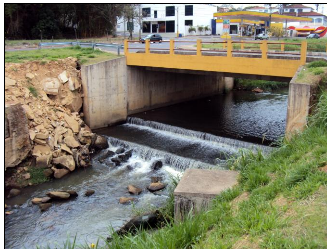
FIGURA 13: Ponte construída sobre o rio do Monjolinho na região da Rua Oscar Jensen. No local da ponte havia uma tubulação que não suportou o rápido acréscimo de vazão sofrido pelo rio em função das chuvas. Fonte: Leandro C. Campanelli (2012).
