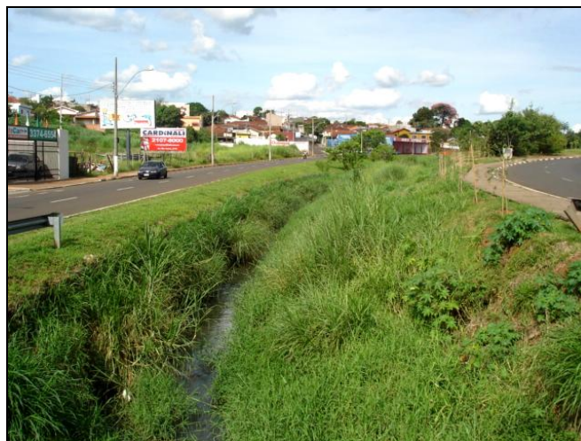
FIGURA 20: Trecho do córrego do Gregório, no qual verifica-se ausência de mata ciliar e de áreas de várzea (leitos naturais de inundação), marginais construídas em fundo de vale e intensa impermeabilização do solo urbano. Fonte: Leandro C. Campanelli (2012).
