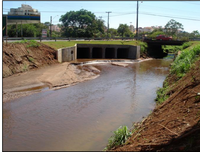
FIGURA 6: Obra de macrodrenagem na região da confluência do córrego Santa Maria Madalena com o rio do Monjolinho, nas proximidades do Parque do Kartódromo (São Carlos, SP). Fonte: Leandro C. Campanelli (2009).
