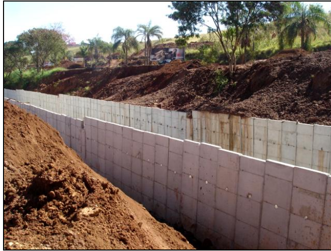
FIGURA 18: Contenção de margens e início da construção de canal sob o leito do córrego do Gregório nas proximidades do SESC. Fonte: Leandro C. Campanelli (2012).
