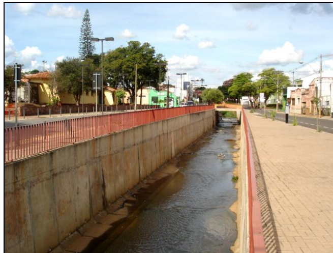
FIGURA 19: Destamponamento e construção de canal sob o leito do Córrego do Gregório, nas proximidades do Mercado Municipal de São Carlos, para minimizar inundações urbanas e prejuízos socioeconômicos. Fonte: Leandro C. Campanelli (2012).
