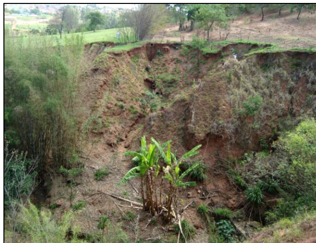
FIGURA 26: Voçoroca estabilizada localizada na região da sub-bacia hidrográfica do córrego da Água Quente (São Carlos, SP) – terrenos arenosos. Fonte: Gomes et al. (2012).
