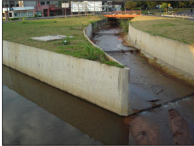
FIGURA 13: Confluência do rio do Monjolinho com o córrego do Tijuco Preto, na qual verifica-se construção de canal sob o leito dos mesmos para aumentar a velocidade de escoamento das águas. Fonte: Leandro C. Campanelli (2009).
