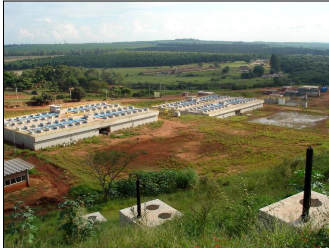
FIGURA 24: Reatores anaeróbicos de fluxo ascendente de manta de lodo – princípio de funcionamento da Estação de Tratamento de Esgotos de São Carlos (ETE Monjolinho), instalada em uma das margens do rio do Monjolinho. Fonte: Leandro C. Campanelli (2009).
