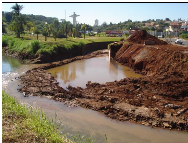
FIGURA 15: Obras de contenção e de estabilização de margens na região da confluência do rio do Monjolinho com o córrego do Gregório. Os impactos ambientais associados às obras incluem: aporte de sedimentos para os corpos d'água, assoreamento e aumento da turbidez das águas.
