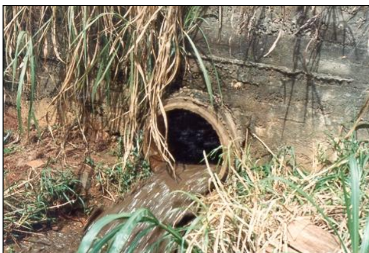
FIGURA 25: Despejo de lodo solubilizado, proveniente dos procedimentos de lavagem dos decantadores da Estação de Tratamento de Água (ETA) de São Carlos (SP), nas águas do rio do Monjolinho. Fonte: Prof. Dr. João Sergio Cordeiro (1992).
