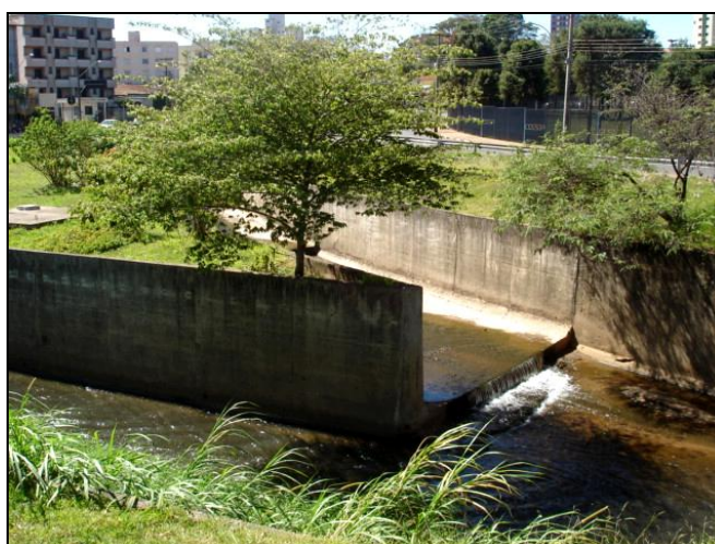
FIGURA 10: Confluência do rio do Monjolinho com o córrego do Tijuco Preto, na qual verifica-se construção de canal sob o leito dos córregos para aumentar a velocidade de escoamento das águas, minimizando a incidência de inundações. Fonte: Leandro C. Campanelli (2012).
