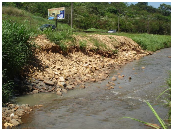
FIGURA 15: Marginal construída em fundo de vale, ausência de vegetação ciliar e iniciativa de contenção de margem (estabilização de talude lateral) no rio do Monjolinho, utilizando-se resíduos de construção e demolição. Fonte: Leandro C. Campanelli (2009).
