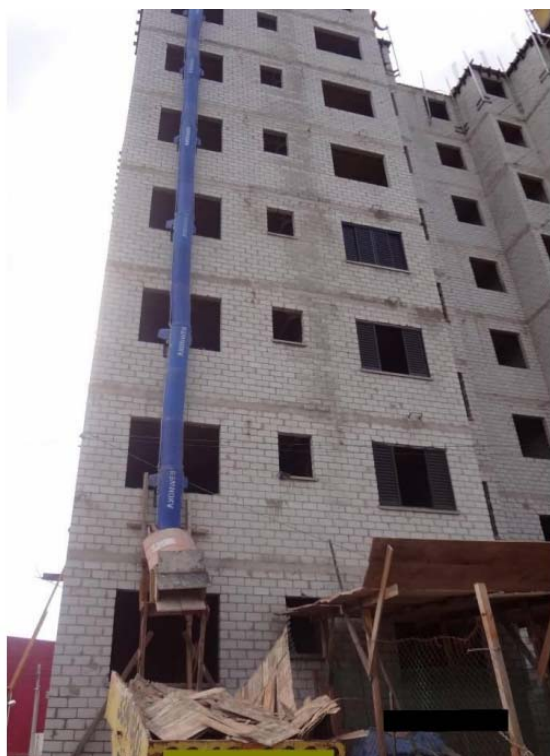
Figura 6. Dispositivo de coleta inicial com tubo coletor de resíduo Classe A.
