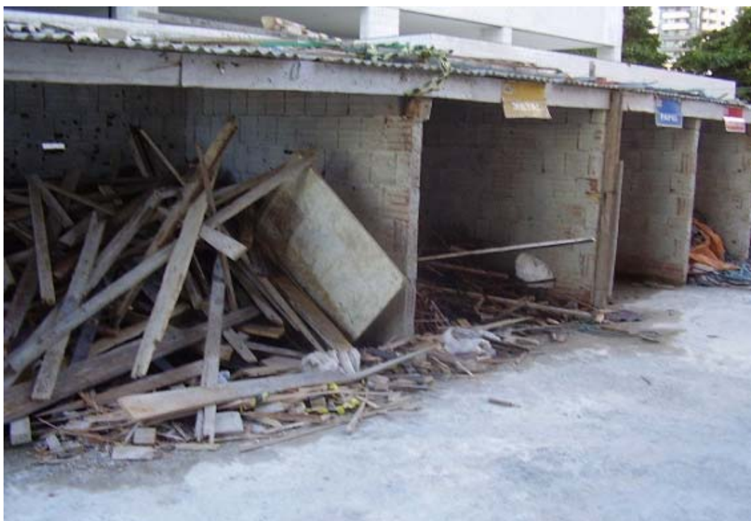
Figura 4. Dispositivos de acondicionamento final tipo baias.
