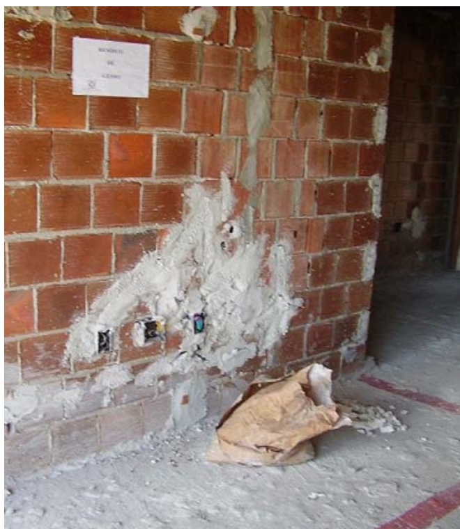
Figura 7. Marcação no piso para acondicionamento inicial do resíduo Classe A.
