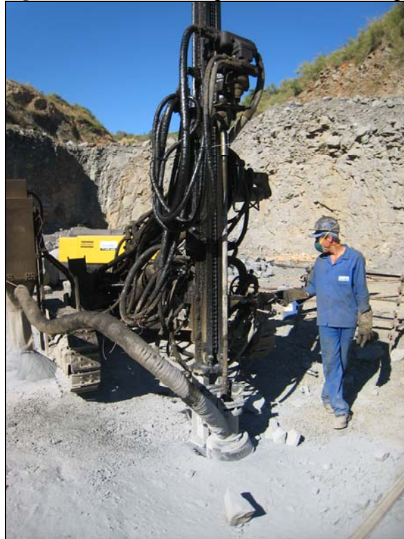
Figura 17 – Detalhe da perfuratriz e do compressor
