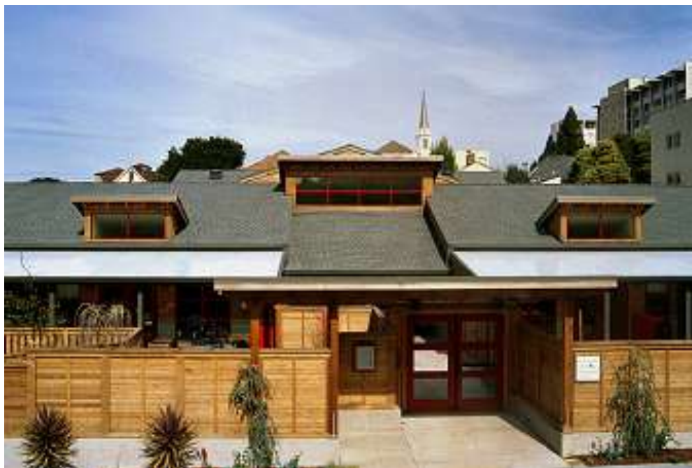
Figura 17 - Escola de educação infantil - certificação LEED.
