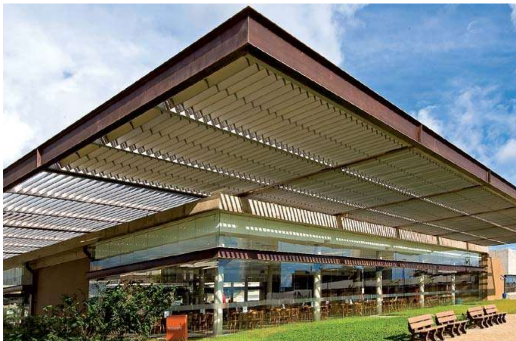
Figura 33 - Campus da Escola SESC: refeitório com coberturas independentes que amenizam a insolação.
