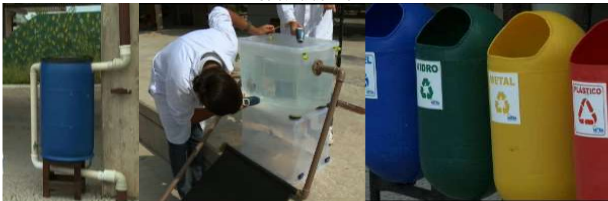
Figura 31 - Campus da Escola SESC: captação de água da chuva; aquecedor solar; coleta seletiva de lixo.
