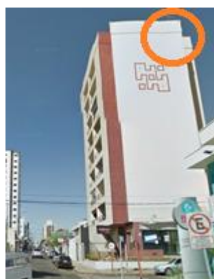
Figura 7: Local da instalação da Estação no ponto T.E.
