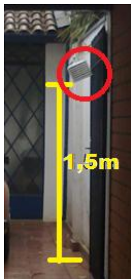
Figura 6: Posição da instalação do HOBO em um dos pontos de medição.
