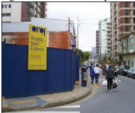
Figura4.17: Obras na Calçada
