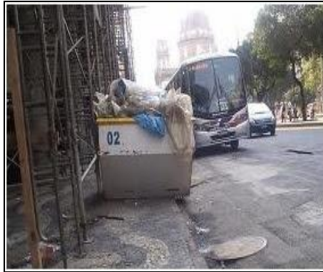
Figura4.18: Obras na Calçada
