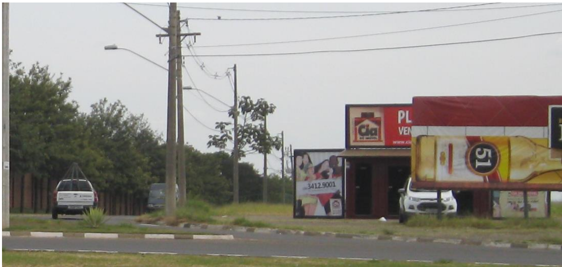
Figura 105 – Falta de passeios na via de aproximação Rua Maria C. na rotatória UNICEP
