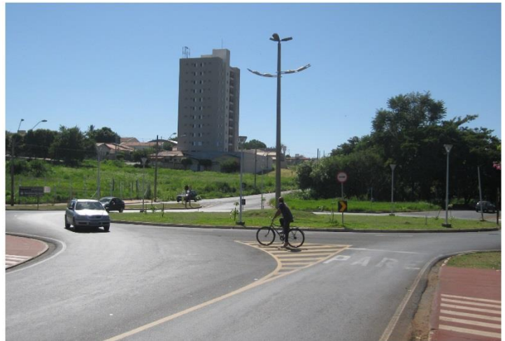
Figura 75 – Ilha separadora demarcada no pavimento sem refúgio para pedestres (ex. rotatória UBS Anchieta)
