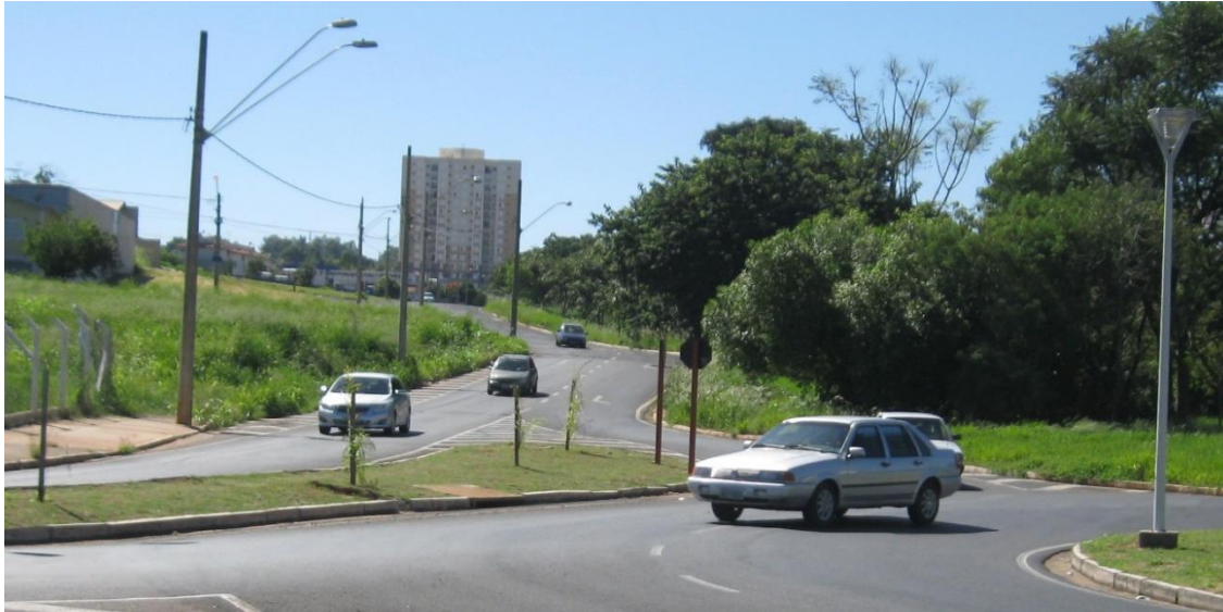
Figura 104 – Falta de passeios na via de aproximação Dr. Sólon Varginha na rotatória UBS Anchieta
