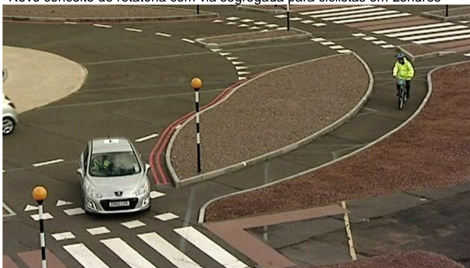
Figura 35 – Novo conceito de rotatória com via segregada para ciclistas em Londres
