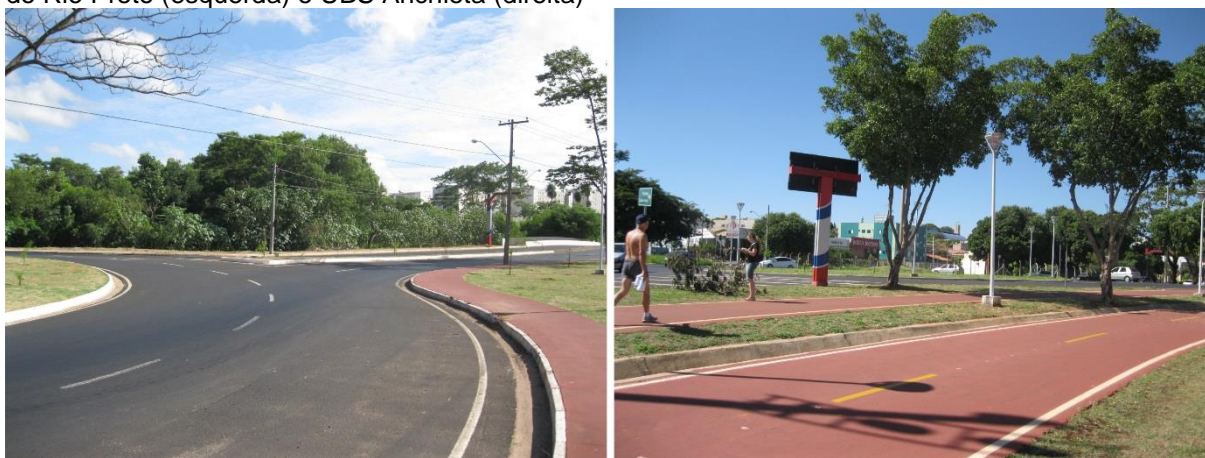
Figura 85 – Passeios em bom estado de conservação, com textura antiderrapante nas rotatórias Parque do Rio Preto (esquerda) e UBS Anchieta (direita)
