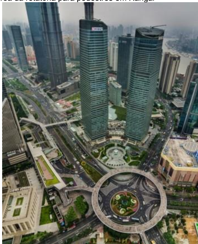
Figura 38 – Imagem aérea da rotatória para pedestres em Xangai
