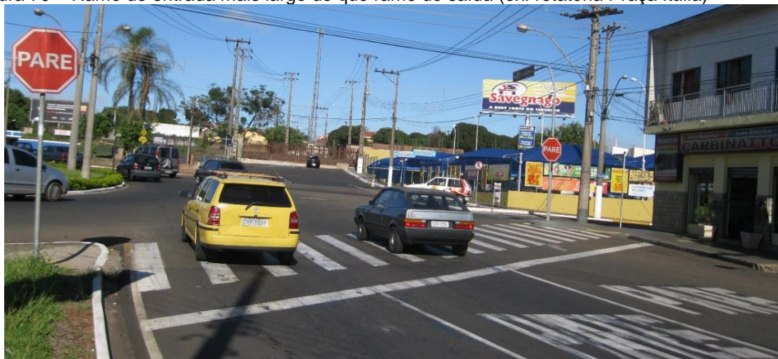
Figura 70 – Ramo de entrada mais largo do que ramo de saída (ex. rotatória Praça Itália)
