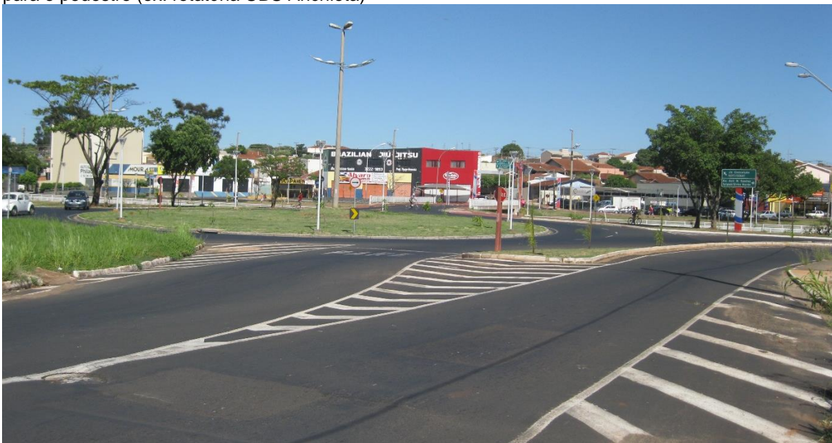
Figura 76 – Via auxiliar para diminuição do volume de veículos na via circular, aumento de travessias para o pedestre (ex. rotatória UBS Anchieta)
