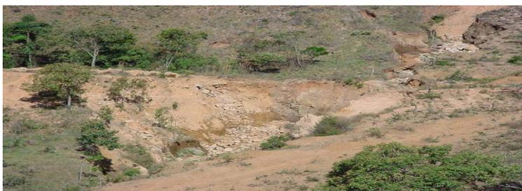
**FIGURA 2: Processo erosivo na implantação do loteamento Jd. Bandeirantes, no Município de Poços de Caldas, coordenadas UTM 7.587.020N e 388.250E (MENDONÇA, 2002).**
