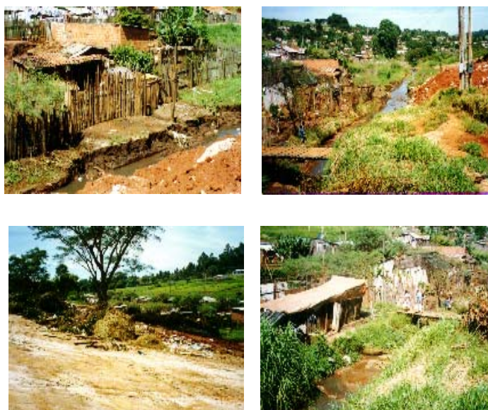
Figura 10: Ocupação precária em área de risco no município de Itararé (SP). Fonte: HABIS, 1999, p.11.
