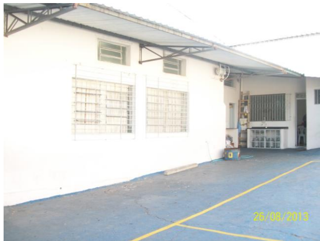
Figura 02 – Pátio principal da escola – Unidade II
