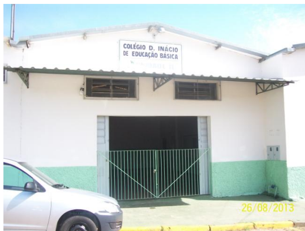
Figura 03 – Fachada do Colégio Dom Inácio – Unidade II
