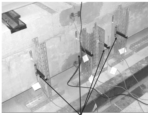
Transdutores posicionados na região central da viga bi-apoiada
