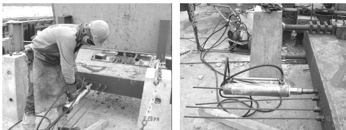
Figura 3-17: Protensão das armaduras empregadas nas vigas referentes a presente pesquisa.
