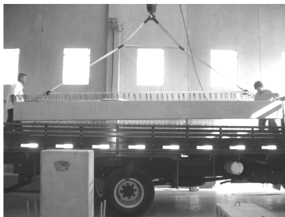
Figura 3-21: Chegada das vigas e transporte interno.
