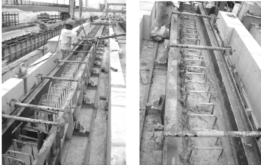
Figura 3-20: Concretagem das vigas protendidas estudadas.
