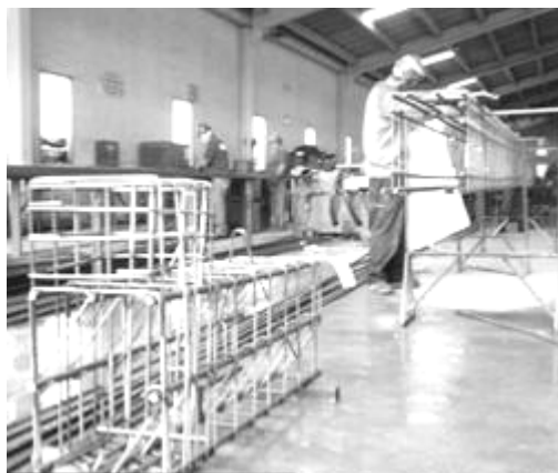
Figura 3-19: Produção dos trechos de pilares.
