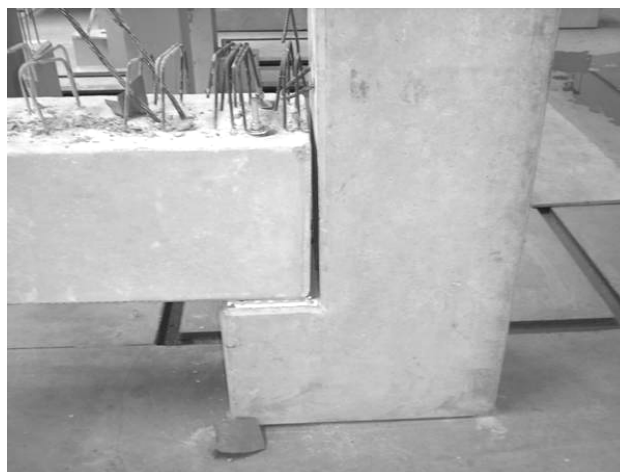
Figura 3-23: Posicionamento da viga sobre os consolos.
