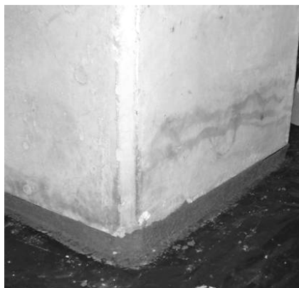
Figura 3-31: Camada de graute realizada para o adequado apoio dos pilares.
