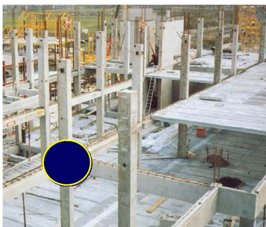
Figura 1.6: Estrutura pré-moldada semi-contínua [ELLIOTT, 2005].
