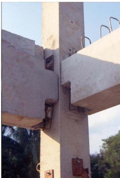
Figura 1.4: Ligação projetada inicialmente como articulada [ELLIOTT, 2005].
