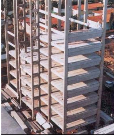
Figura 1.1: Edifício construído pela Reago em São Carlos em 1987.
