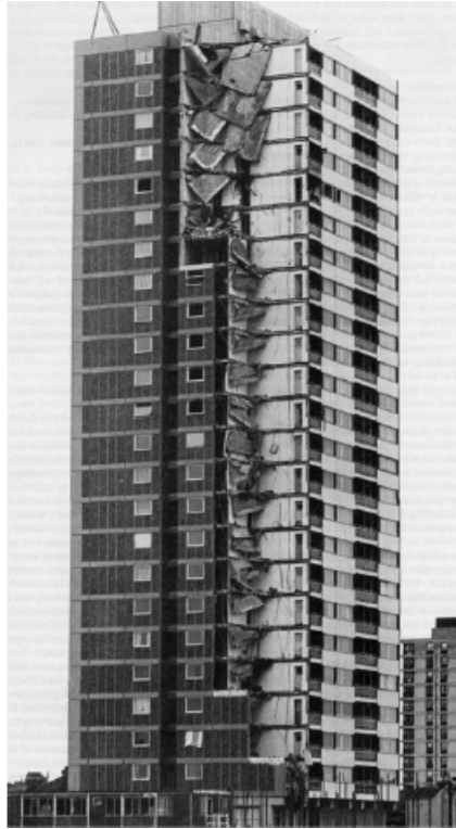
Figura 3.21: Colapso progressivo de painéis de fachada em “Ronan Point”, Londres, 1968 [ELLIOTT, 2005].
