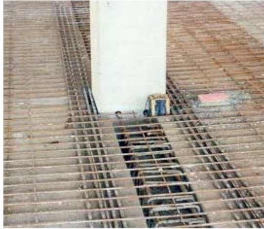
Figura 4.2: Armadura negativa de continuidade passante no pilar na altura da capa [BENTES, 2004].
