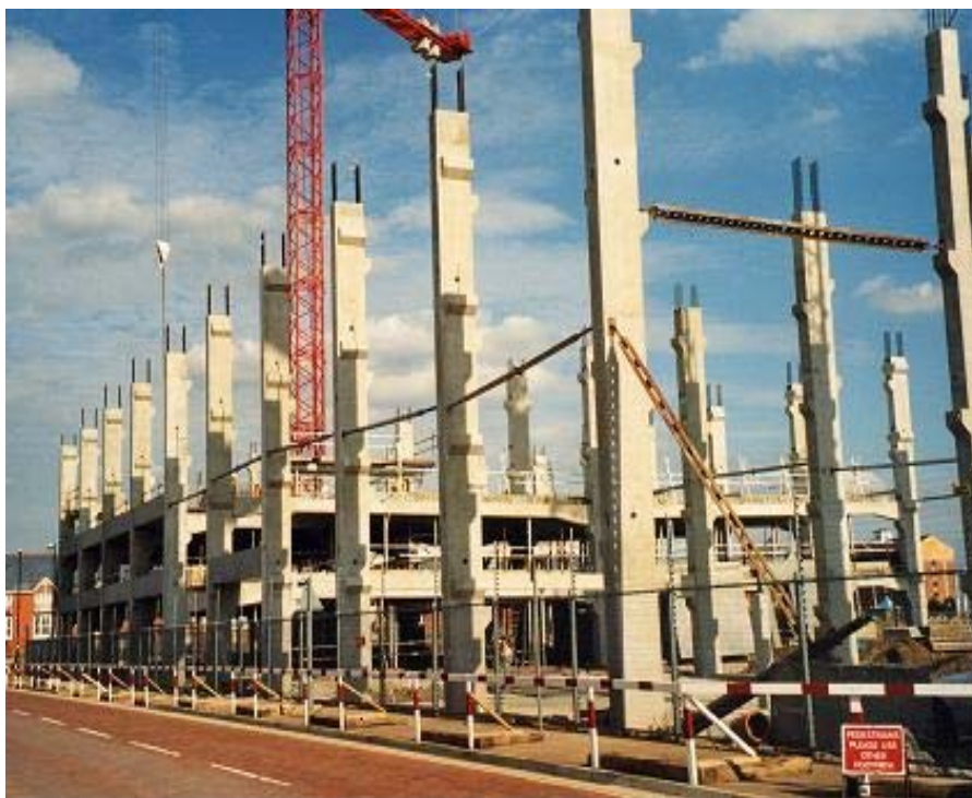
Figura 3.3: Montagem da estrutura [ELLIOTT, 2005].
