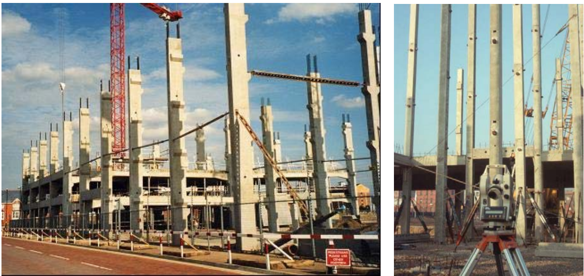
Figura 3.37: Travamento provisório dos pilares durante a etapa da montagem [ELLIOTT, 2005].
