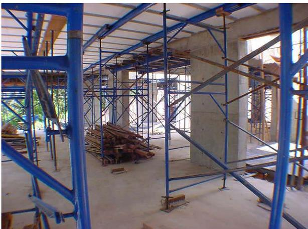
**Foto 3 – Utilização de lajes pré-moldadas, EPS e escoramento metálico (situação em janeiro de 2003)**
