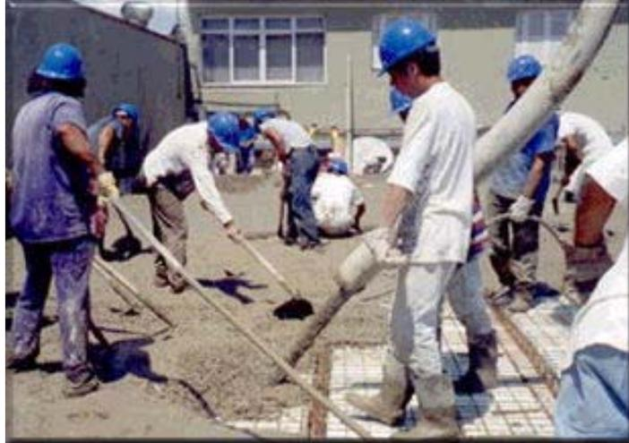
**FOTOGRAFIA 2.3- Concretagem da capa de concreto**
