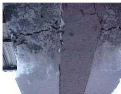
**FOTOGRAFIA 4.8- Face inferior da nervura, a fissura (ou trinca) ocorre inclusive na mesa**
