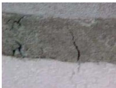
**FOTOGRAFIA 4.7 – Aparecimento da fissura na face inferior da nervura**
