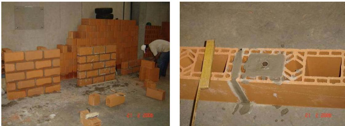
**Figuras 43 e 44 – Montagem das pequenas paredes e detalhe do tubo para passagem da barra de protensão**
