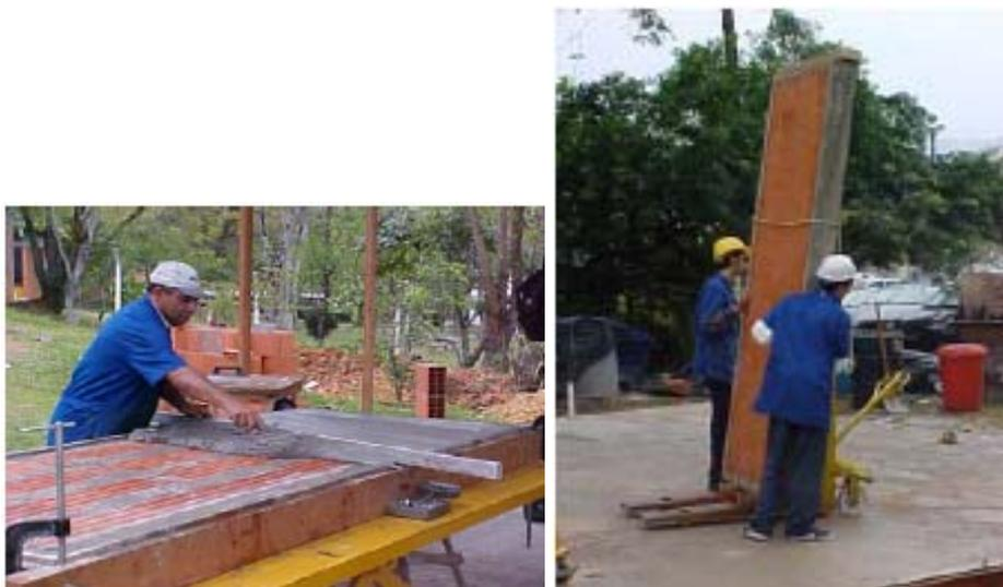
**Figura 26 e 27 – Produção dos painéis desenvolvidos pelo GDA/LABSISCO/UFSC (ROMAN et al, 2004)**
