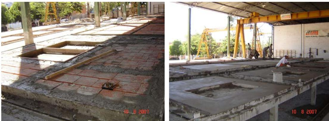
**Figuras 30 e 31 - Lançamento de concreto nas nervuras e de argamassa para revestimento dos painéis Jet Casa**
