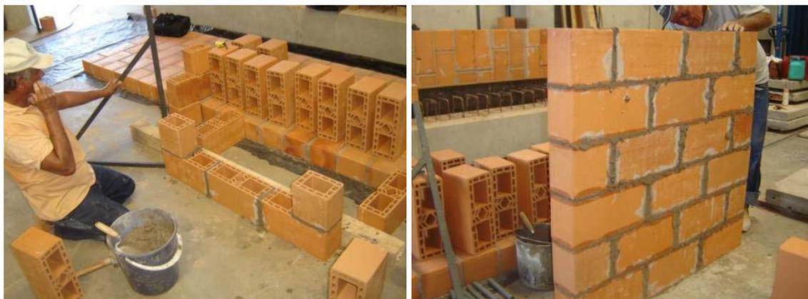
**Figuras 73 e 74 – Processo de execução de pequenas paredes para o painel 2**
