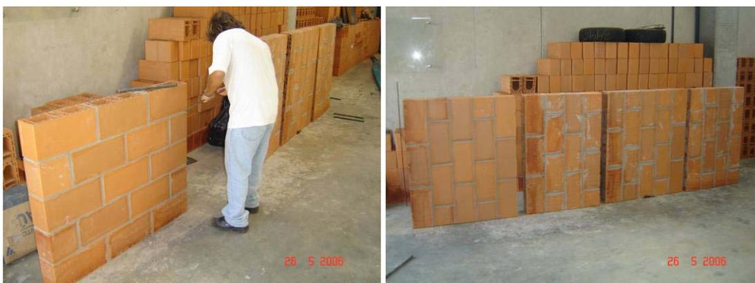
**Figuras 49 e 50 – Montagem dos painéis com rotação das paredes e inserção das barras para protensão**
