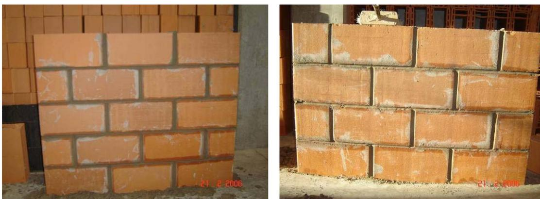
**Figuras 45 e 46 – Pequenas paredes com 5 e 4 fiadas**
