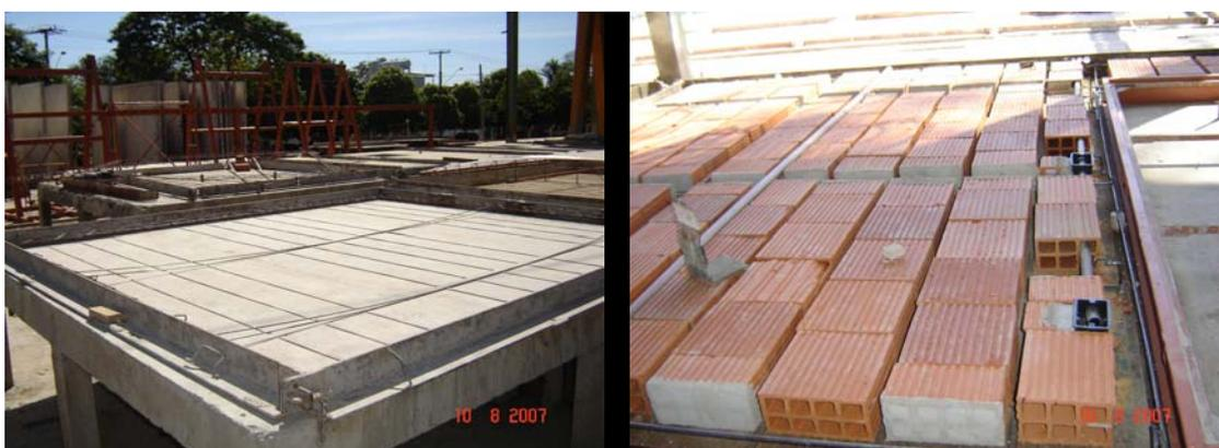
**Figuras 28 e 29 – Posicionamento, em formas, de armaduras, blocos e instalações dos painéis Jet Casa**
