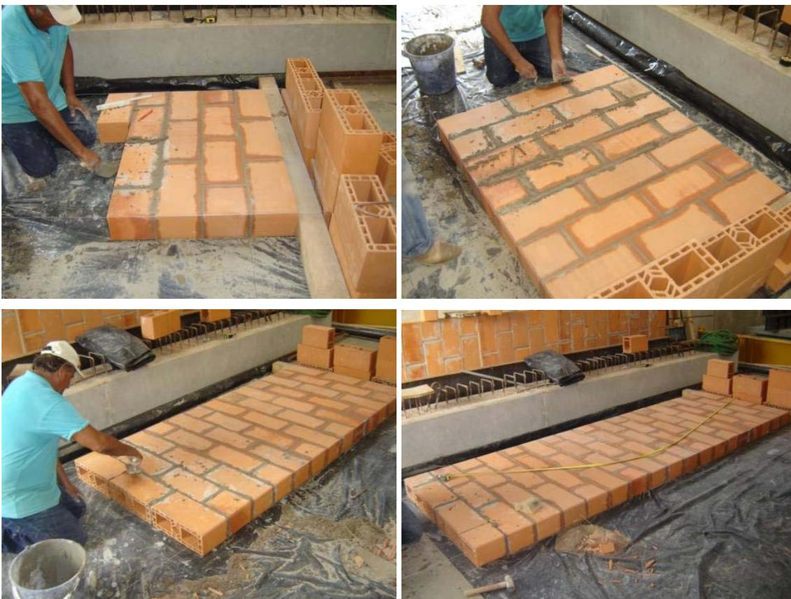
**Figuras 65, 66,67 e 68 – Processo de execução do painel 1 na posição horizontal**
