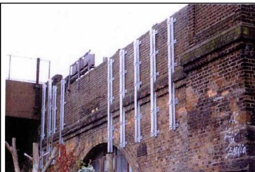
**Figura 9-Alvenaria recuperada através de protensão externa (JANSEN & TILLY, 1999)**
