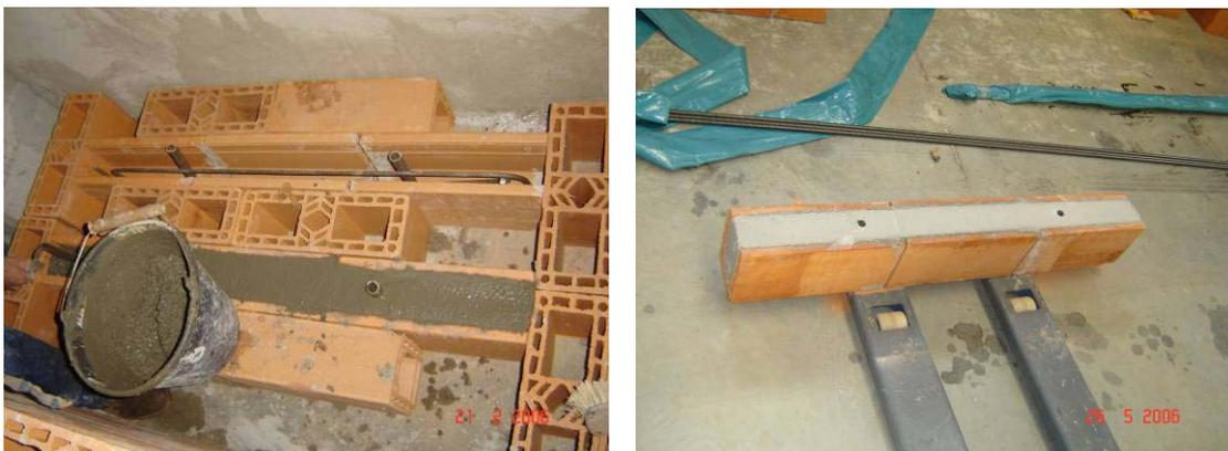
**Figuras 47 e 48 – Detalhes de execução das canaletas grauteadas para as extremidades do painel**
