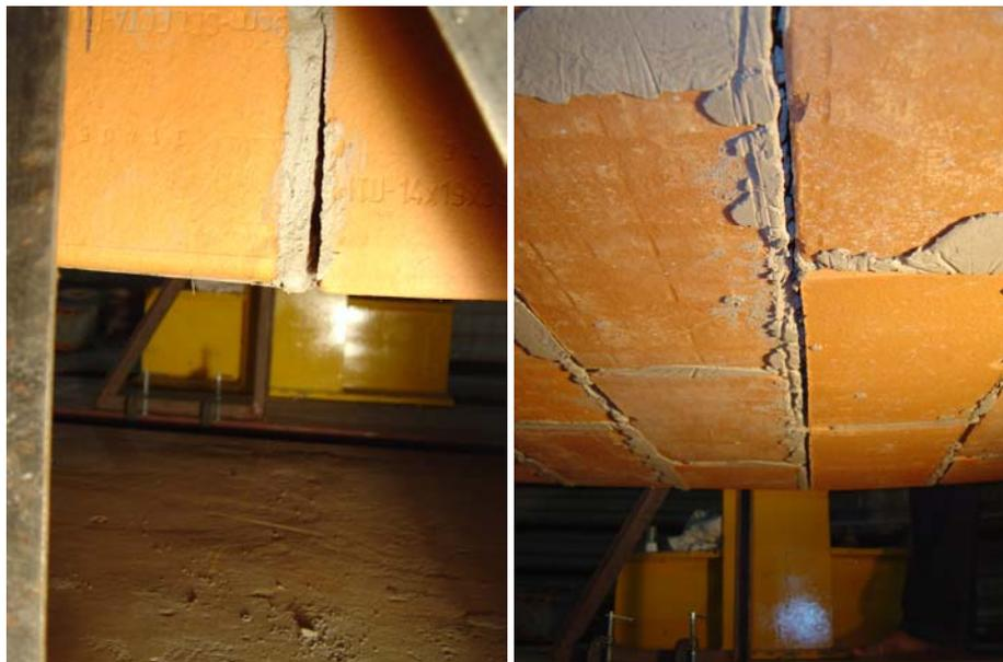
**Figuras 91 e 92- Detalhe da abertura da junta central para o painel 1**
