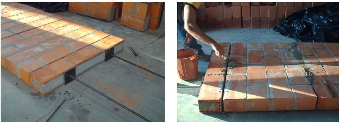
**Figuras 51 e 52 – Detalhes do preenchimento das juntas entre as pequenas paredes**
