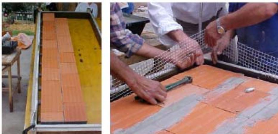
**Figuras 24 e 25 – Colocação dos blocos cerâmicos e armaduras nas formas**
