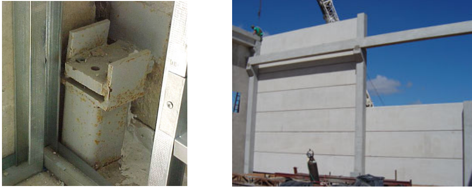
Figura 3.1: a) aspecto interno para painel de fachada arquitetônico; b) aspecto interno atualmente exigido para painéis horizontais (UEHARA).
