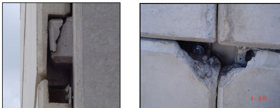
Figura 5.1: Cisalhamento do consolo de apoio de painel e quebra de painel (UEHARA)
