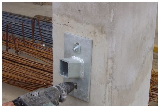
Figura 3.23: Ligação de encaixe utilizado (Leonardi Pré-fabricados Ltda)
