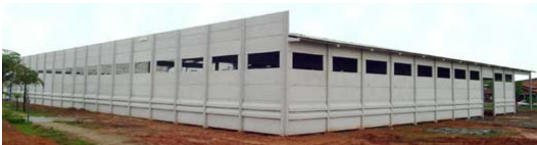
Figura 2.2: Painéis de fachada horizontais entre pilares (UEHARA)
