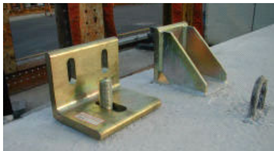
Figura 3.3: Ligações de gravidade e ligação de contraventamento adjacente (MCMULLIN,K. (2004).
