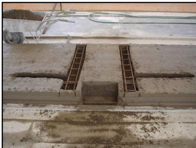
**Figura 2.7:** Reforço no recorte de pilar feito na pista.
