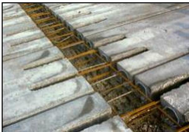
**Figura 1.13:** Armadura de continuidade do momento negativo localizada nas aberturas feitas na parte superior das unidades alveolares (fonte: Ferreira, 2007).
