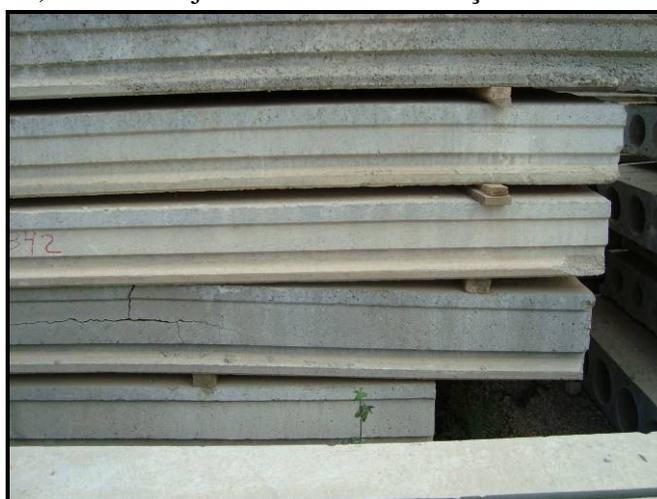
b) Lajes com fissuras devida a estoque com calços desalinhados.
