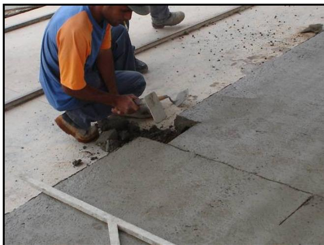
**Figura 2.6:** Execução de um recorte de pilar em concreto fresco.
