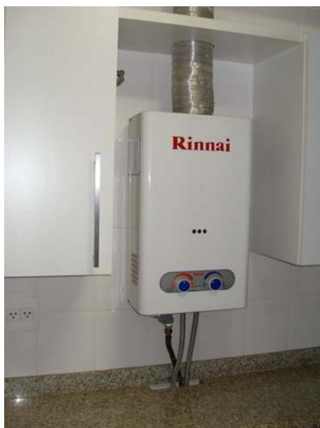
**Figura C.2** – Aquecedor de passagem instalado na área de serviço
