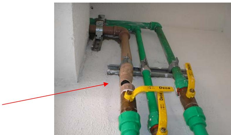
**Figura E.6** – Tubo de alimentação de água fria derretido
