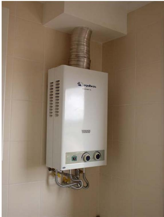
**Figura 2.3** – Sistema Individual (aquecedor de passagem a gás) – alimenta único ponto
