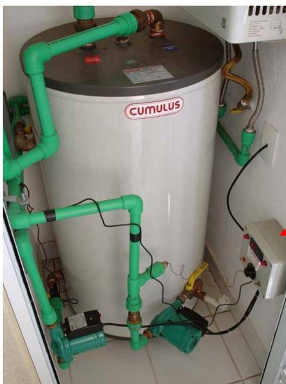
**Figura 4.9** – Controlador digital de funcionamento automático do sistema
