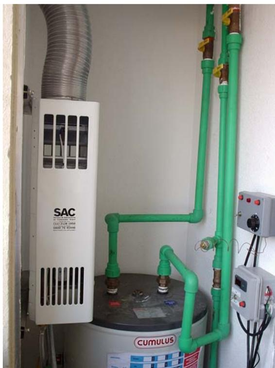
**Figura 4.8** – Altura dos registros de operação (em torno de 2,0m)
