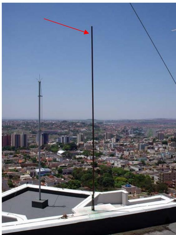
**Figura 2.15** – Respiro no sistema predial de água quente
