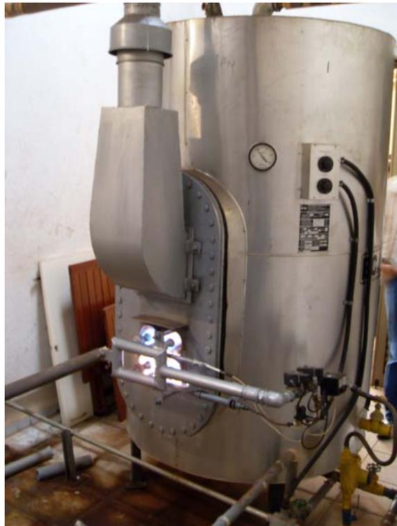
**Figura 2.11** - Geradora de água quente vertical
