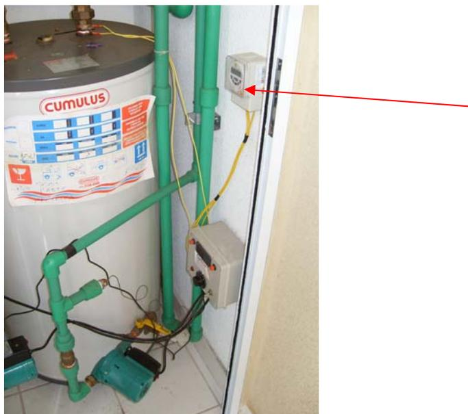
**Figura E.2** – Timer para controle dos períodos de funcionamento do sistema
