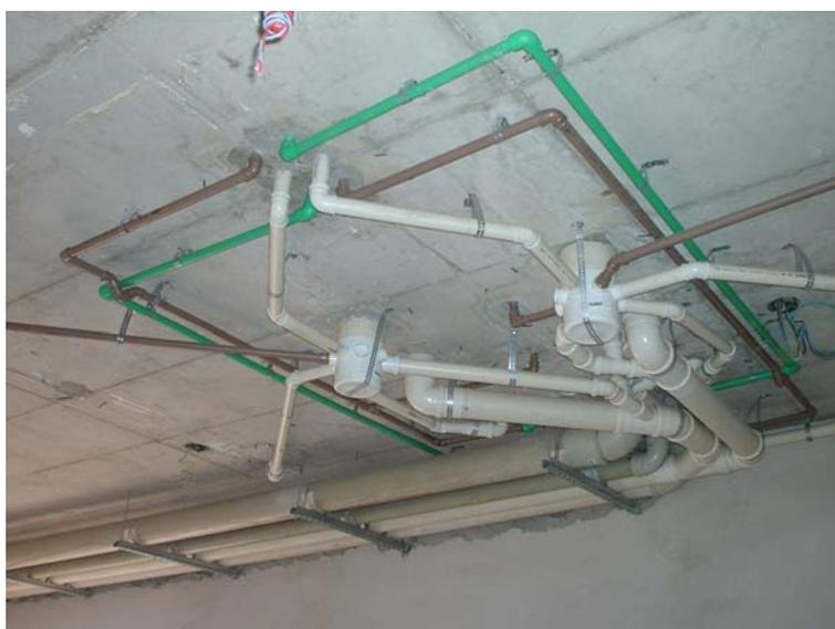
**Figura 4.4** – Fixação da tubulação antes da execução do forro de gesso
