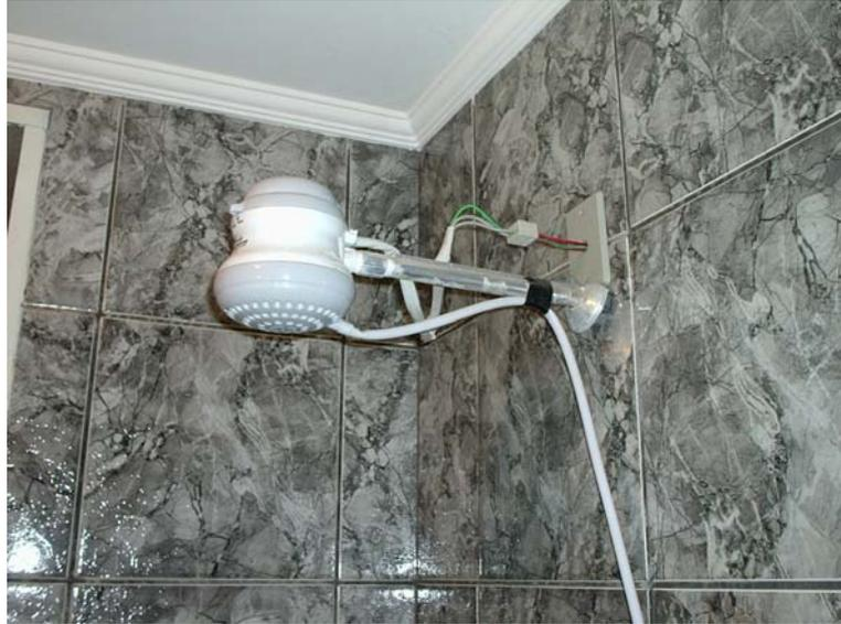
**Figura 2.2** – Sistema Individual (chuveiro elétrico)
