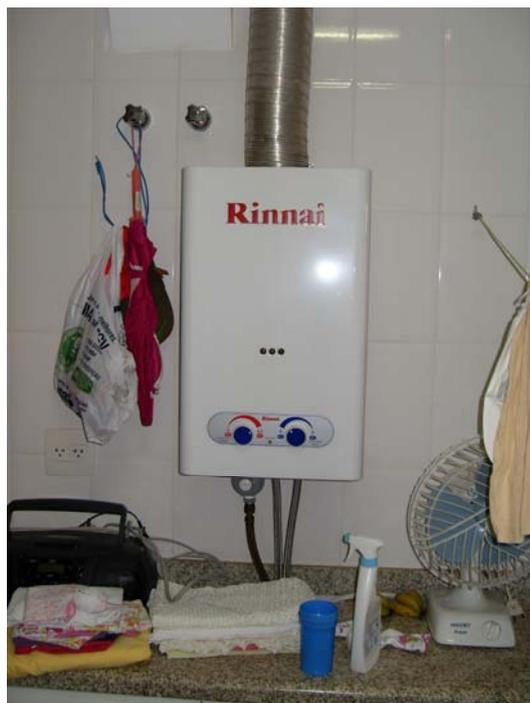
**Figura 4.2** – Condições de instalação do aquecedor
