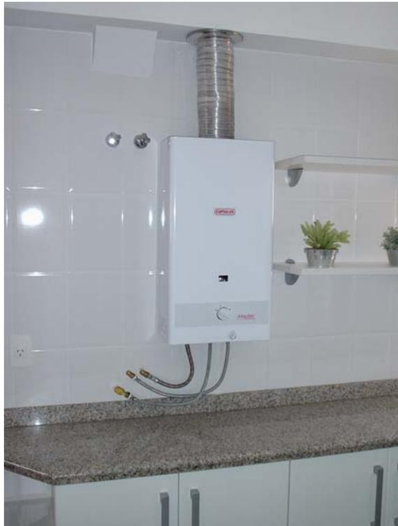
**Figura 2.4** – Sistema Central Privado (aquecedor de passagem a gás) – sem recirculação
