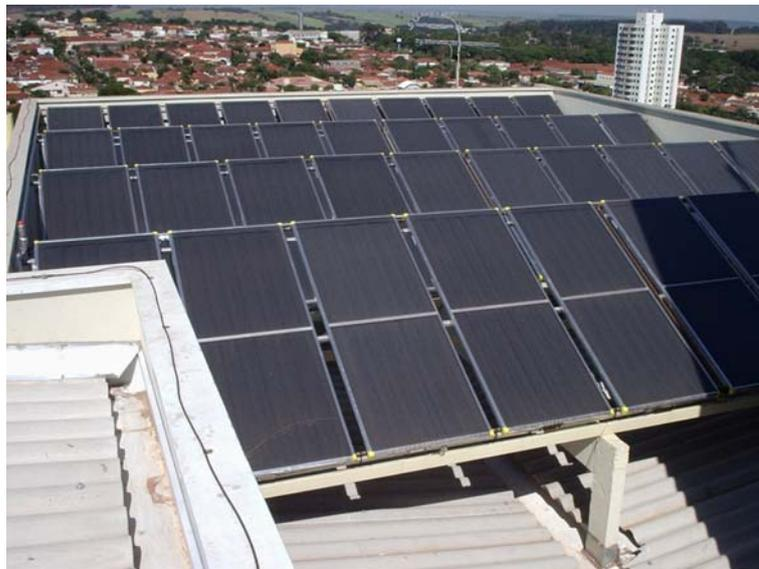
**Figura 2.7** – Sistema de aquecimento solar predial
