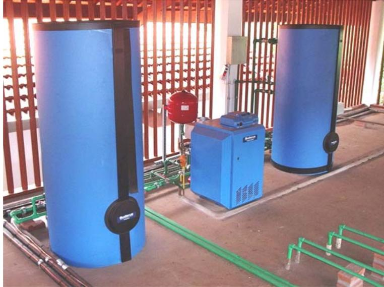
**Figura 2.8** – Geradora de água quente de alta eficiência, com trocadores de calor de 500 litros
