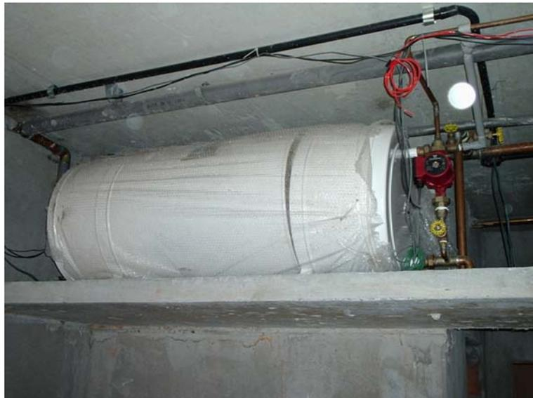
**Figura 2.6** - Sistema Central Privado (sistema acumulação elétrico) – com recirculação
