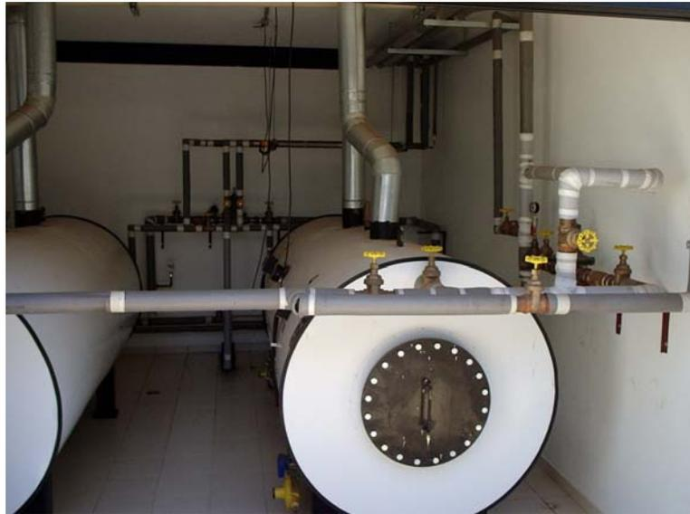
**Figura 2.9** – Geradoras de água quente horizontal, com aquecimento indireto
