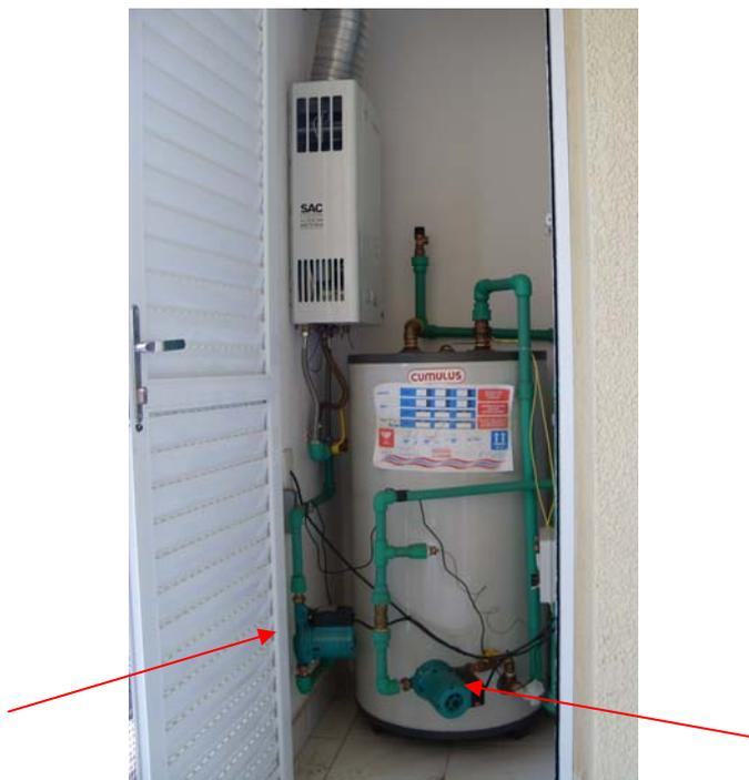
**Figura D.2** – Sistema conjugado com bomba principal (lateral) e secundária (frente)
