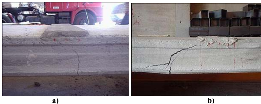
Figura 4.14: Ensaio de Flexão - Abertura de fissura para laje com vão de 3,0m: a) Vista lateral - lado esquerdo; b) Vista lateral - lado direito.
