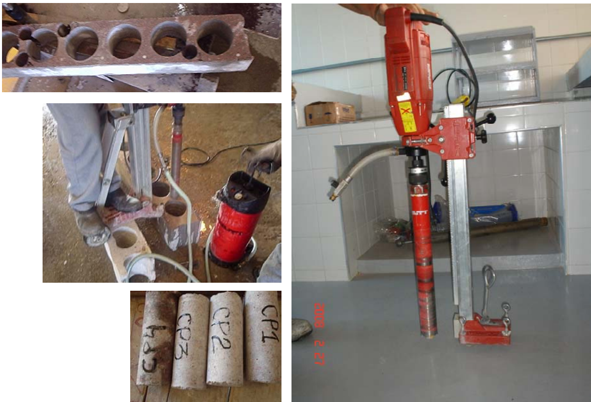
Figura 3.9: Equipamento para extração de testemunhos de concreto para laje alveolar.
