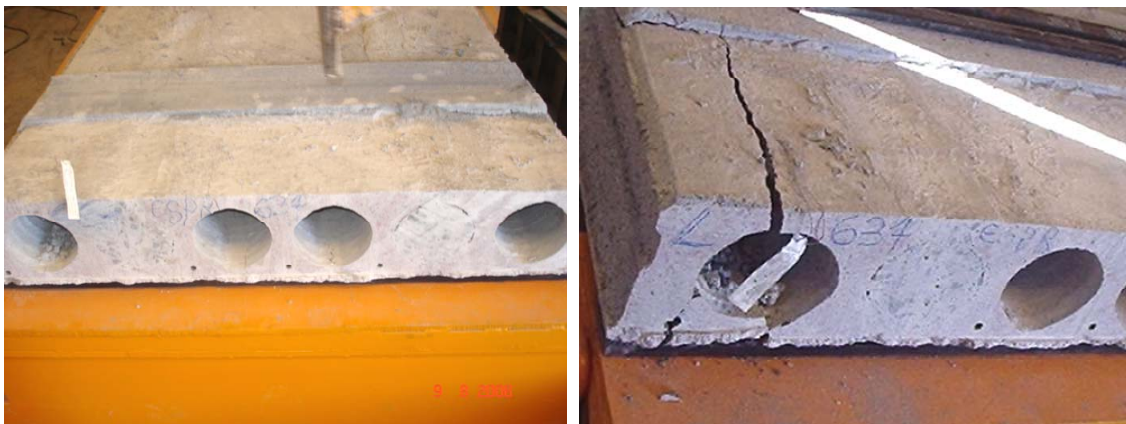
Figura 4.40: Falha por torção em nervura da extremidade (dois alvéolos preenchidos).
