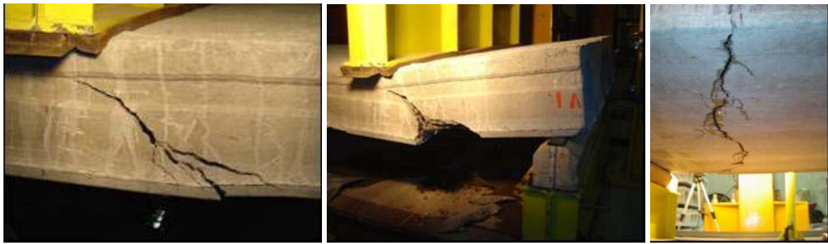
a) b) c) Figura 4.34: Configuração de fissuração da laje L01-SC-AP-6_C: a) e b) Fissuração da parte lateral (lado esquerdo); c) Fissuração da parte inferior da laje.
