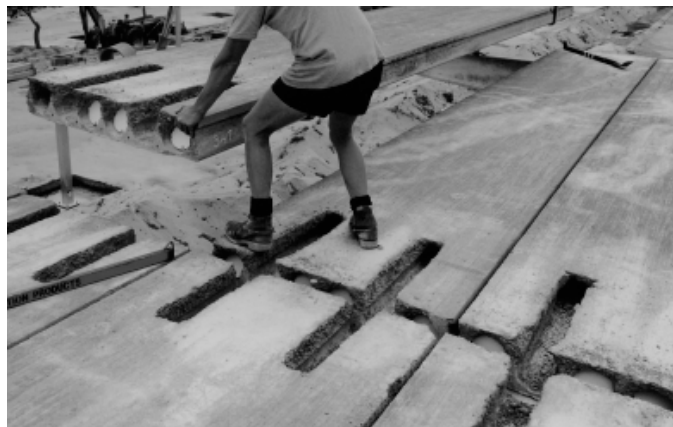
Figura 1.5: Recortes para a colocação de tirantes [NPCAA(2003)].
