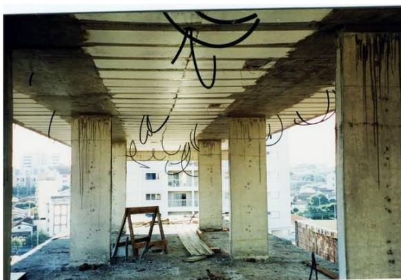
Figura 4.4.3-5 - Estrutura após a retirada das fôrmas e dos escoramentos. Fonte: arquivo do autor.
