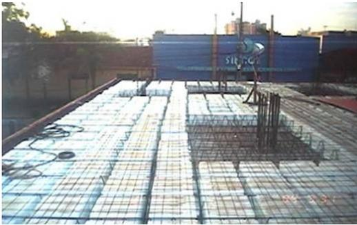
Figura 6.5-3 - Detalhe da armação da região do Ábaco. Fonte: arquivo do autor.
