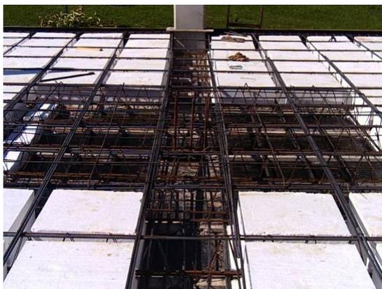
Figura 4.4.3-9 - Lajes Lisas Nervuradas Bidirecionais com vigotas pré-fabricadas com vigas de borda na espessura da laje. Fonte: arquivo do autor.
