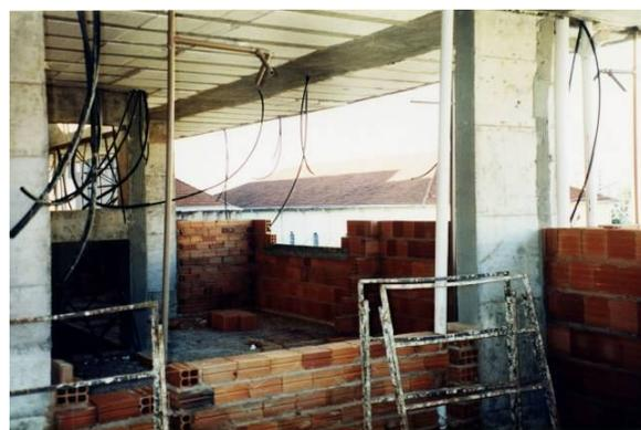
Figura 4.4.3-6 – Racionalização na execução das alvenarias. Fonte: arquivo do autor.
