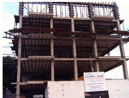
Figuras 4.4.3-4 - Lajes Lisas nervuradas unidirecionais com vigas-faixas e vigotas treliçadas. Fonte: arquivo do autor.
