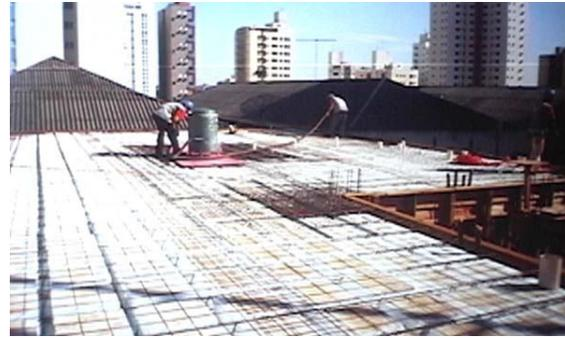
Figura 6.5-6 - Limpeza da laje antes da concretagem. Fonte: arquivo do autor.
