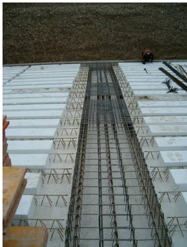
Figura 4.4.3-7 – Detalhe de apoio das vigotas treliçadas em vigas-faixas pré-fabricadas. Fonte: <http://www.assobeton.it>
