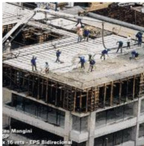
Figura 4.4.3-8 - Lajes Lisas Nervuradas Bidirecionais com vigotas treliçadas. Fonte: arquivo do autor.
