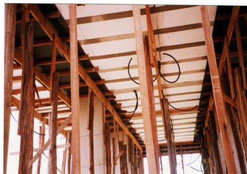
Figura 4.4.3-2- Detalhes das formas e escoramentos das vigas-faixas. Fonte: arquivo do autor.
