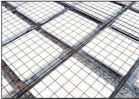
Figura 6.5-5 - Detalhe das armações das nervuras. Fonte: arquivo do autor.
