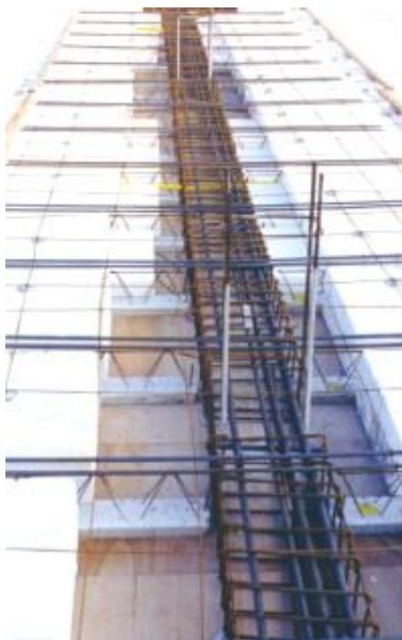
Figura 4.6.3-11 - Condição de continuidade para apoios internos. Fonte: arquivo do autor.
