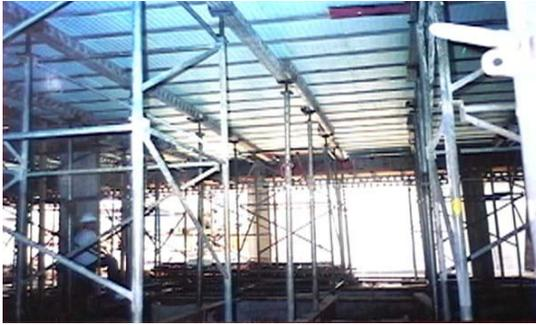
Figura 6.5-1 - Montagem da laje e escoramentos. Fonte: arquivo do autor.
