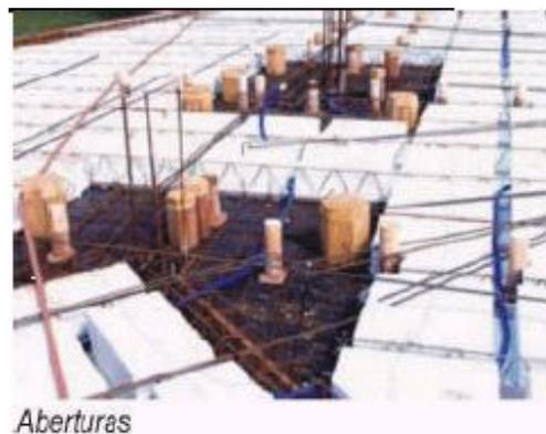
Figura 4.6.3-15 - Instalações hidráulicas e elétricas. Fonte: Vizotto (2002).
