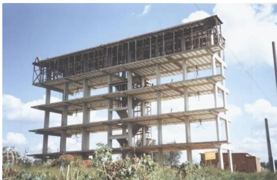
Figura 4.4.3-1 - Lajes Lisas nervuradas unidirecionais com vigas-faixas e vigotas treliçadas. Fonte: arquivo do autor.
