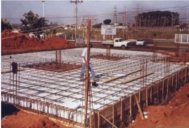
Figura 4.4.3-11 - Lajes Lisas Nervuradas Bidirecionais com vigotas pré-fabricadas treliçadas e vigas de borda na espessura da laje.
