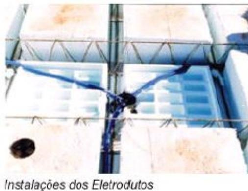
Figura 4.6.3-14 - Instalações hidráulicas e elétricas. Fonte: Vizotto (2002).
