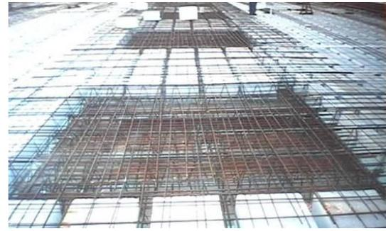
Figura 6.5-4 - Detalhe da armação da região do Ábaco. Fonte: arquivo do autor.
