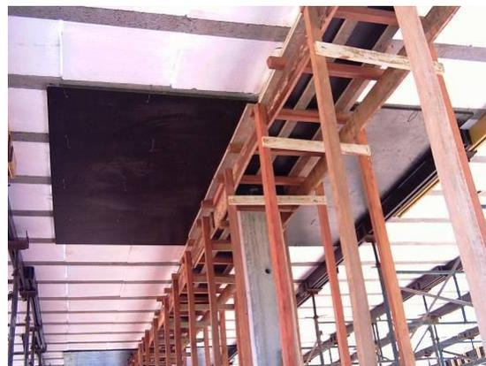
Figura 4.4.3-10 – Detalhe das formas do Ábaco e viga-faixa. Fonte: arquivo do autor.
