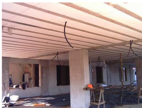
Figura 4.4.3-3 - Lajes Lisas nervuradas unidirecionais com vigas-faixas e vigotas treliçadas. Fonte: arquivo do autor.
