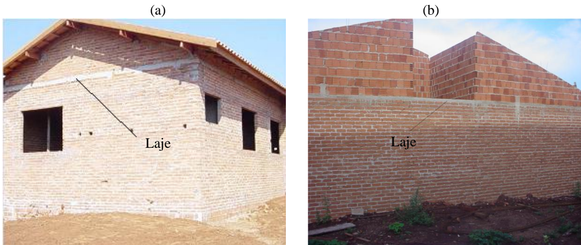
Figura 2.2 - Uso de tijolo maciço e bloco cerâmico de vedação com função resistente.
