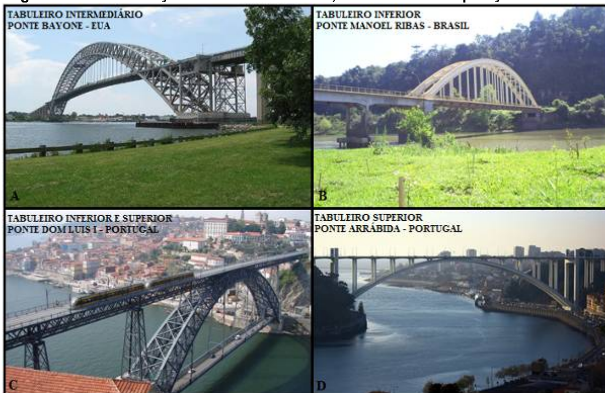
Figura 2.9 - Classificação das Pontes em Arco, de acordo com a posição do tabuleiro
