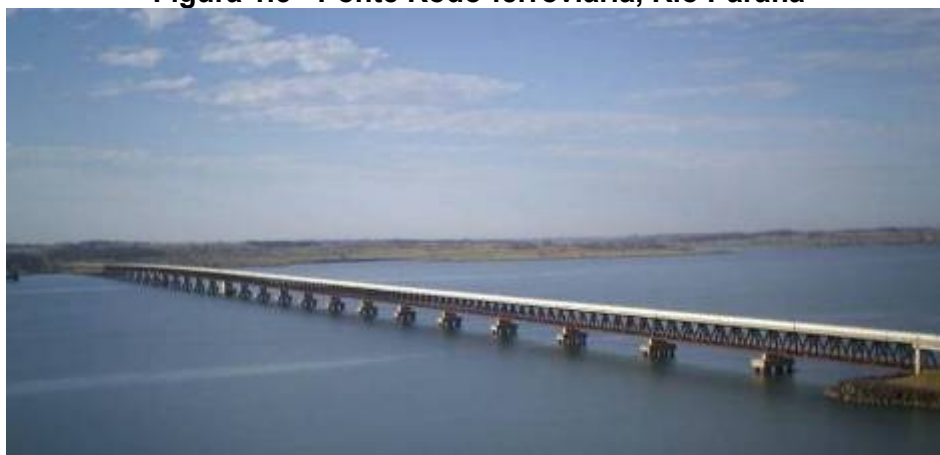
Figura 1.5 - Ponte Rodo-ferroviária, Rio Paraná
