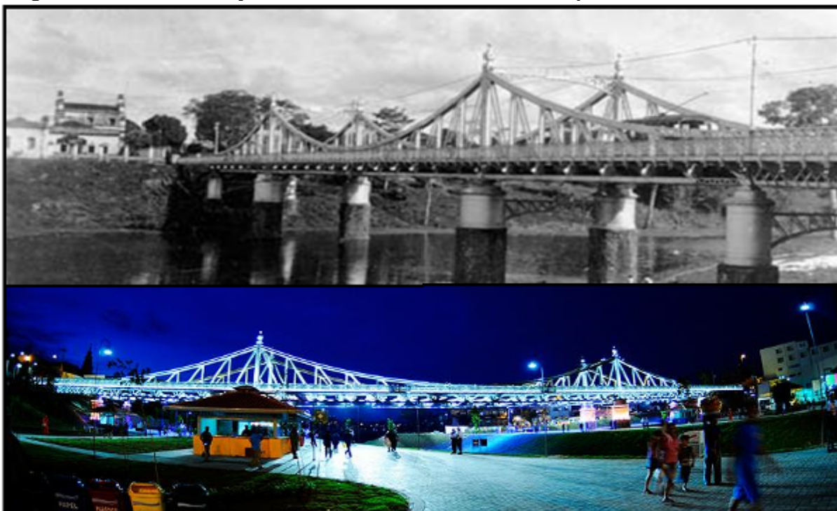
Figura 2.11 - Ponte Benjamin Constant, Manaus, antes e após reforma e restauração
