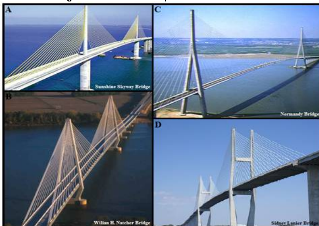
Figura 2.15 - Diferentes Tipos de Pontes Estaiadas
