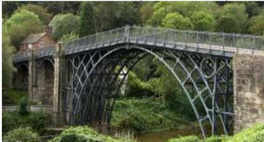
Figura 1.2 - Ponte em ferro fundido, sobre o rio Severn, 1777 a 1779
