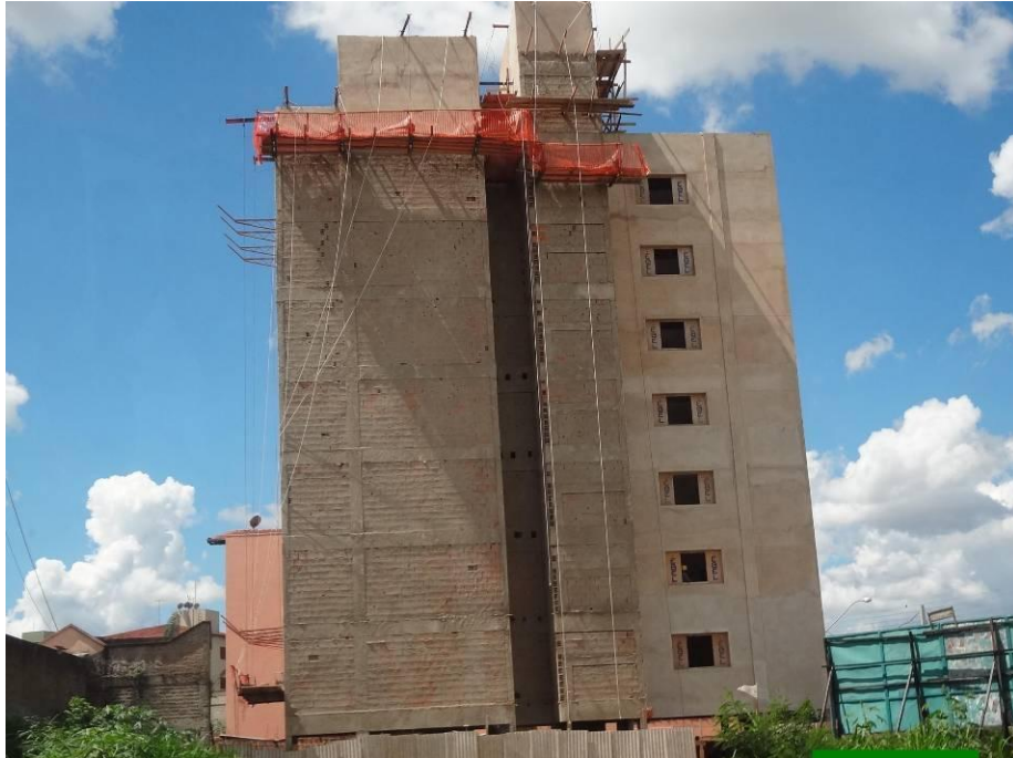
Figura 4.8 – Empreendimento D3 Fonte: Autor, Novembro de 2011
