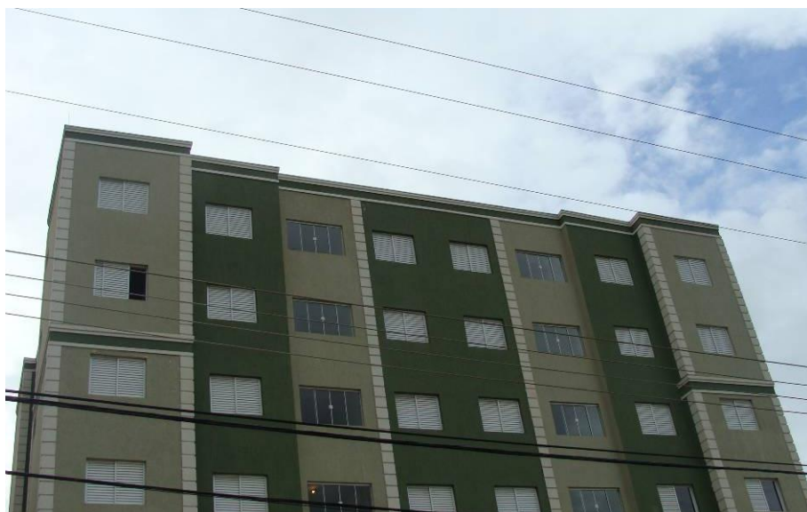
Figura 4.2 – Empreendimento A2 Fonte: Autor, Novembro de 2011
