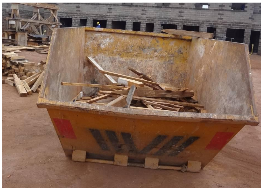
Figura 4.24 – Resíduos de madeira separado em caçamba Fonte: Autor, Novembro de 2011
