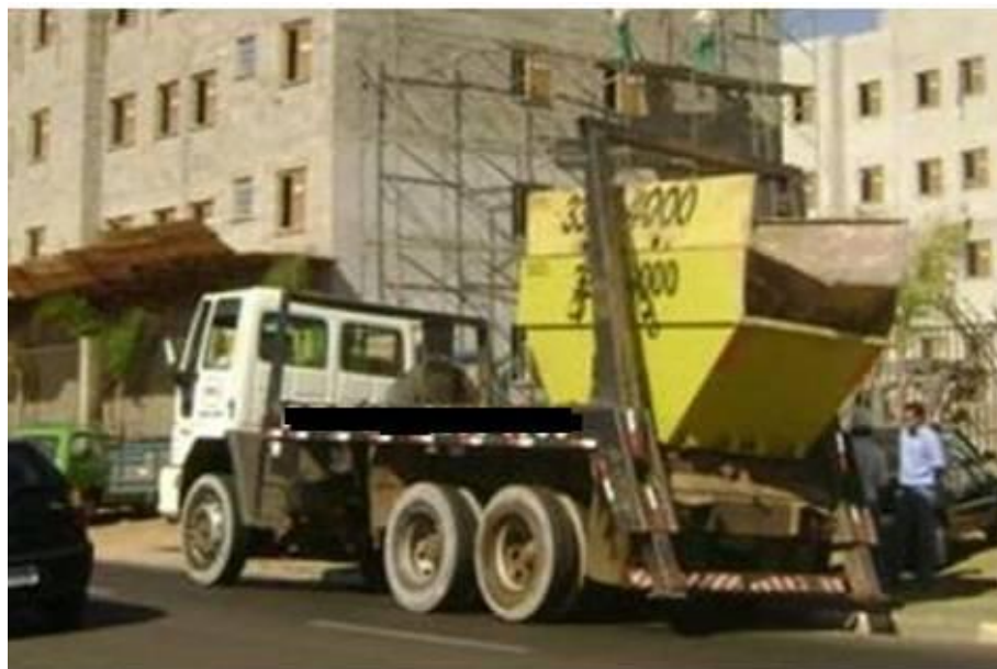
Figura 4.23 – Transporte de caçamba por poliguindaste Fonte: Autor, Novembro de 2010
