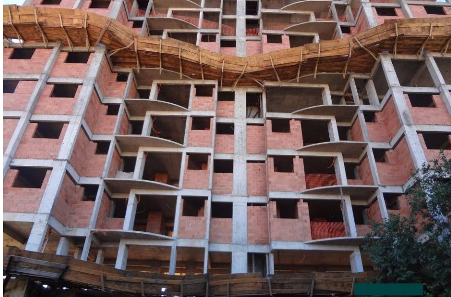
Figura 4.1 – Empreendimento A1 Fonte: Autor, Novembro de 2011
