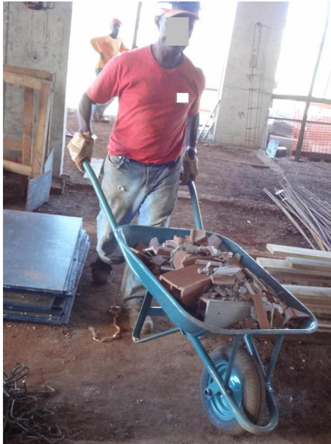
Figura 4.26 – Funcionário transportando RCC Fonte: Autor, Outubro de 2011
