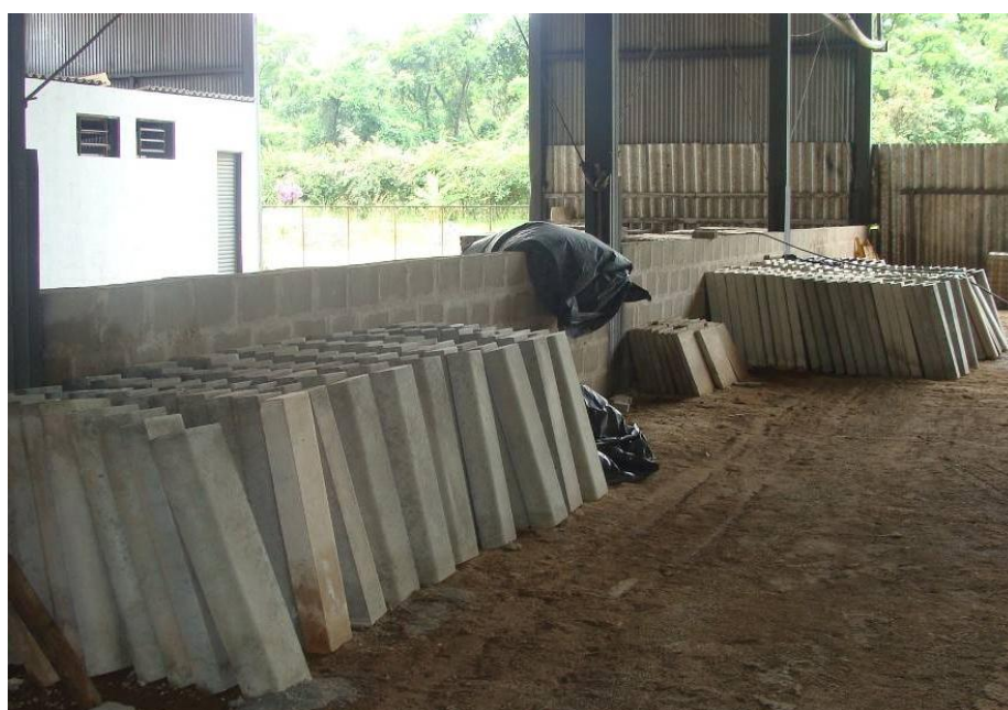
Figura 4.57 - Guias e mini-guias de concreto produzidos na FAC, com adição de agregados reciclados Fonte: Autor, Dezembro de 2011
