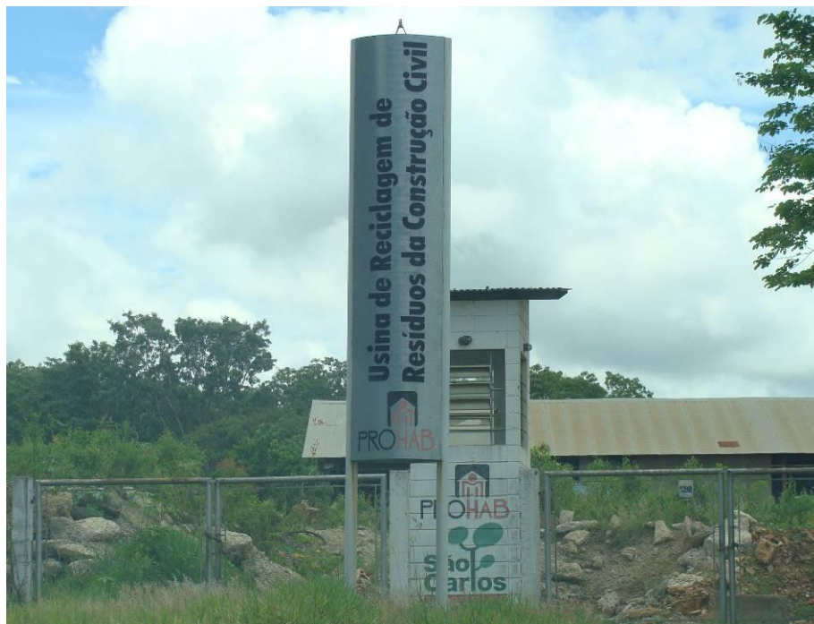
Figura 4.36 - Portaria para acesso de descarte de RCC da Usina de Reciclagem de Resíduos da Construção Civil de São Carlos Fonte: Autor, Dezembro de 2011
