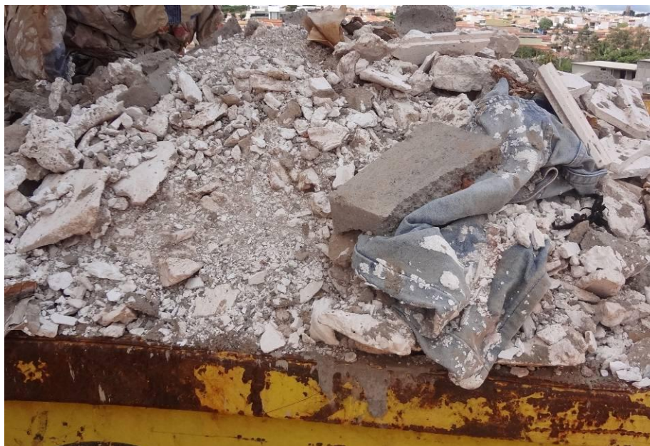
Figura 4.28 – Resíduos de gesso misturado a outros tipos de resíduos Fonte: Autor, Novembro de 2011
