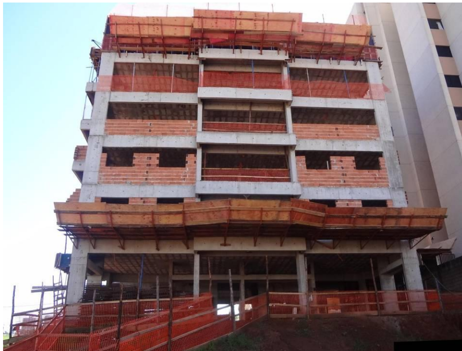
Figura 4.7 – Empreendimento D2 Fonte: Autor, Novembro de 2011
