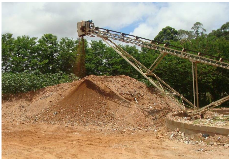
Figura 4.44 - Momento do processo de triturar o RCC – Bica Corrida Fonte: Autor, Dezembro de 2011
