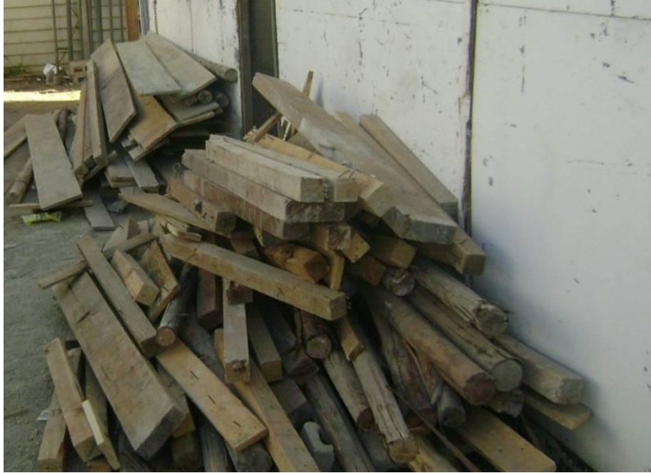
Figura 4.25 – Resíduo de madeira armazenado no canteiro de obra Fonte: Autor, Outubro de 2011
