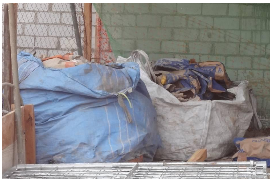
Figura 4.32 – Sacos de cimento vazios armazenados em big bags . Fonte: Autor, Setembro 2011.
