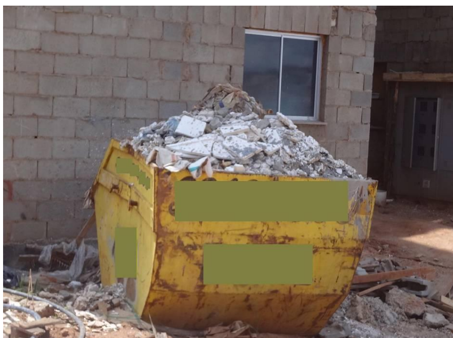
Figura 4.27 – Resíduos de gesso misturado a outros tipos de resíduos Fonte: Autor, Novembro de 2011
