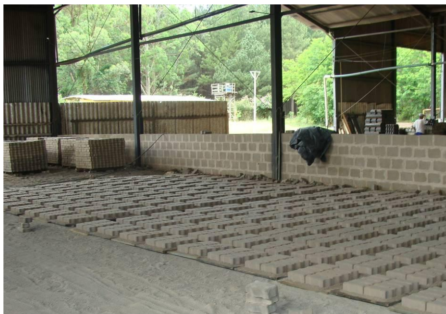
Figura 4.37 - Galpão - Fábrica de Artefatos de Cimento (FAC) Fonte: Autor, Dezembro de 2011
