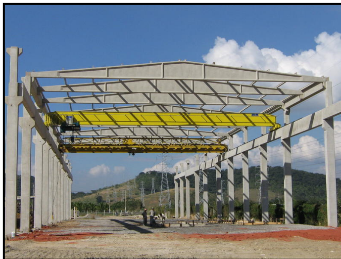
Figura 4.1- Galpão com ponte rolante.
