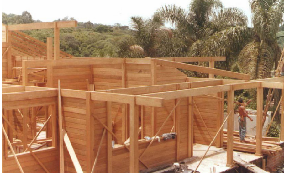
Figura 19 – Sistema construtivo tipo viga-pilar
