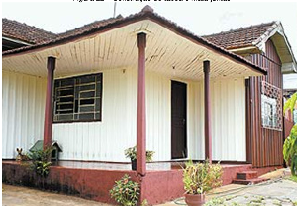
Figura 22 – Construção de tábua e mata-juntas
