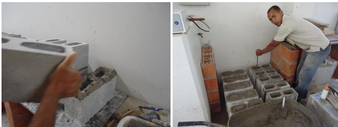
Figura 20 - Montagem e grauteamento dos prismas.
