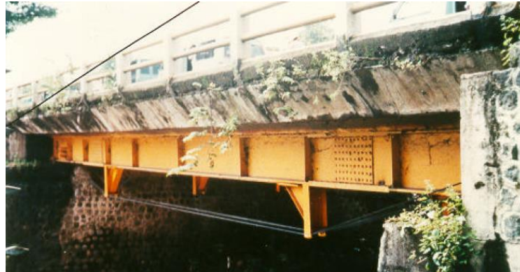
Figura 3.14 – Desviadores para posicionamento do cabo abaixo do perfil metálico
