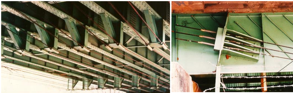
Figura 3.24 – Ponte de Condet, Indonésia – visão geral e detalhe de ancoragem
