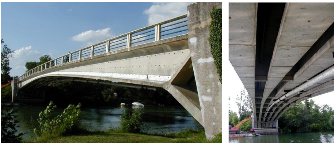
Figura 2.2 – Ponte de “Annet-sur-Marne”, França
