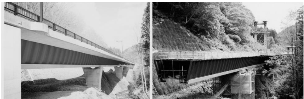
Figura 2.23 – Ponte “Ginzan-Miyuki” (completa e durante a fase de construção)
