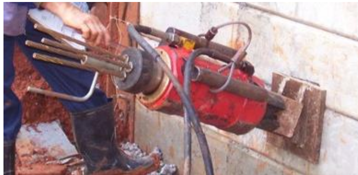
Figura 3.20 – Macaco de protensão
