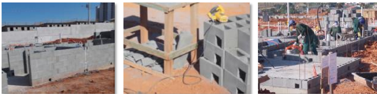
Figura 49 - Janelas para verificação de groute
