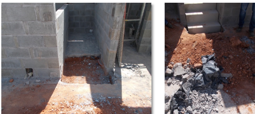
Figura 51 - Quebra do contrapiso para permitir a colocação da escada
