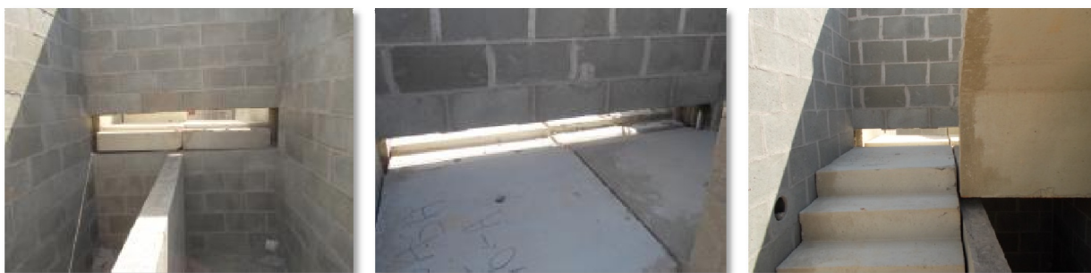
Figura 50 - Abertura necessária na alvenaria para engastamento da escada pré-fabricada
