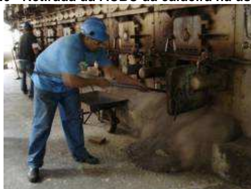
Figura 26 - Retirada da ACBC da caldeira na usina
