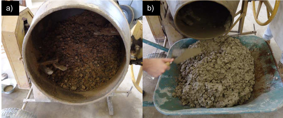
Figura 44 – Agregados misturados na betoneira (a) concreto fresco (b)
