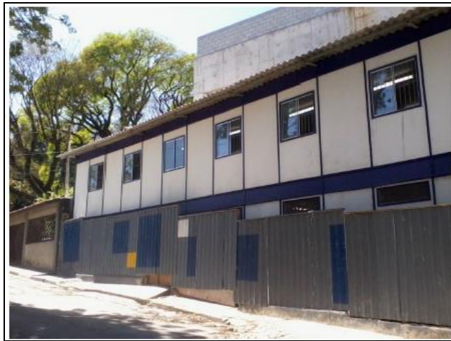
Figura 12: Fachada do canteiro de obra com material USB
