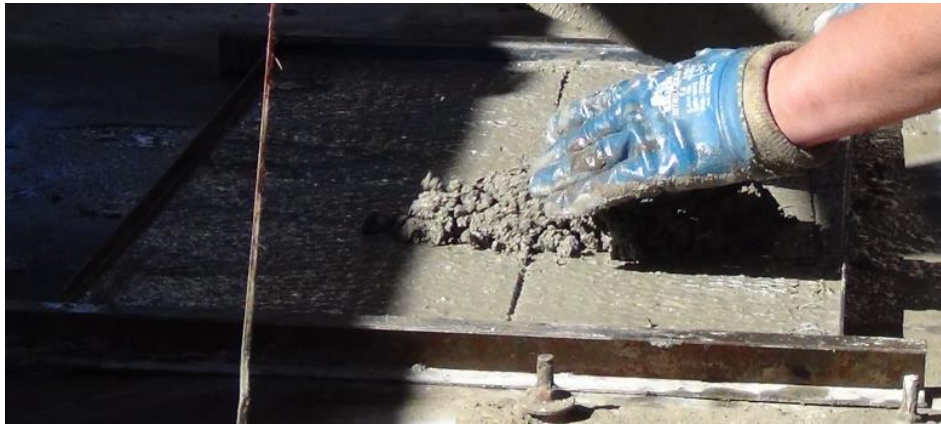
Figura 34: Concretagem, colocação da tela galvanizada
