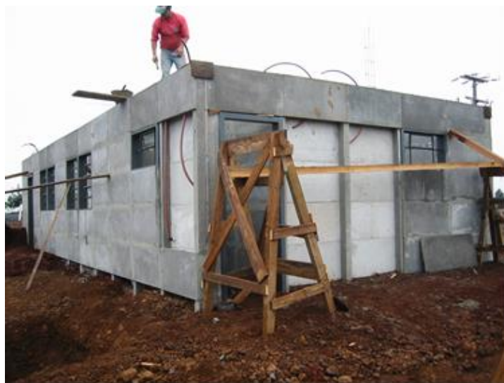
Figura 41: Construção de 75m 2 na cidade de Candói, interior do Paraná
