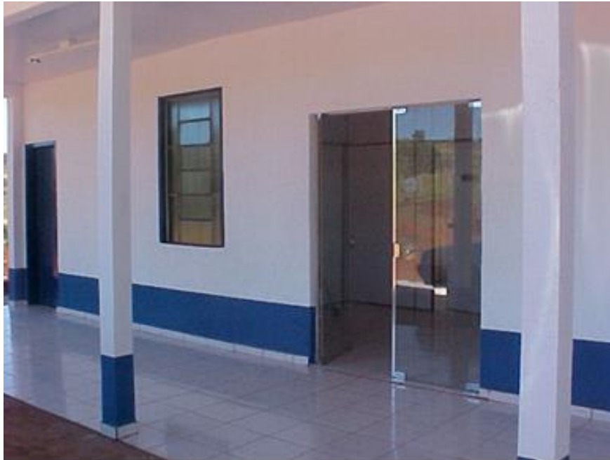
Figura 43: Paredes acabadas sem uso de chapisco e sem uso de reboco
