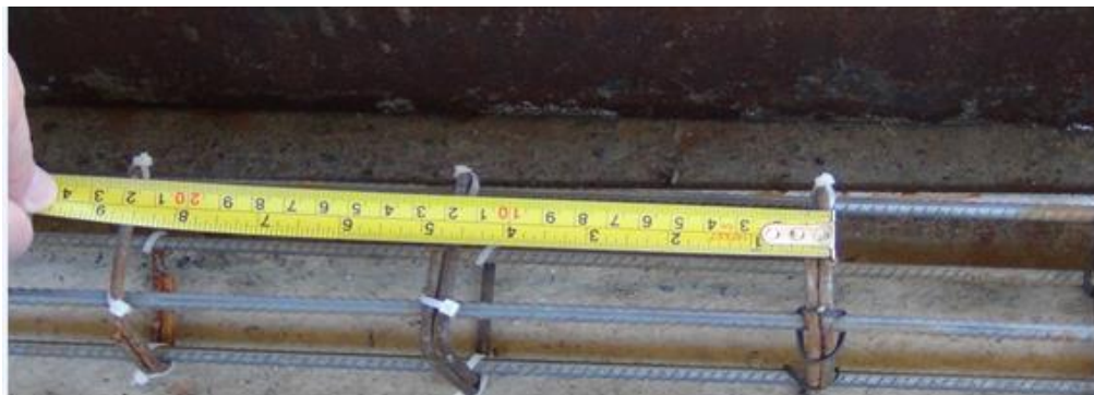
Figura 36: Armadura dos montantes estruturais
