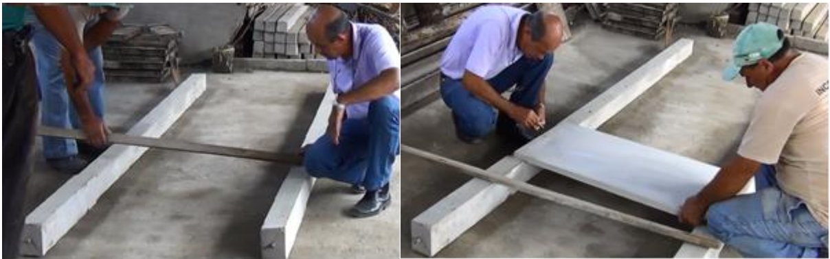
Figura 39: Fixação das placas nos montantes, montagem de um painel no solo
