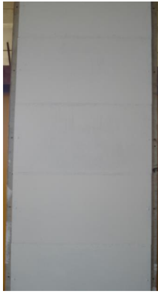
Figura 40: Painel montado e posicionado
