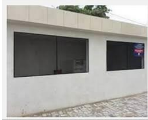
Figura 10: Uso da alvenaria cerâmica para instalações provisórias
