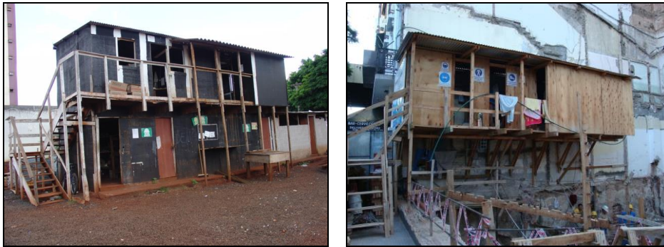
Figura 2: Instalações provisórias em madeira para canteiros de obras
