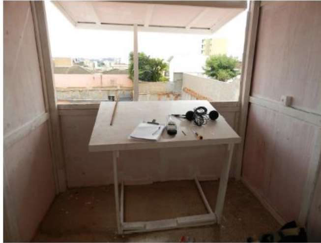
Figura 11: Instalação provisória em chapa de madeira
