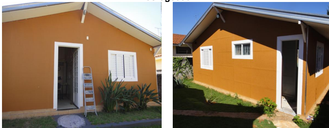
Figura 2.20 - Protótipo construído em São Carlos (SP) com placas de fosfogesso
