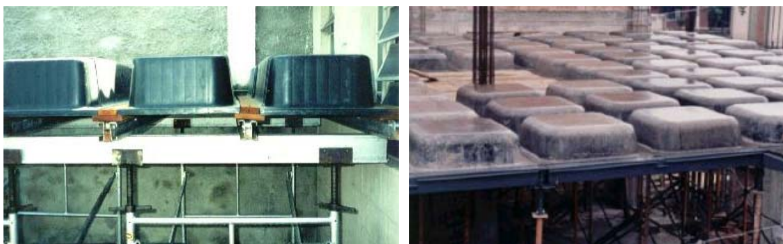
FIGURA 3.26. Exemplos de sistemas de escoramento de fôrmas de polipropileno (www.atex.com.br)
