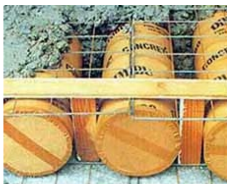
FIGURA 3.15. Laje nervurada com tubos de papelão como material de enchimento (www. dimibu.com.br)
