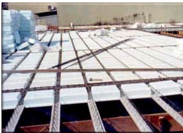
FIGURA 4.9. Laje com vigotas treliçadas e com blocos de poliestireno expandido ( www.comunidade-da-construcao.com.br )
