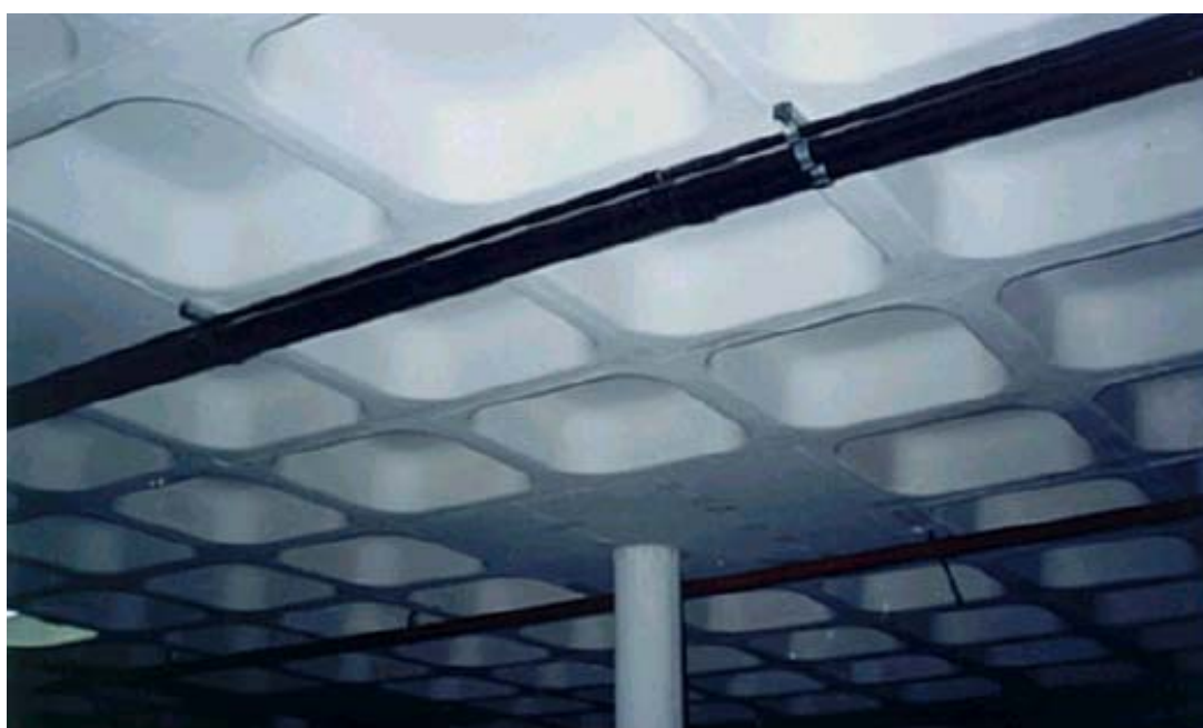
FIGURA 3.18. Laje nervurada construída com fôrmas de polipropileno (www.atex.com.br)
