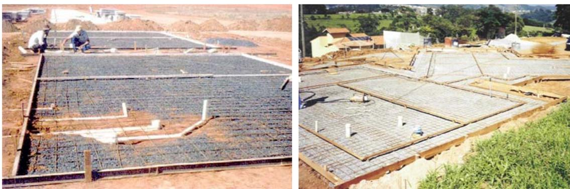
Figura 16 – Radier e gabarito para montagem dos painéis no sistema Premium
