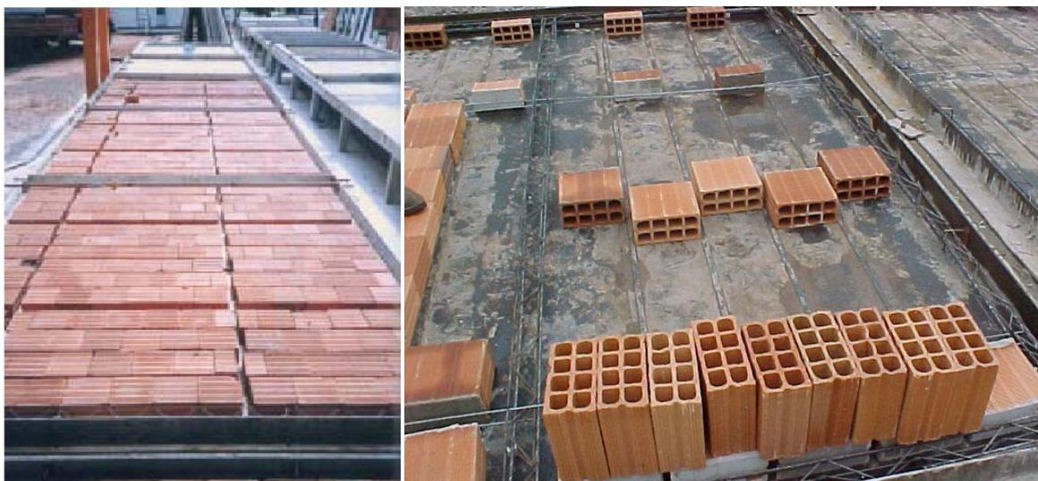
Figura 24 – Montagem dos painéis Jet Casa
