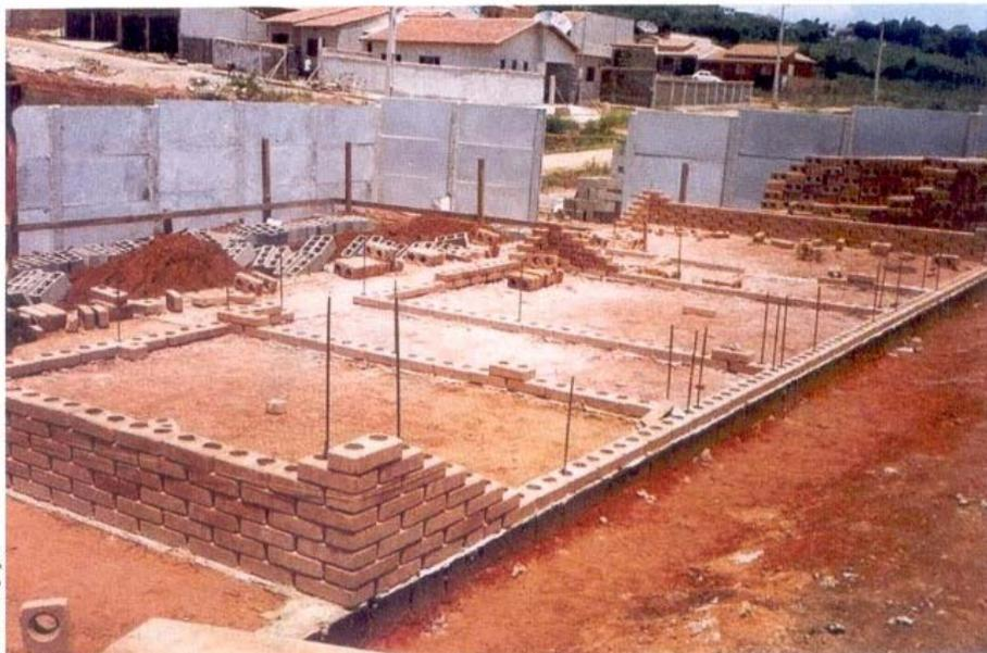
Figura 11 – Lançamento da fiada de marcação no sistema Tijolito
