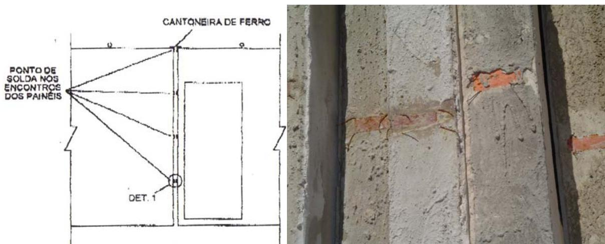
Figura 40 – Detalhe dos pontos de solda nos encontros dos painéis
