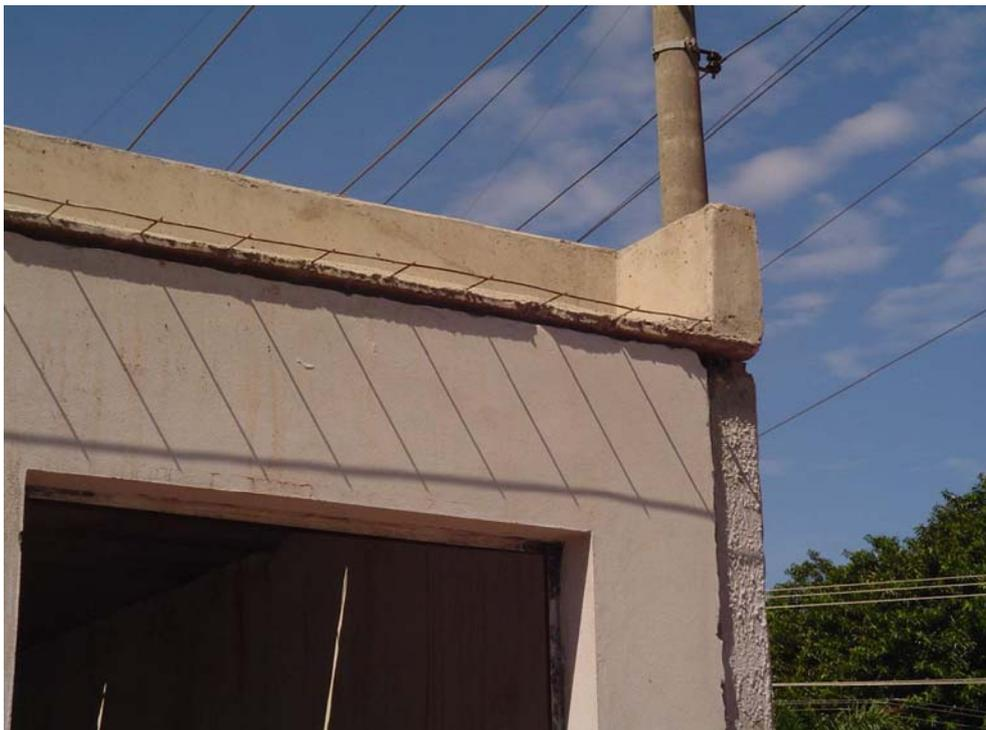
Figura 44 – Painéis de laje montados sobre os painéis de parede
