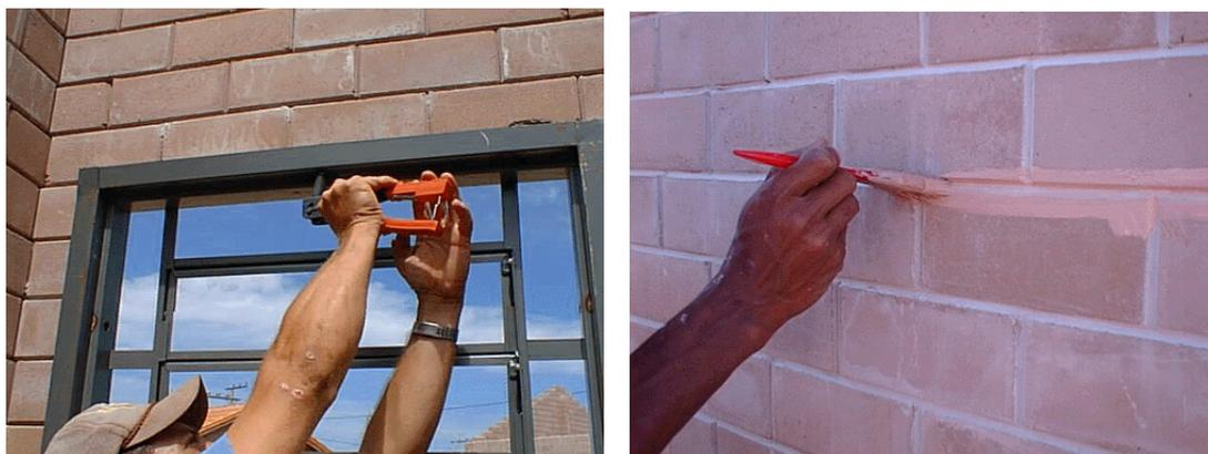
Figura 13 – Detalhe das esquadrias e acabamento do sistema Tijolito
