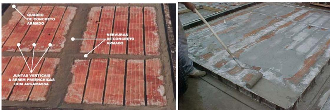
Figura 33 – Concretagem das nervuras e aplicação do chapisco rolado nos painéis Jet Casa
