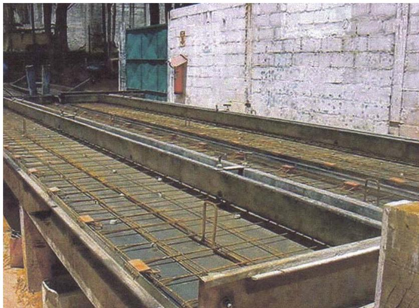
Figura 42 – Armaduras das lajes nervuradas com ganchos de içamento
