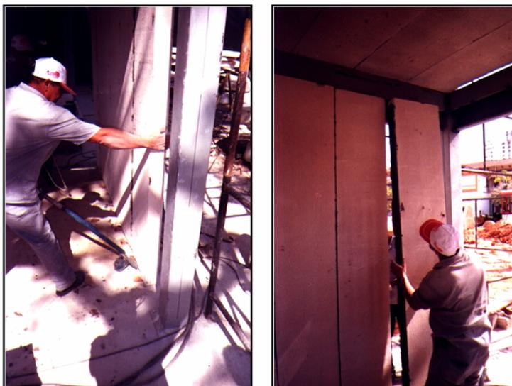
ASSENTAMENTO PAINEL DE VEDAÇÃO. UNIÃO ENTRE PAINÉIS COM APLICAÇÃO DE ARGAMASSA COLANTE TIPO ACIII
