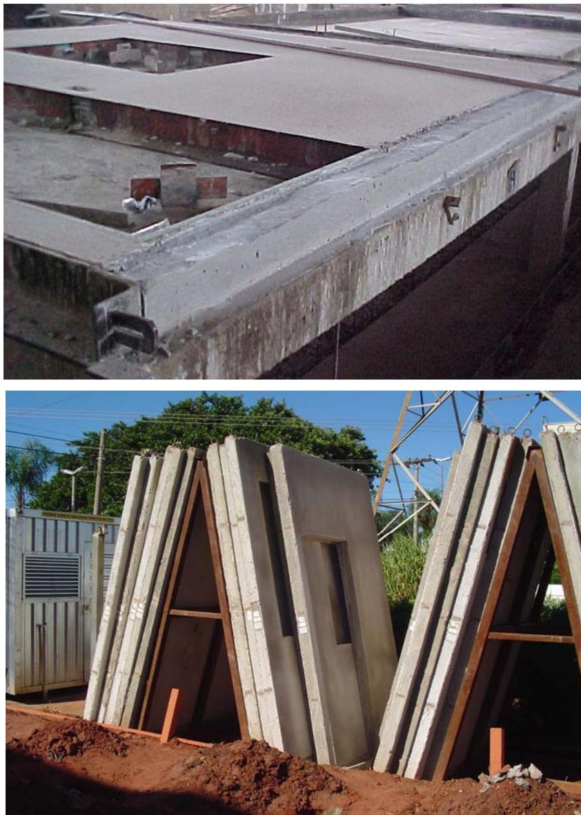
Figura 34 – Impermeabilização da base dos painéis Jet Casa e disposição para montagem
