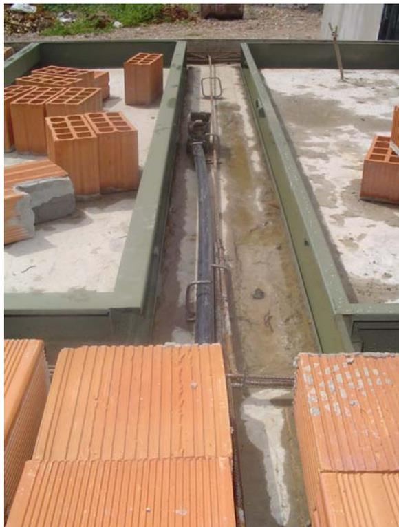
Figura 32 – Forma para montagem de painel Jet Casa com batente e tubulação elétrica
