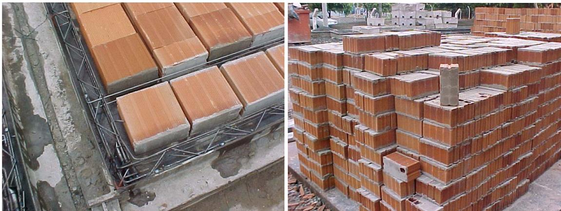
Figura 25 – Camada de argamassa dos blocos dos painéis Jet Casa
