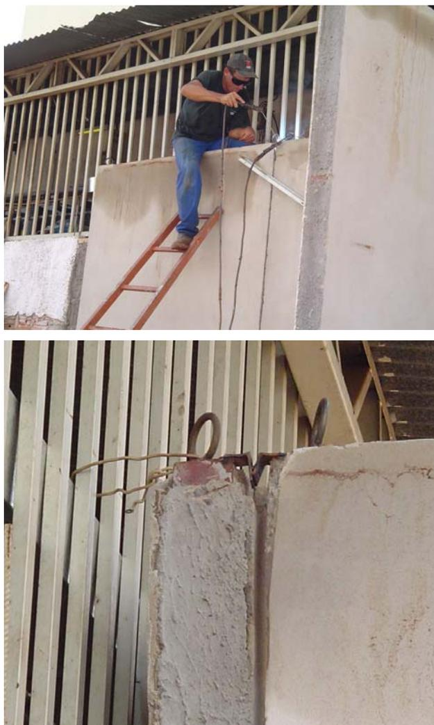
Figura 39 – Soldagem das cantoneiras de ferro localizadas na parte superior dos painéis
