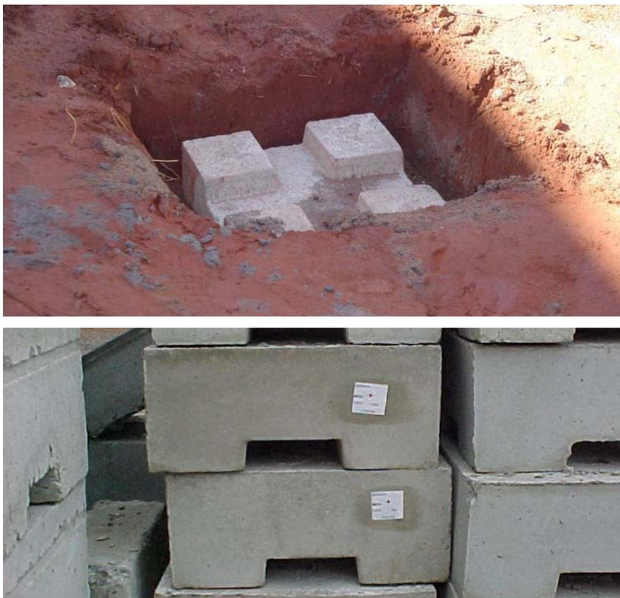
Figura 35 – Blocos de fundação pré-moldados do sistema Jet Casa
