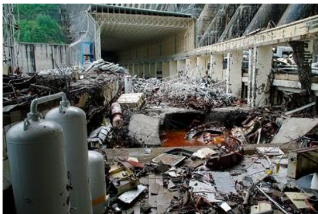
Figura 2.2 – Explosão de uma turbina na usina de Sayano Shushenskaya (MAESTRI, 2011).
