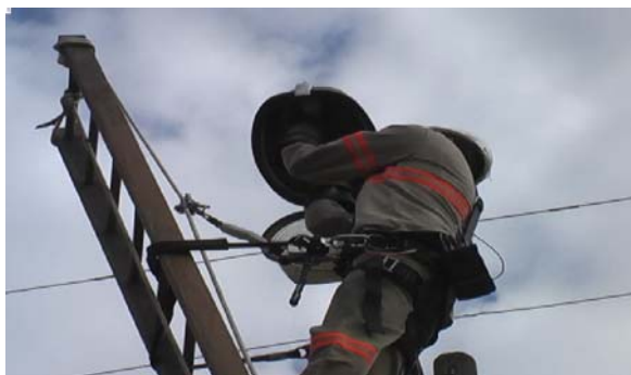
Figura 6: Substituição de lâmpadas no poste de Iluminação pública.
