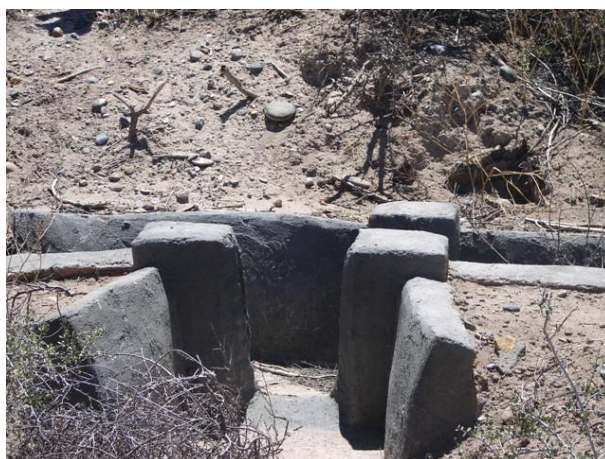
Fotografia 08. Cruzamento de acéquijs em pedra, construído na década de 1930. Fotografia produzida pela pesquisadora, janeiro/2007.
