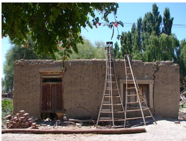
Fotografia 21. Antiga casa dos trabalhadores. Fotografia produzida pela pesquisadora, janeiro/2007.
