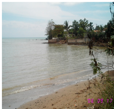
Foto 15 – Destruição da passareira por erosão costeira. Fonte: SANTANA, 2010b:8/9.
