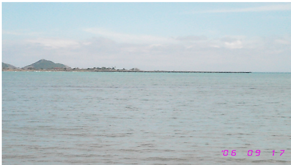
Foto 16 - Aeroporto internacional de STP – prolongamento da pista para o mar. Fonte: SANTANA, 2010b:8/9.
