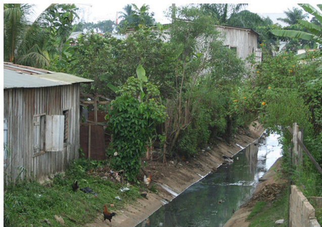
Foto 24 - Esgoto jogado em canal aberto ao lado das residências, o que contribui para a adição dos riscos sanitários às famílias ali residentes. Fonte: http://viagemstomeprincipe.blogspot.com .
