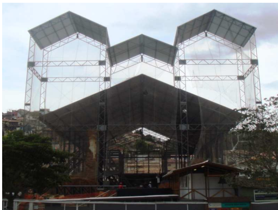
Figura 15 – Obras de reconstrução da Igreja Matriz em março de 2013
