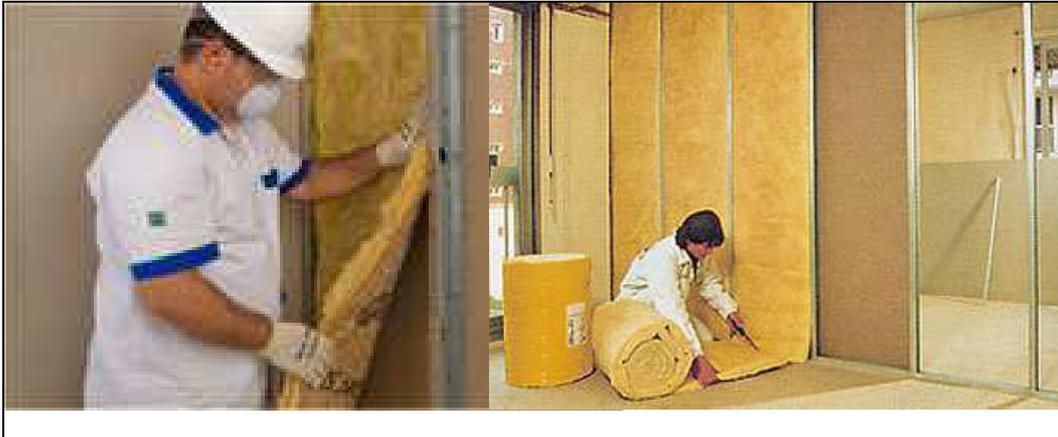
Figura 2.20 Isolamento termoacústico à base de lã de vidro [89]
