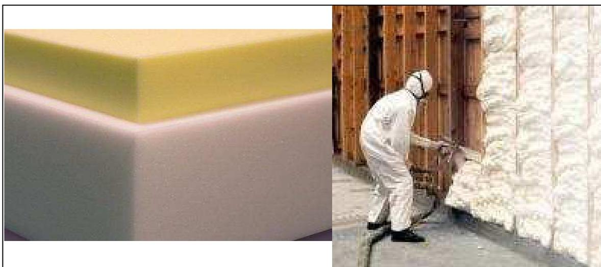
Figura 2.17 Placa de poliuretano e aplicação de poliuretano expandido [87]
