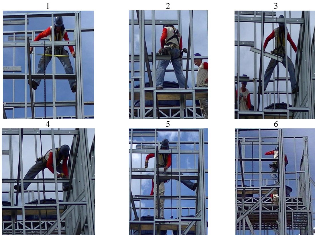
Figura 42 - Sequência de etapas - Execução das estruturas de cobertura - Montador C
