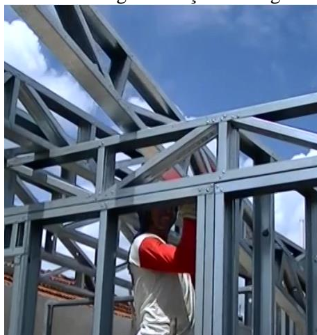
Figura 34 - Levantamento de carga - Fixação das vigas de piso - Montador C
