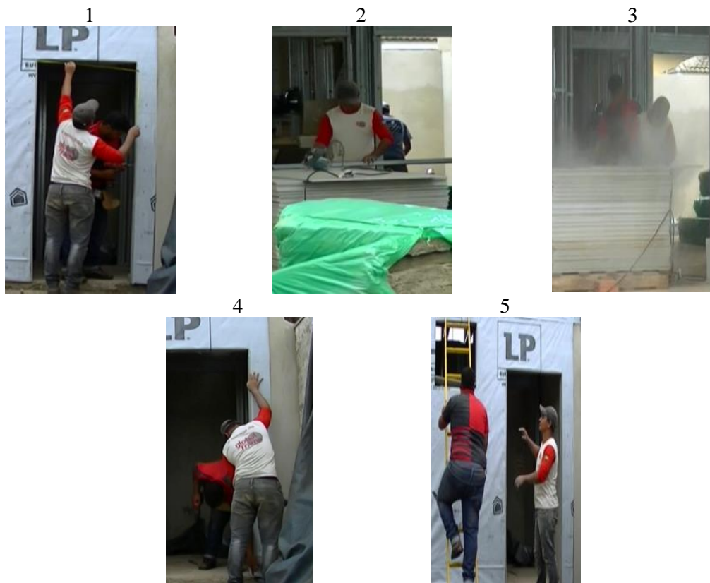
Figura 47 - Sequências de etapas - Plaqueamento externo com placa cimentícia - requadros - Montador A
