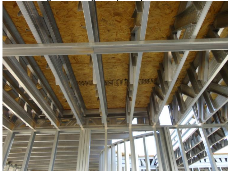
Figura 11 - Vigas de piso e placas de OSB
