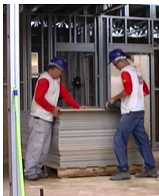
Figura 46 - Risco de acidente - Plaqueamento externo com placa de OSB - Montador B e Ajudante B.
