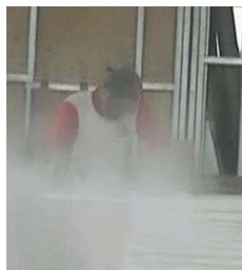
Figura 49 - Risco de acidente - Plaqueamento externo com placa cimentícia - requadros - Montador A
