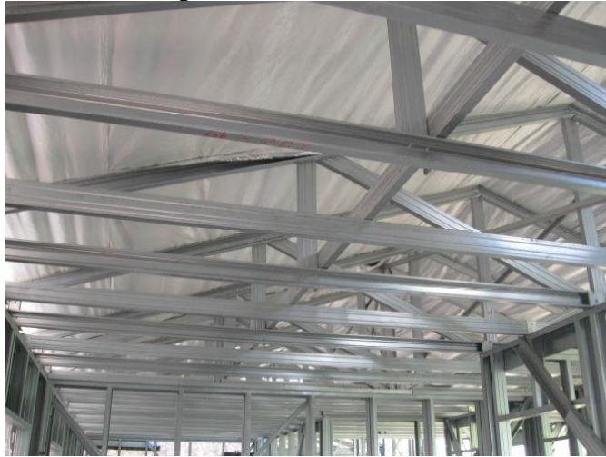
Figura 14 - Telhado em LSF
