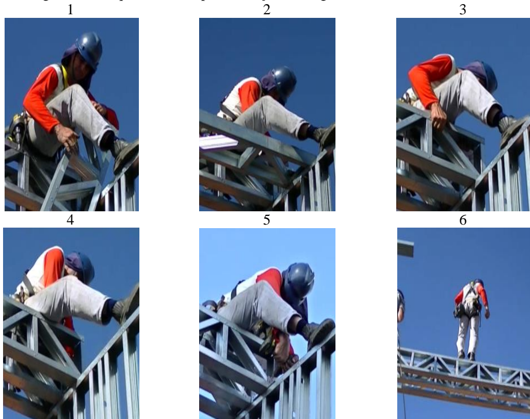
Figura 37 - Sequência de etapas - Fixação das vigas de cobertura - Montador C
