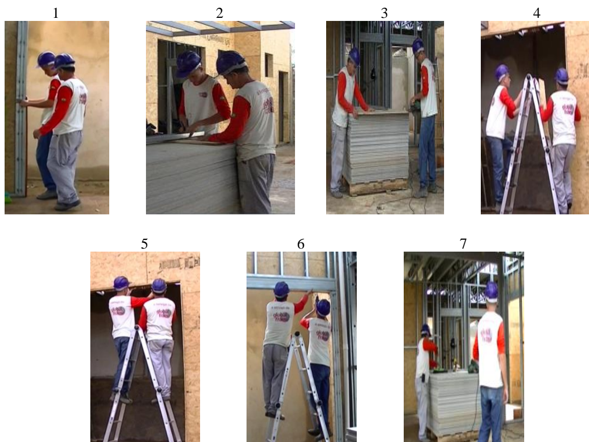
Figura 43 - Sequência de etapas - Plaqueamento externo com placa de OSB - requadros - Montador B e Ajudante B
