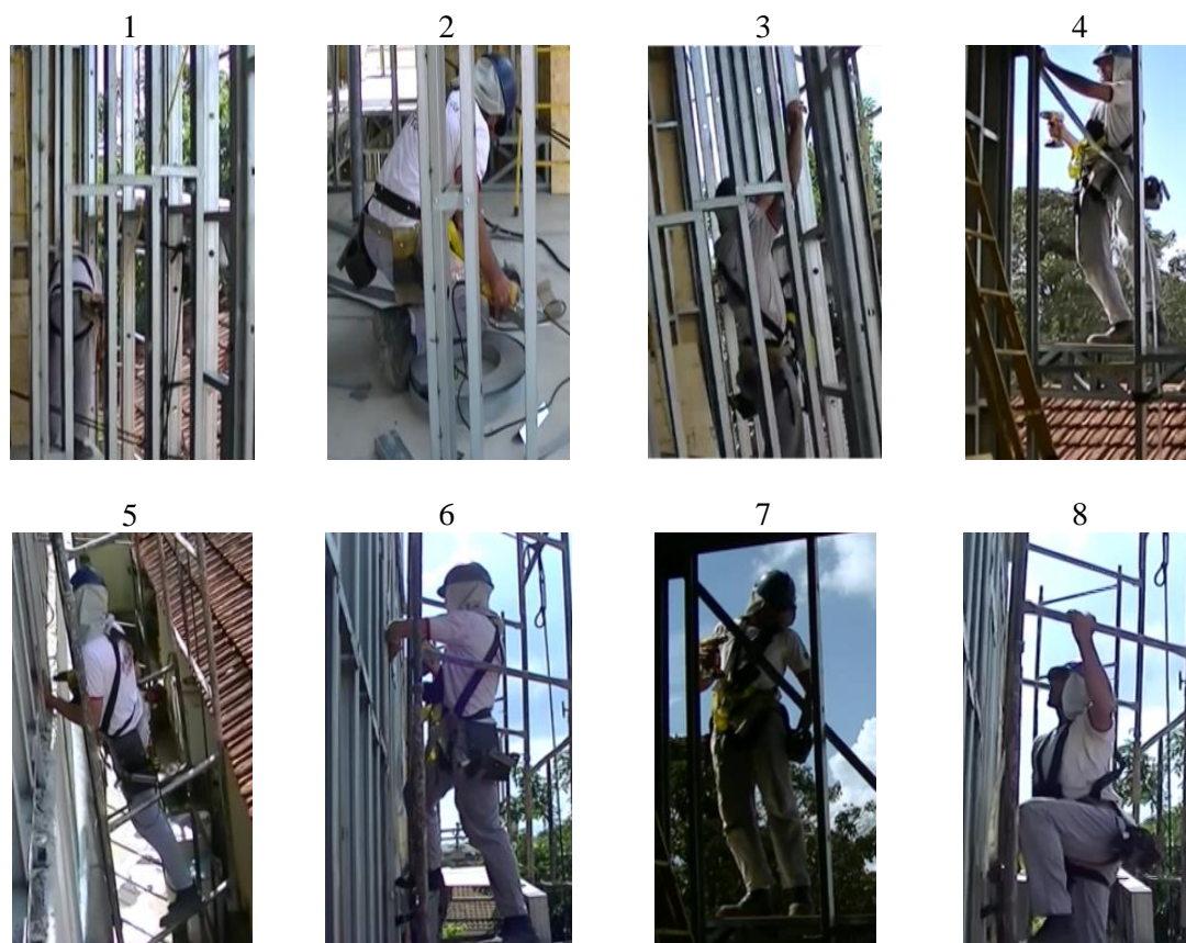
Figura 40 - Sequência de etapas - Contraventamento - Montador C
