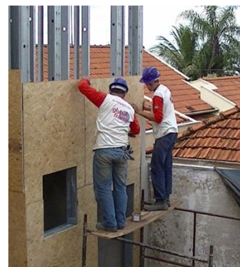
Figura 46 - Risco de acidente - Plaqueamento externo com placa de OSB - Montador B e Ajudante B.
