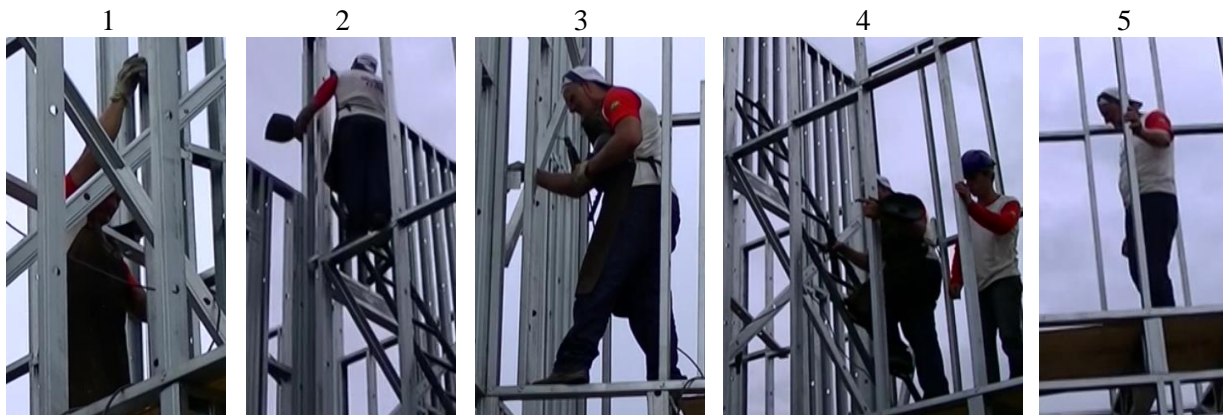
Figura 35 - Sequência de etapas - Fixação dos painéis do 1º pav. - soldagem – Encarregado
