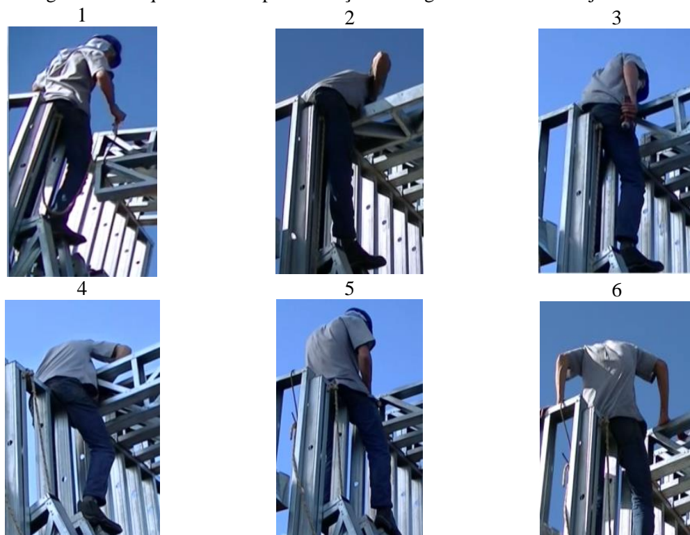
Figura 38 - Sequência de etapas - Fixação das vigas de cobertura - Ajudante A
