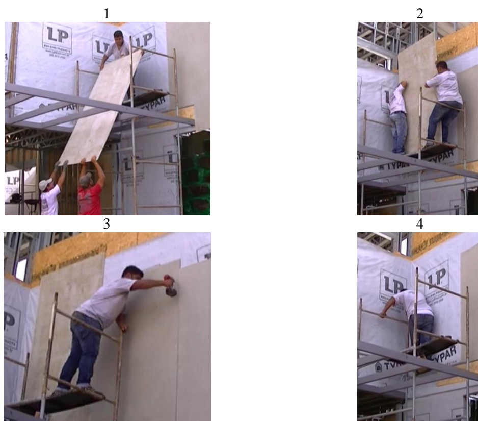
Figura 50 - Sequência de etapas - Plaqueamento externo com placa cimentícia - Ajudante D
