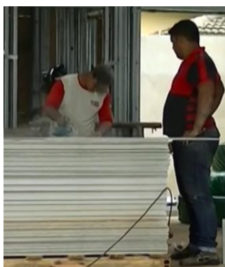
Figura 49 - Risco de acidente - Plaqueamento externo com placa cimentícia - requadros - Montador A
