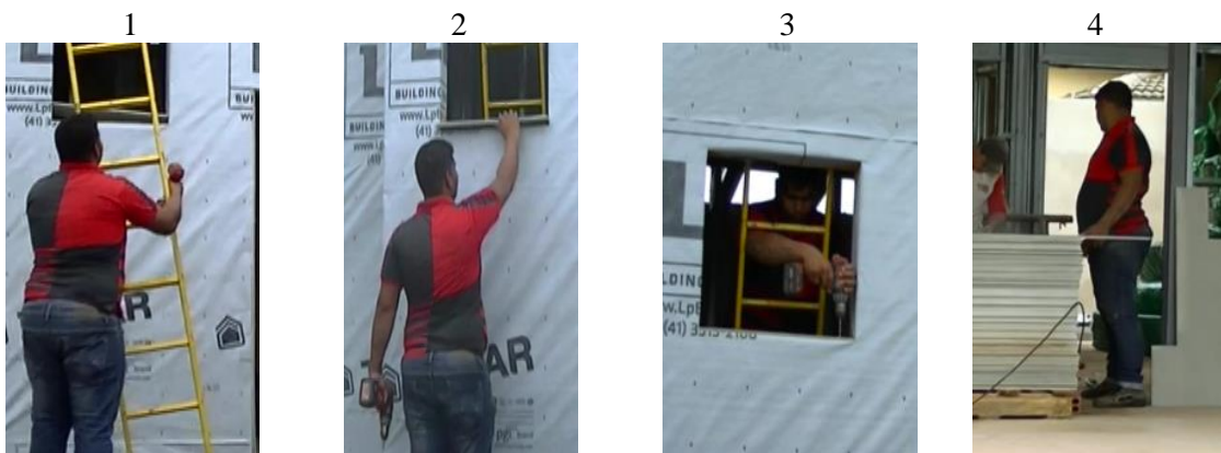
Figura 48 - Sequência de etapas - Plaqueamento externo com placa cimentícia - requadros - Ajudante D
