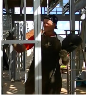
Figura 31 - Levantamento de carga - Fixação dos painéis do térreo - soldagem - Encarregado
