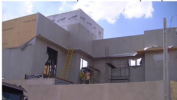
Figura 26 - Fachada externa com placa cimentícia sobreposta à placa de OSB
