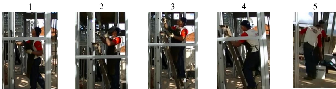
Figura 30 - Sequência de etapas - Fixação dos painéis do térreo - soldagem – Encarregado
