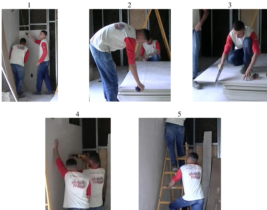
Figura 51 - Sequência de etapas - Plaqueamento interno de gesso acartonado - Montador B
