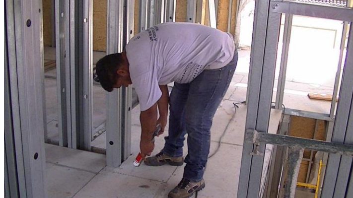
Figura 25 - Execução do tratamento de juntas do Masterboard
