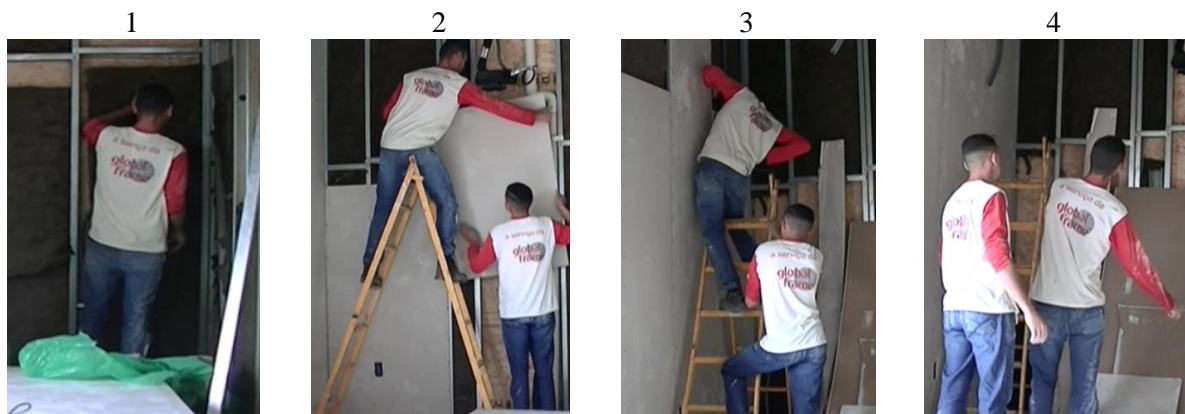
Figura 52 - Sequência de etapas - Plaqueamento interno com placa de gesso acartonado - Ajudante A
