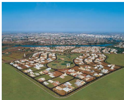
Figura 80 – Vista aérea dos empreendimentos Damha em São José do Rio Preto
