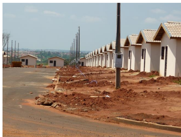
Figura 54 – Vista do Parque Residencial Nova Esperança em fase de construção
