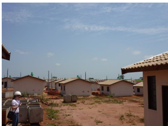
Figura 53 – Vista do Parque Residencial Nova Esperança em fase de construção
