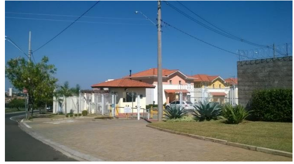
Figura 67 – Guarita de entrada do Residencial Orizzonti di São Carlos I em São Carlos
