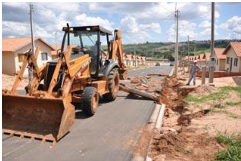
Figura 40 – Pavimento em manutenção no Jardim Zavaglia em São Carlos
