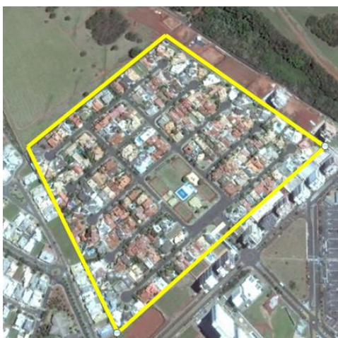
Figura 82 – Implantação do empreendimento Parque Faber I em São Carlos
